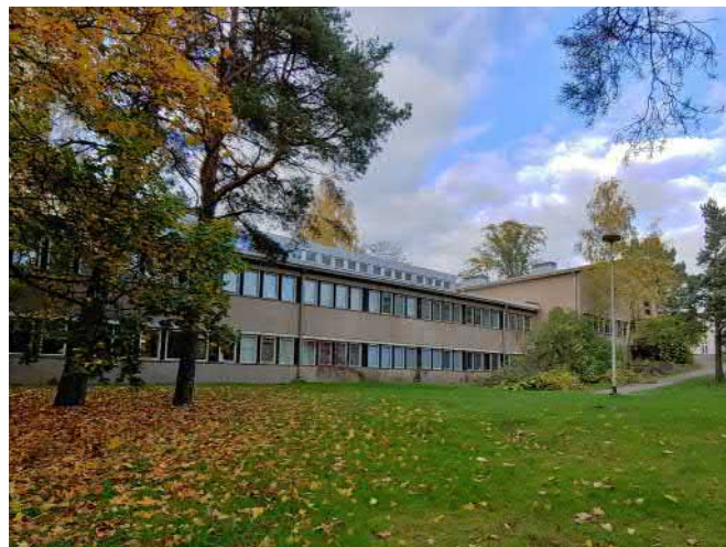
Rakennuksen eteläjulkisivu sairaalapuutarhan suunnasta.
