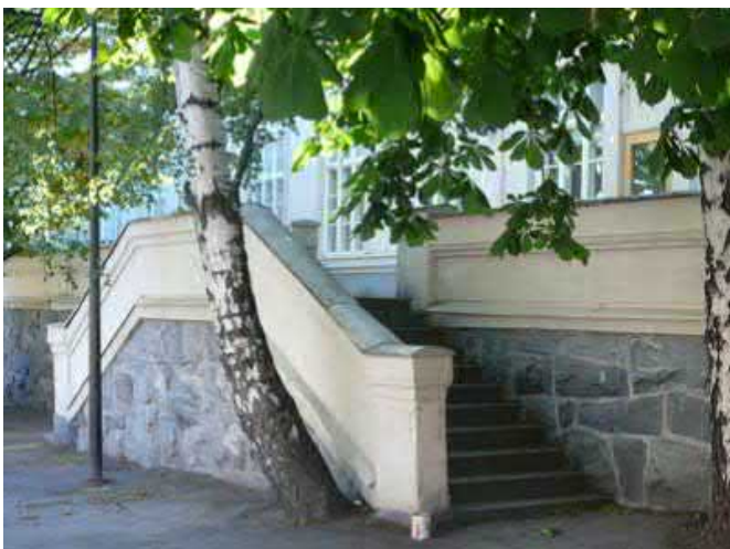
Mm. makuuterassien sokkelit ja topografialtaan vaihtelevan alueen muiden tasoerojen tukimuurit on rakennettu graniittilohkareista. (kuva: LOCI maisema-arkkitehdit Oy ja Taegen arkkitehdit Oy)
