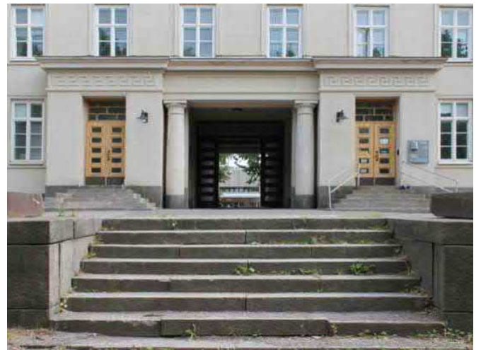
Rakennuksen keskellä läpikäytävä (osa historiallista keskiakselia) (kuva: Arkitehtitoimisto Freese Oy).
