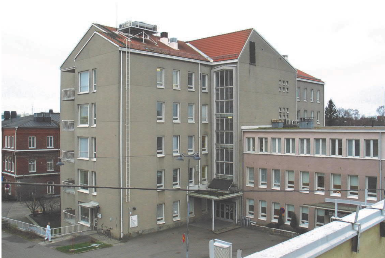
Keskusrakennus sairaalapihan puolelta v. 2011. Vesikatolle on asennettu ilmanvaihtolaitteita. B-siiven 3. kerroksen terassi on rakennettu umpeen 1990-luvulla. Pääportaan ulko-oven eteen on 1980-luvulla rakennettu katos. MS.
