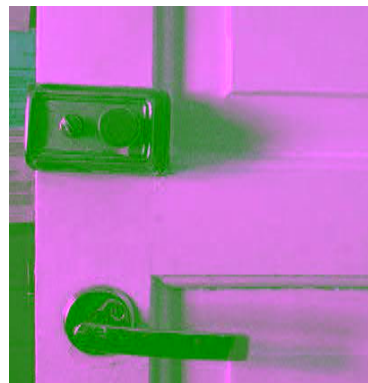
Tilan 16 ovi, heloitusta muutettu useita kertoja
