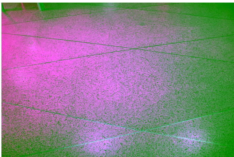
Alkuperäinen messinkilistoin jaettu mosaiikkibetonilattia. MS 2011
