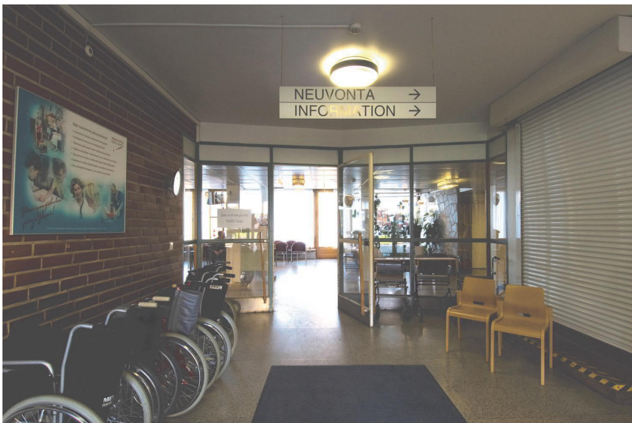
Tuulikaappi, 1. kerros. Avoportaasta eteen on asennettu rulooseinä. Alakaton otsapinta peittää lasiseinän yläosan. Kari Hakli 2011
