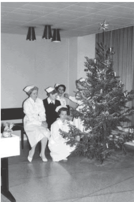
1950-luvun tunnusomaisia yksityiskohtia ovat rei'itetystä kipsilevystä tehty alakatto, kartiomaiset valaisimet ja mosaiikkibetonilattia messinkilistoilla. Valokuva HKM
