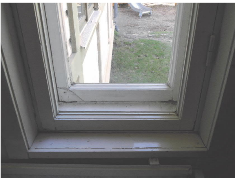
Vanhempi ikkuna, huone 8. Puitteissa on 1900-luvun vaihteelle tyypillinen tulppaani-profiili. Ikkuna on todennäköisesti siirretty vanhan ulko-oven vierestä.
