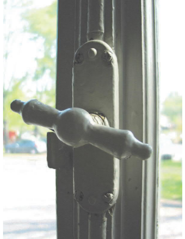
Ikkunapainikkeet ja pitkäsulkija , huone 04
