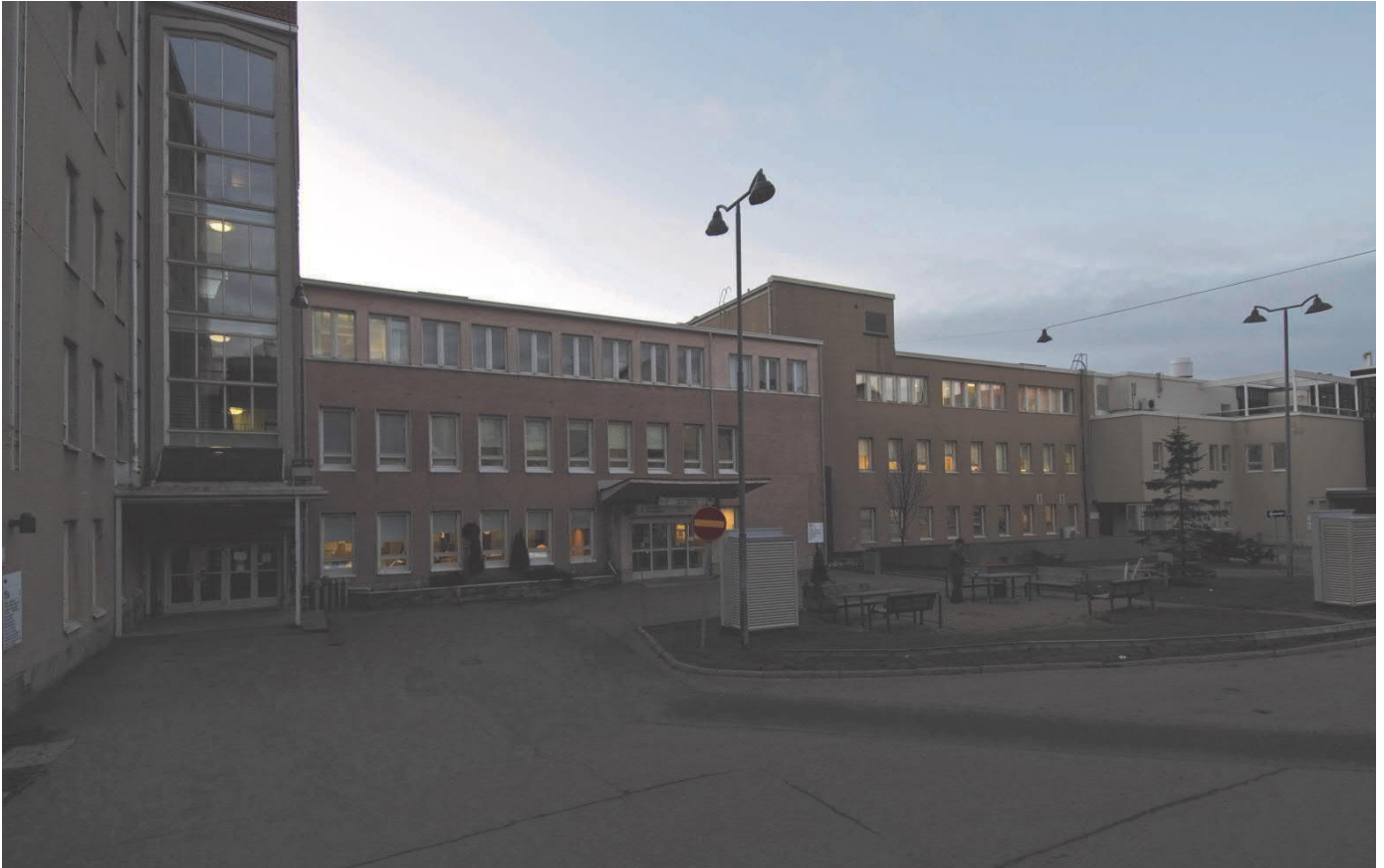
Näkymä idästä sisäpihan puolelta. Porrashuoneen ulko-oven eteen on rakennettu katos 1980-luvulla. Pohjoissiiven kolmannen kerroksen terassi on muutettu sisätilaksi 1990-luvulla. Ikkunat on uusittu. Pohjoispuolelle on rakennettu laajennusosia kahdessa vaiheessa vv. 1987-1992. Kari Hakli 2011
