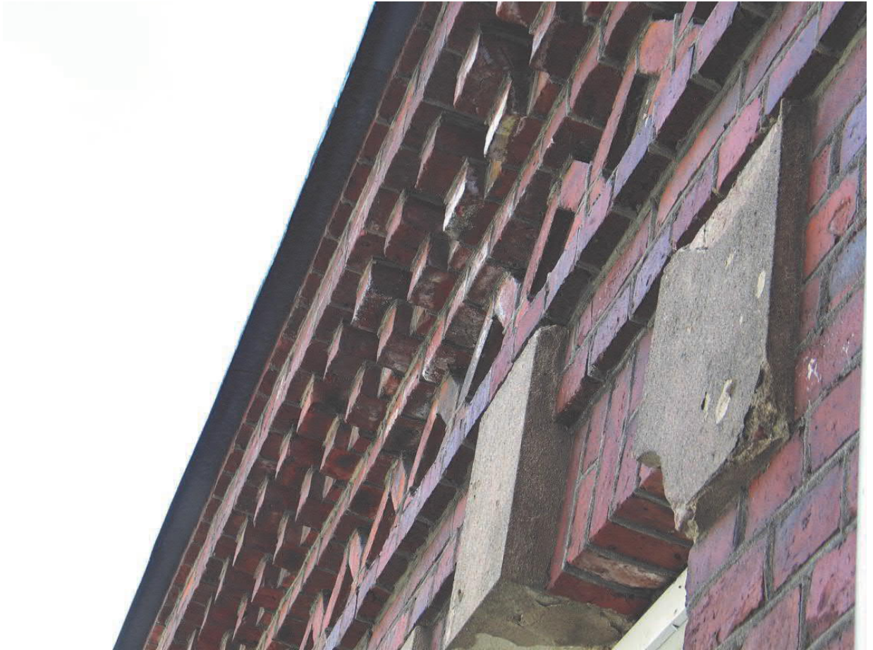
Pohjoissivun kolmannen kerroksen yksityiskohta vuodelta 1898. Taidokkaasti muuratun, ulkonevan kattolistan yksityiskohta hammaslistoineen ja vinoneliökuvioineen.
