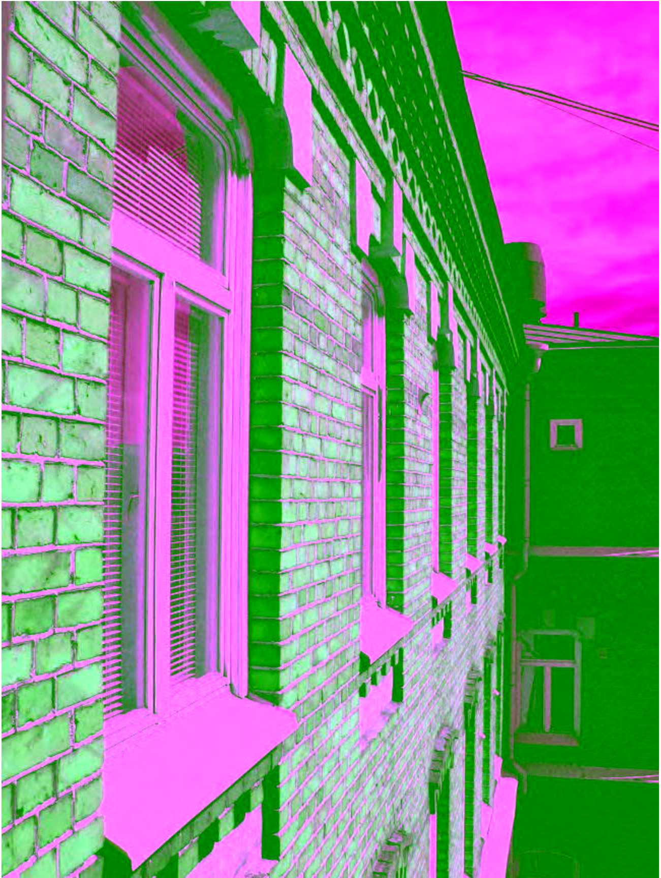
Ikkunasovitus, 3 kerroksen eteläisivu. Asuntoja sisältävä keskiosa on rakennettu vuonna 1898. Ikkunat ja pellitykset on uusittu.
