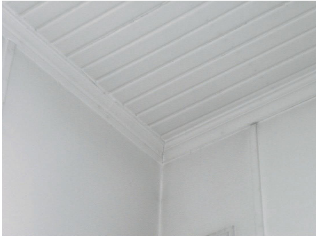
Maalattu ponttipaneelikatto pyöristetyllä reunalla ja profiloitu kattolista ovat mahdollisesti 1900-luvun alusta.
