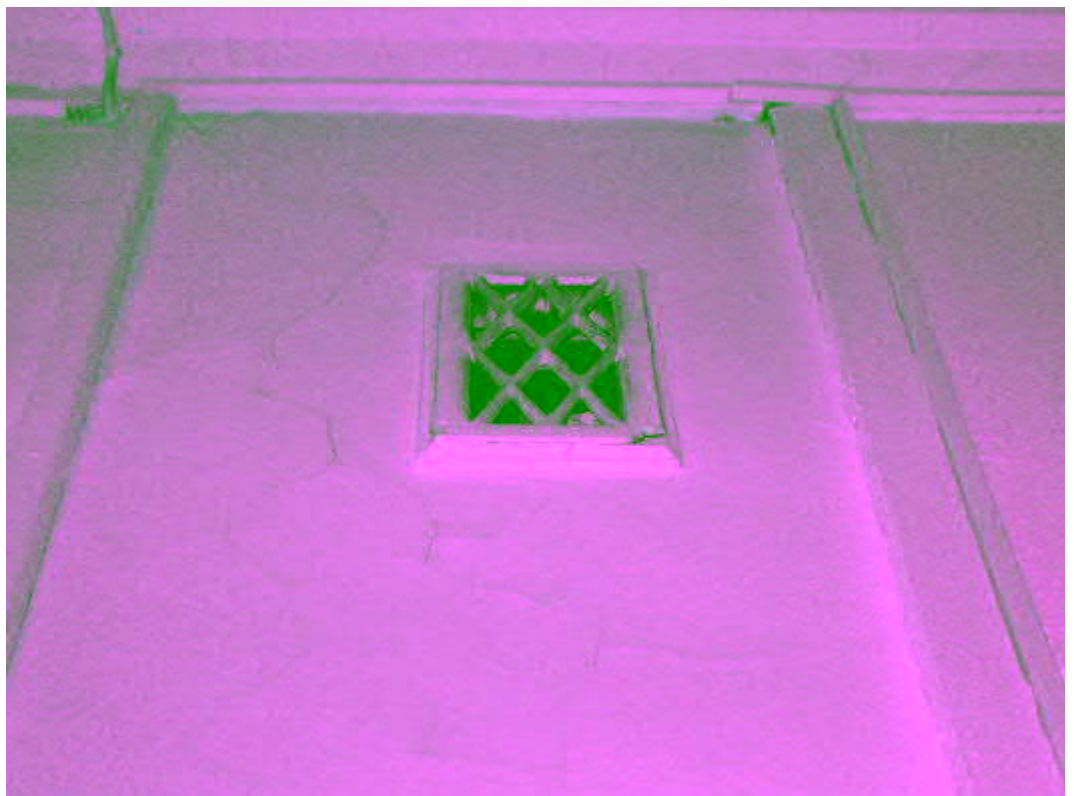
Vanha ilmanvaihtosäleikkö on asennettu profiloituun kehykseen.
