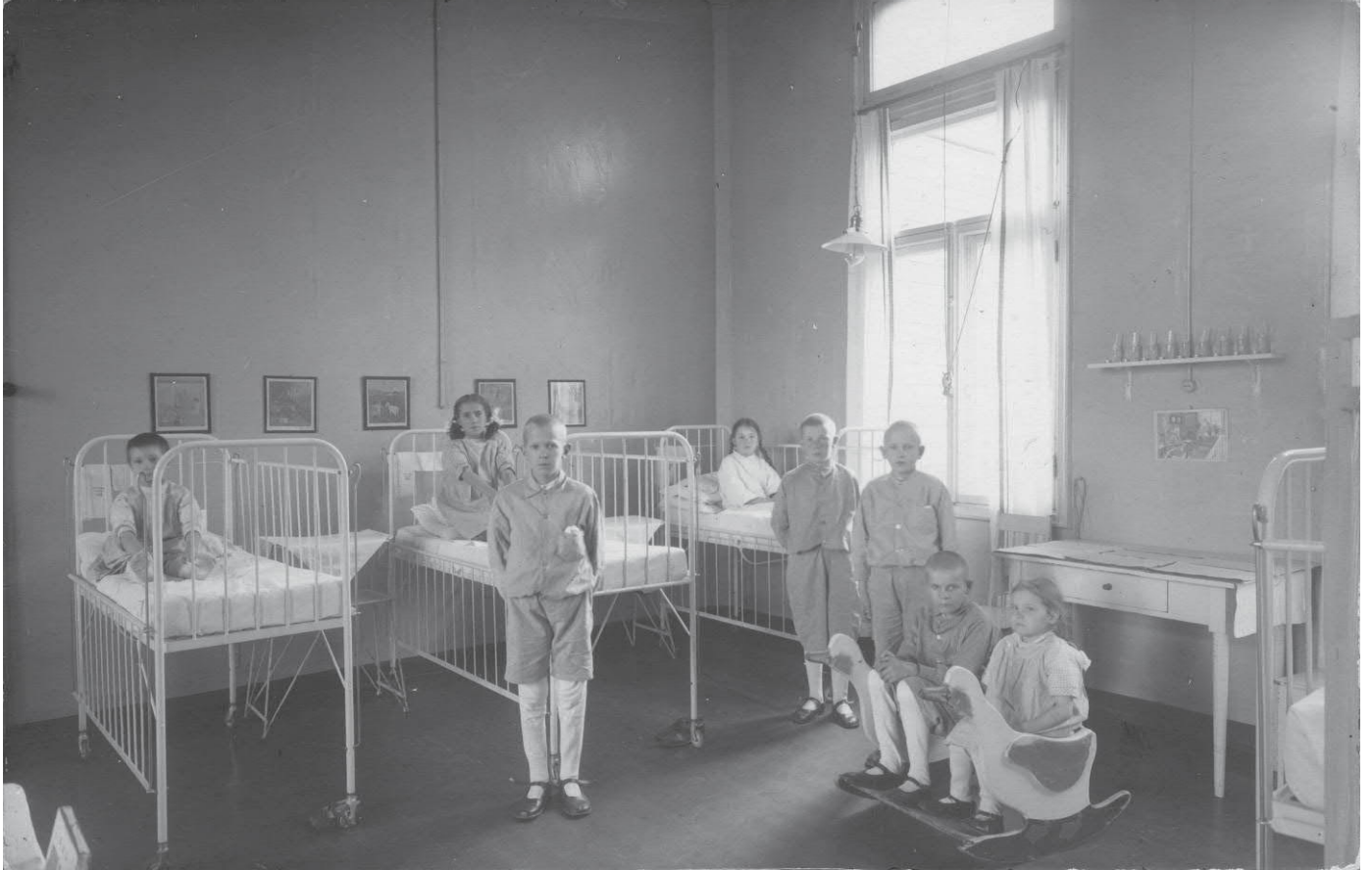
Valokuva esittää mahdollisesti lastenosastoksi muutettua kulkutautisairaalan potilassalia varhain 1900-luvulla. Oikealla näkyy ns. terveysikkuna, jonka tuuletusikkuna on vaakavälikarmin yläpuolella. HYM
