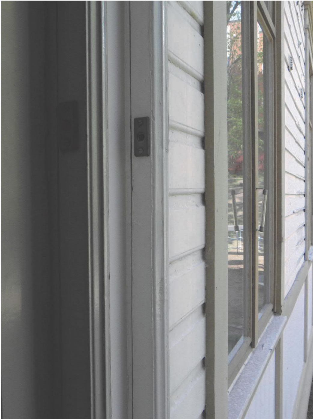
Julkisivun yksityiskohta: profiilihöylätty vaakaponttilauta.
