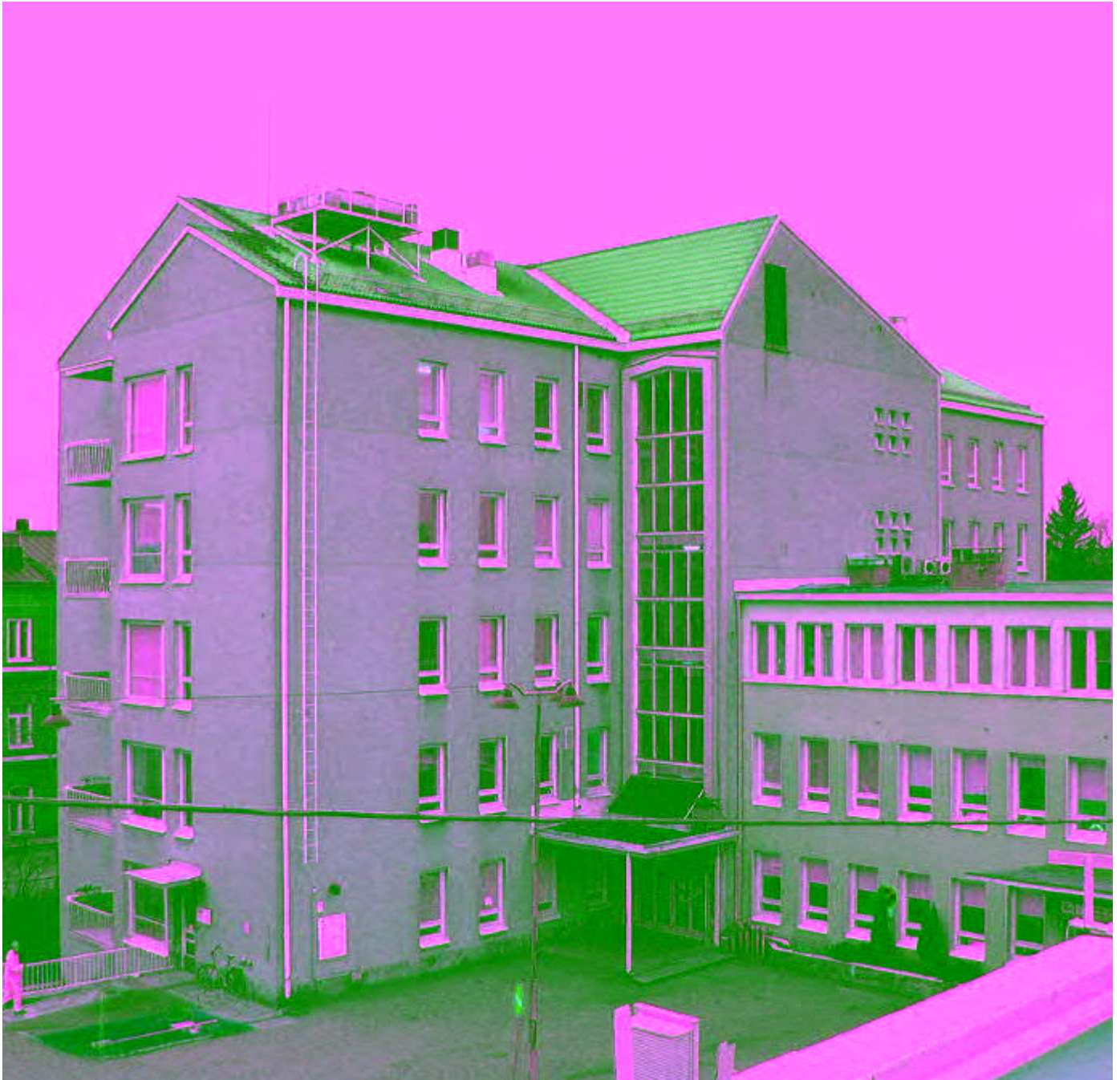
Näkymä koillisesta. Katolle on asennettu ilmanvaihto- ja jäähdytyslaitteita. Ikkunat on uusittu ja huoneiden ikkunat on varustettu alaosan tuuletusikkunalla. MS 2011
