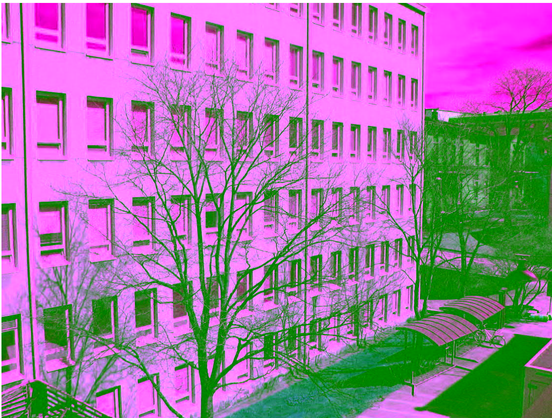
Näkymä lounaasta kohti A-siiven eteläsivua. MS 2011 Ikkunat on uusittu ja niihin on lisätty tuuletusikkuna.
