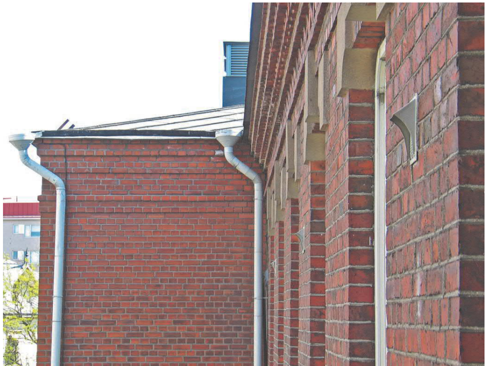
Vesikatteena on saumattu, maalattu peltikate. Räystäällä on jalkarännit. Syöksytorvet on varustettu perinteisillä suppiloilla.
