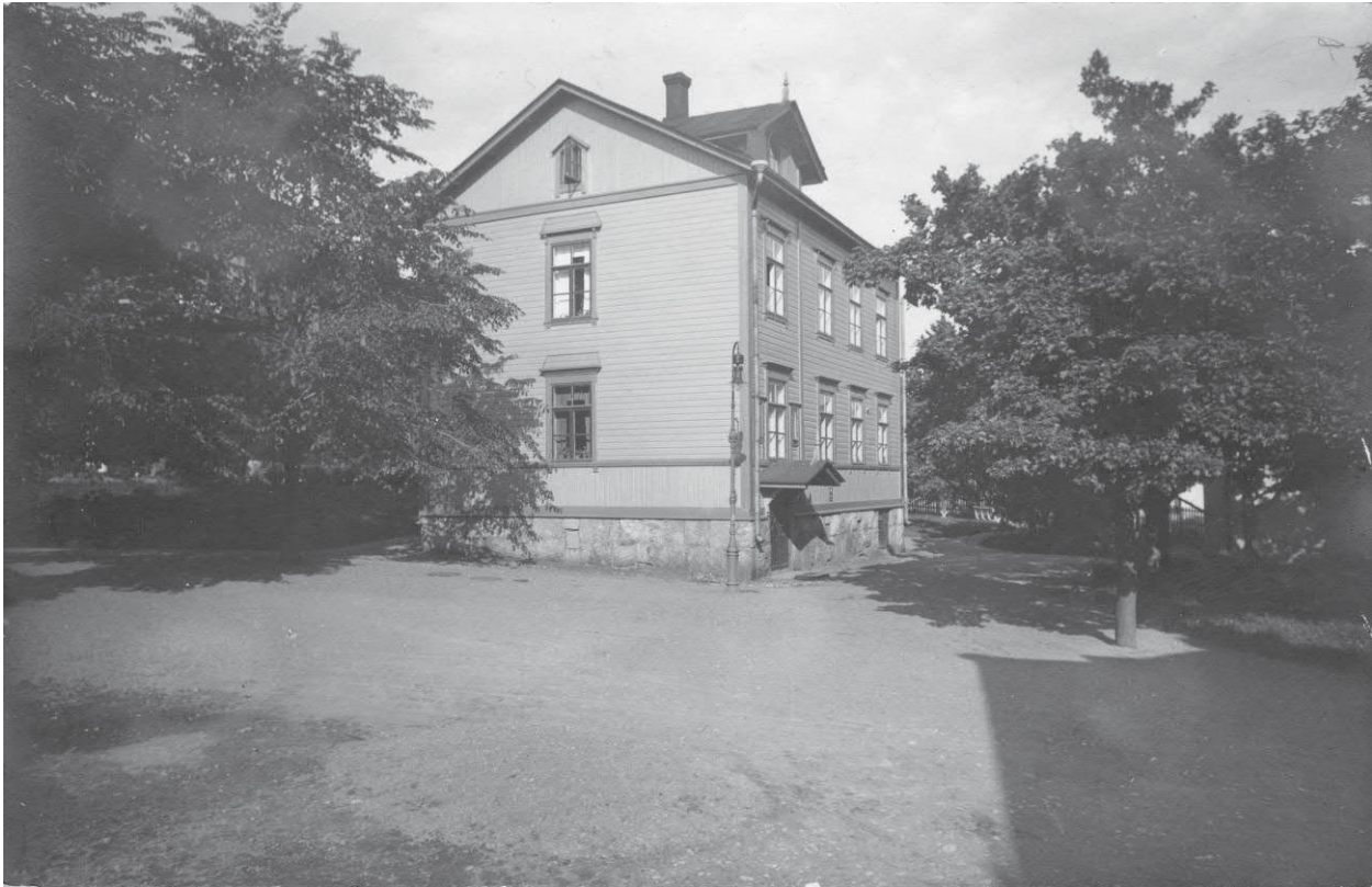
Rakennus 14 kuvattuna lounaasta 1920-30-luvulla. HYM Päätyikkunoiden ikkunakehyksen yläosassa näkyy myöhemmin kadonnut, erikoinen yksityiskohta. Ikkunapuitteet ja vuorilaudat on maalattu julkisivupintaa tummempaan sävyyn.
