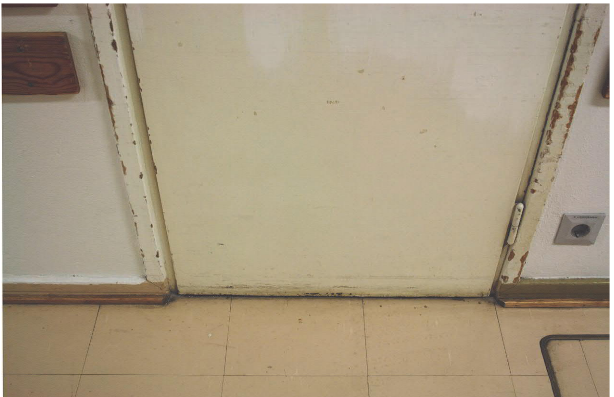
Käytävän yksityiskohta, 4. kerros. Säilynyt 1950-luvun yksityiskohta: jalkalista ja ovilista on yhdistetty jiiriiliitoksella. MS 2011
