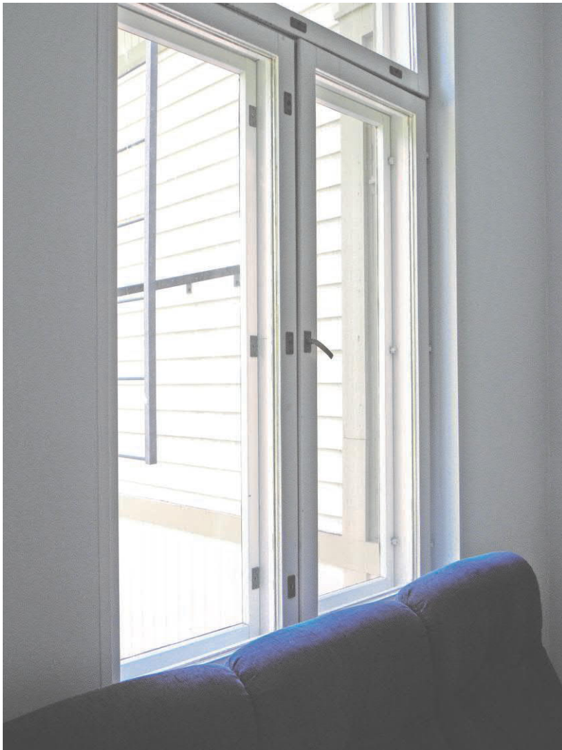
Uusittu ikkuna, huone 2 Sisäpuitteessa on umpiolasi.
