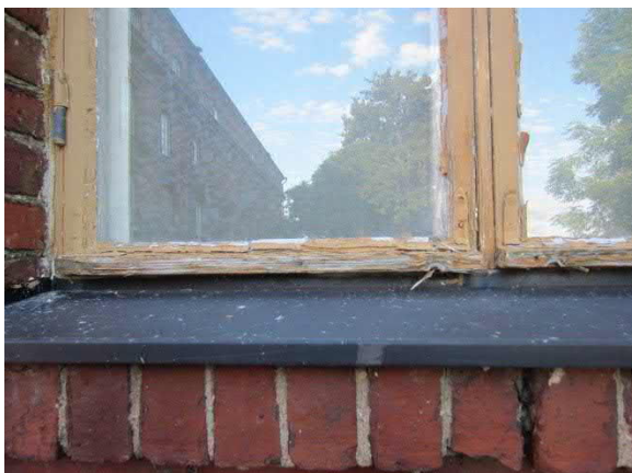
Kuva 52. Ikkunat ovat heikossa kunnossa ja vaativat kunnostusta
