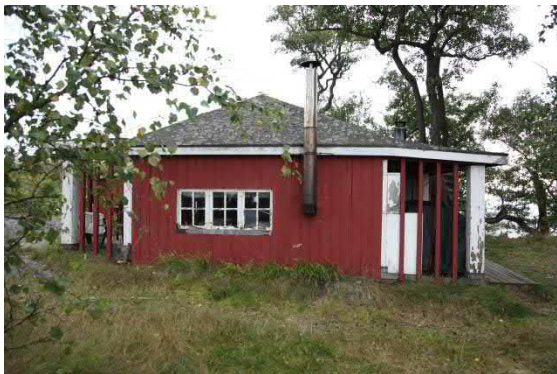
Kuva 307. Rakennuksen julkisivu pohjoiseen.
