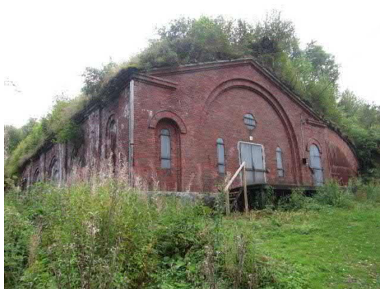
Kuva 147. Tiiliverhouksen kalkkihärme ja peitekasvillisuus, räystäslinjalla lieviä rapautumisvaurioita.
