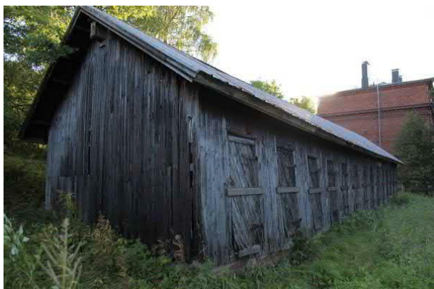
Kuva 55 Rakennuksen julkisivu etelään ja itäpääty
