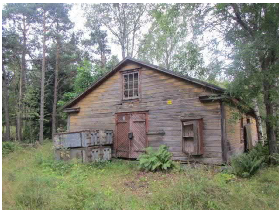
Kuva 210. Rakennuksen julkisivu koilliseen.
