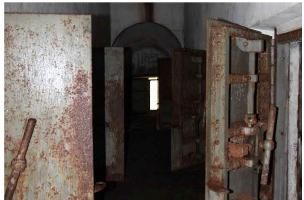
Kuva 163. Näkymä keskuskäytävältä josta käynti varastoihin
