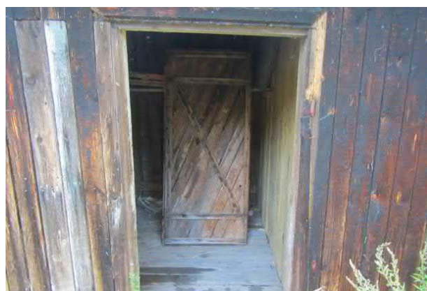
Kuva 58 Etelän puolen varastokoppi
