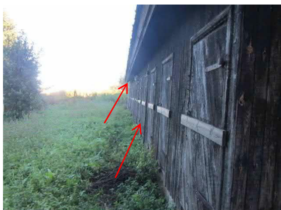
Kuva 59. Rakennus on kallistunut
