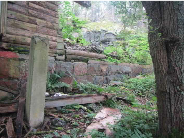
Kuva 250. Mahdollisesti säilytettävä lohkokiviperusmuuri.
