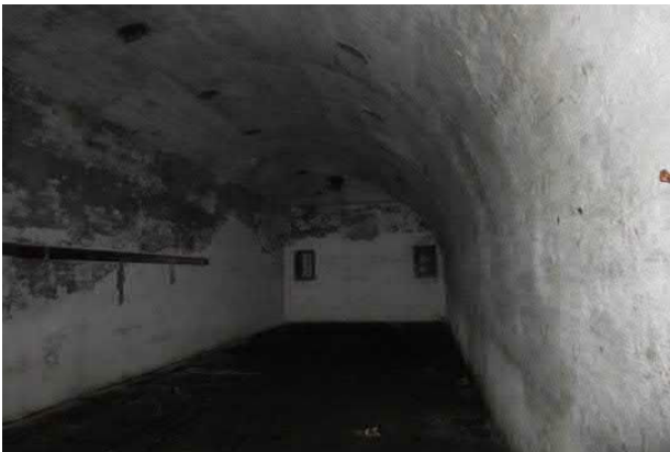
Kuva 162. Näkymä varastoja kiertävästä sivutilasta
