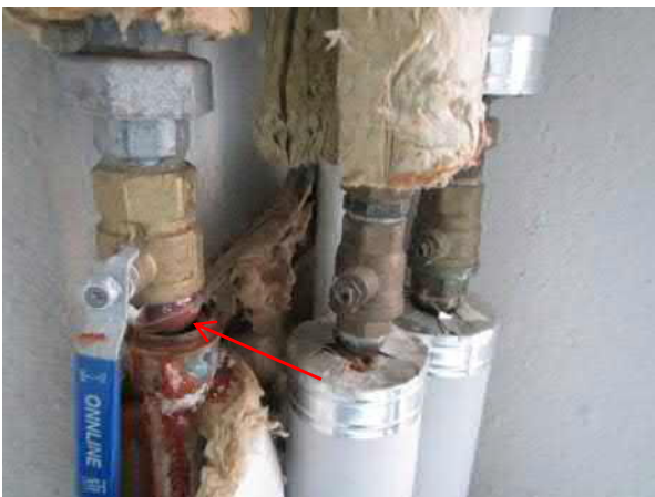
Kuva 44. Rakennus A2. Vesijohdot tulevat rakennuksesta A1 kaivannossa. Ne ovat poistettu käytöstä ja uusimiskunnossa.
