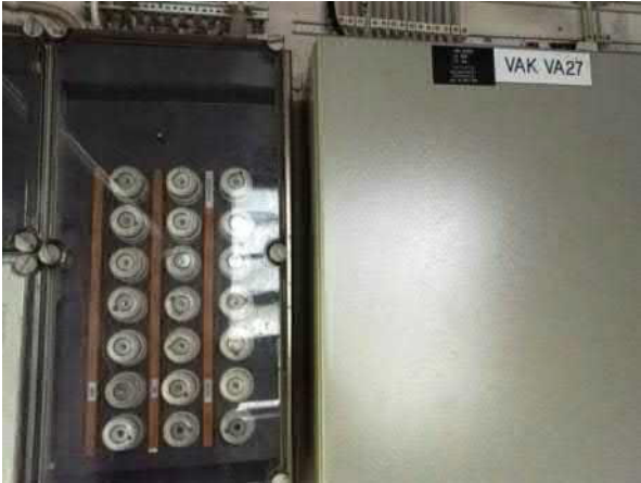
Kuva 194. Rakennus 27. Lämmityksen toimintaa ohjaa valvonta-alakeskus VA27.
