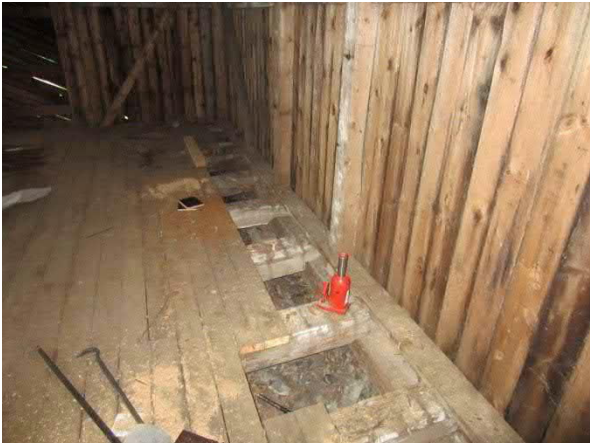
Kuva 183. Lattiarakenne on aukaistu ja tunkkaustyöt aloitettu
