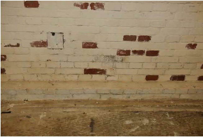
Kuva 171. Sisäpinnan tiiliverhouksessa kalkkikerros tiilien päällä
