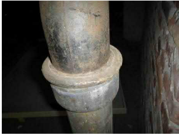
Kuva 43. Rakennus A1. Viemärit ovat muhwillista valurautaa.
