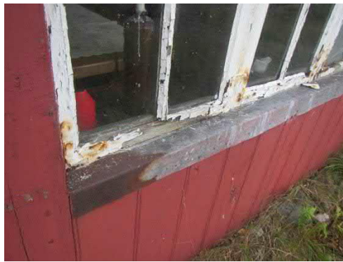
Kuva 308. Vaurioita ikkunarakenteissa.
