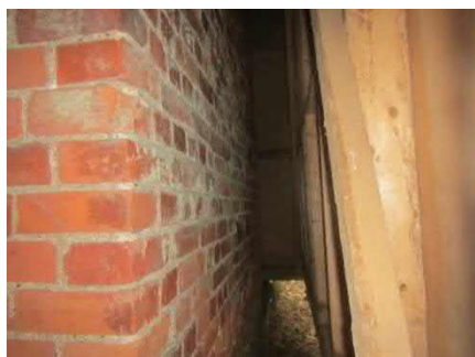
Kuva 294. Rakennuksen tiilijulkisivua suojarakenteen alla
