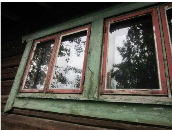
Kuva 126. Ikkunat ovat heikossa kunnossa.
