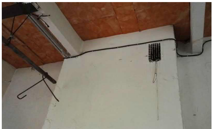
Kuva 202. Sisäpuolella katossa villalevyjä, joista voi lähteä villakuituja sisäilmaan
