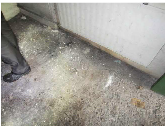
Kuva 82. Lattian betonipinnat ovat kuluneet
