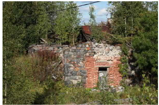
Kuva 158. Näkymä länsipuolen sisäänkäynnistä
