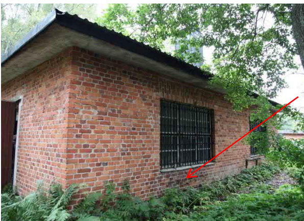
Kuva 201. Ikkunan alapuoliset osat ovat tiiliverhouksen osalta huonossa kunnossa
