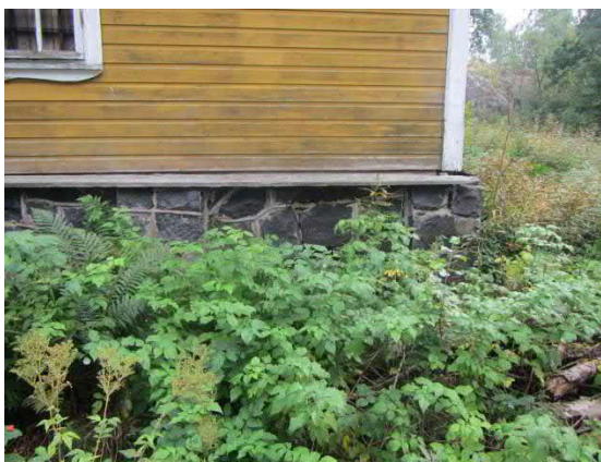
Kuva 154. Perusmuurialueella siirtymiä ja niistä aiheutuneita vaurioita.
