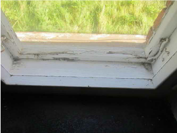
Kuva 95. Rakennuksen ikkunat olivat huonossa kunnossa.
