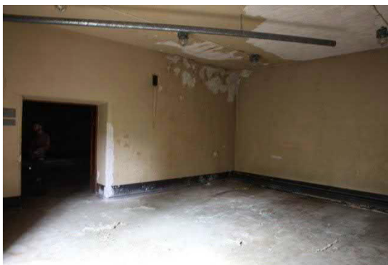
Kuva 275. Sisätiloissa merkittäviä kosteusvaurioita.
