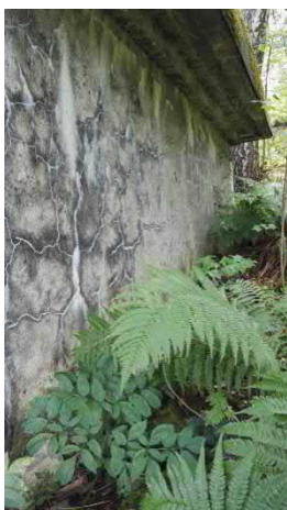
Kuva 320. Rakennuksen länsijulkisivussa olevia halkeamia.
