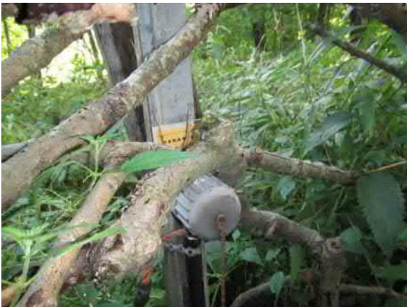
Kuva 140. Rakennus KK. Öljysäiliön ylitäytön estin löydettiin kasvillisuuden seasta, läheltä viereistä tietä. Tämä viittaa siihen, että säiliö on ainakin ollut maassa.
