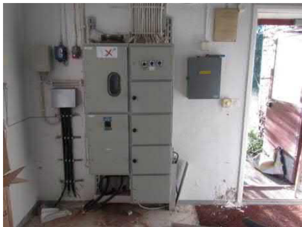
Kuva 45. Rakennus A2. Rakennukseen on tuotu uusi sähkönsyöttö kaapeli ja sähkökeskusta on uusittu osittain 2016.
