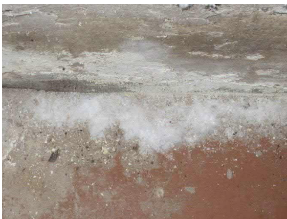
Kuva 109. Kellarin seinissä valkoista kasvustoa
