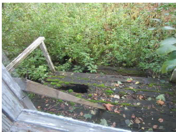
Kuva 66. Ulkoportaot ovat lahonneet ja ne ovat vaaralliset
