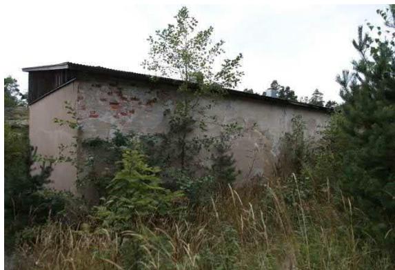
Kuva 292. Pohjoisjulkisivun rappausvaurioita.
