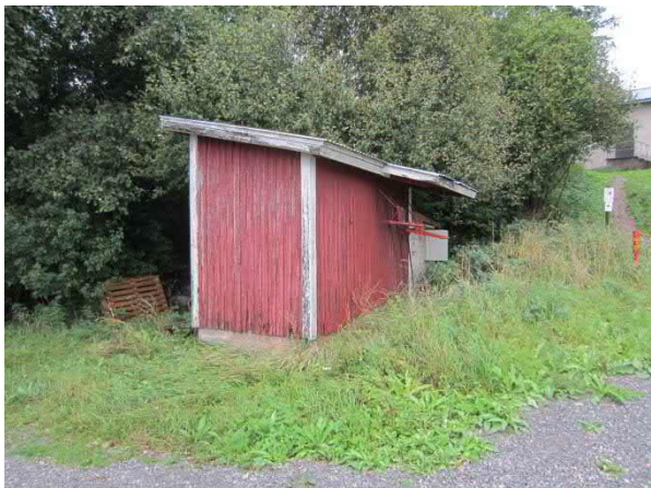
Kuva 228. Julkisivun laudoitus on heikossa kunnossa
