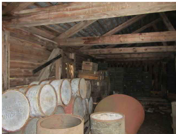
Kuva 211 Seinärunko ja kattorakenteet
