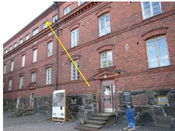
Kuva 39. Rakennuksen yläosa on rakennettu jälkikäteen vuonna 1939
