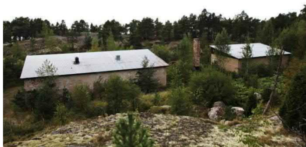
Kuva 271. Rakennukset 25, 26 ja 27 pohjoisesta
