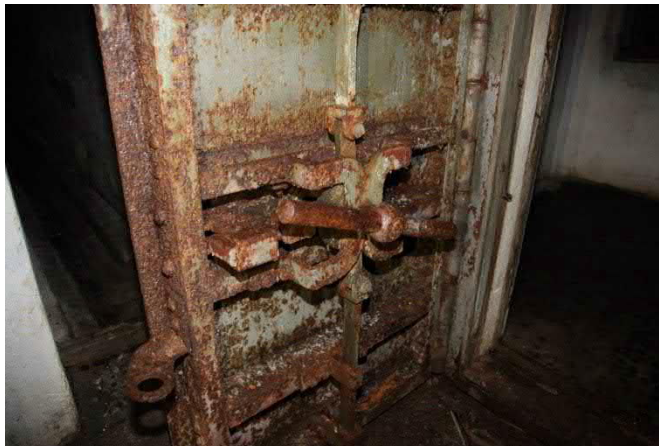
Kuva 166. Sisällä olevat metalliovet ovat ruostuneet
