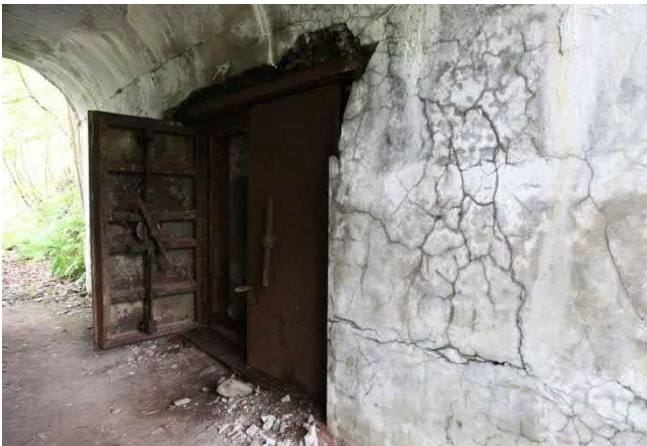
Kuva 165. Sisääntulosuojakaaren betoni on pahasti rapautunut ja halkeillut
