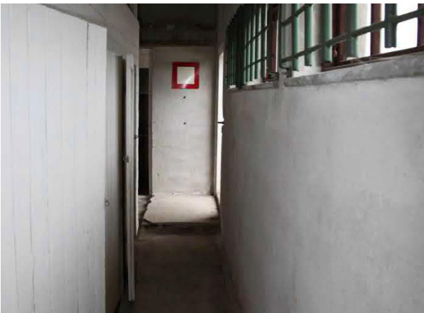
Kuva 222. Näkymä sisältä, kohti pohjoista
