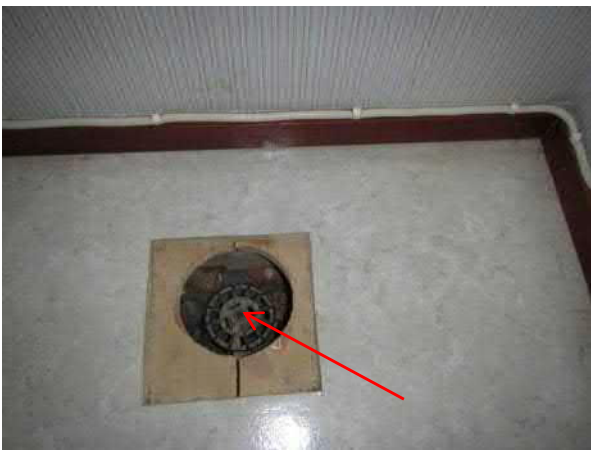
Kuva 119. Vesijohdon pääsulku on huoltohenkilön kylpyhuoneen edessä lattian alla.
