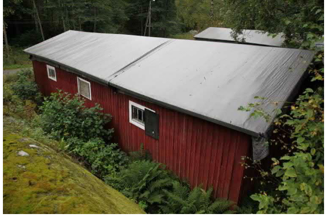
Kuva 178. Vesikaton päällä on pressu, mikä viittaa vesikatteen vuotoihin.
