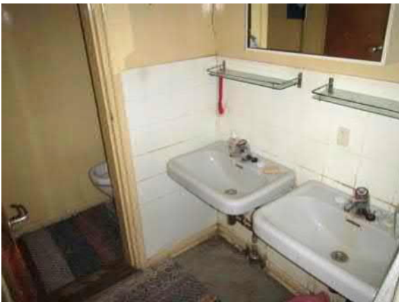
Kuva 265. Rakennus 19. Vesi- ja viemärikalusteet ovat osin alkuperäisiä.
