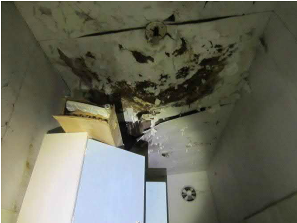
Kuva 138. Vesikatteessa on vuotokohta, joka on aiheuttanut sisäkaton ja väliseinän lahoamisen sekä keittiökaappien romahtamisen
