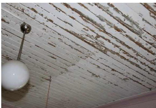
Kuva 247. Pintavaurioita välipohjan alapinnassa.
