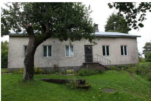
Kuva 112. Rakennuksen julkisivu etelään huoneesta
