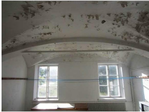
Kuva 54. Katon maalipinta on hilseillyt liiallisen kosteusrasituksen vuoksi
