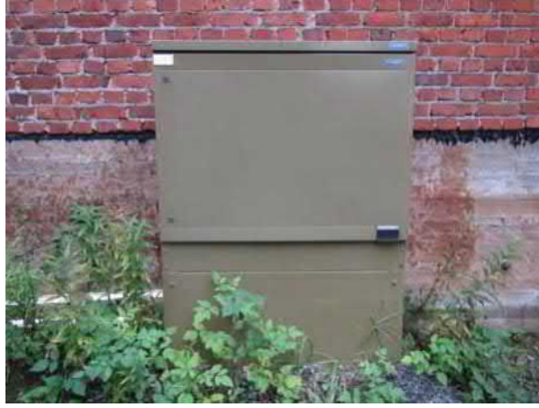
Kuva 193. Rakennus 27. Öljysäiliön vieressä on vuonna 2016 uusittu sähkökeskus.
