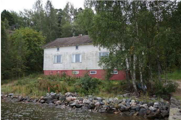
Kuva 257. Näkymä laiturilta pohjoisesta
