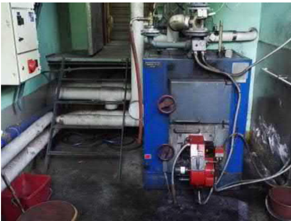
Kuva 101. Rakennus A17. Lämmönjakuhuone on kellarissa. Öljykattila on vuodelta 1975, öljypoltin on vuodelta 2006.
