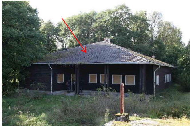
Kuva 139. Vesikatteella kasvaa sammalta ja katolla on useita vuotokohtia! Lisäksi räystäät ovat lahonneet puhki.
