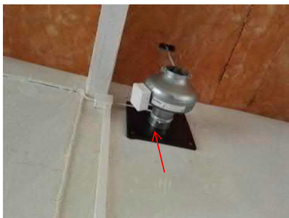
Kuva 203. Rakennus 29. Toimistohuoneessa on koneellinen tuloilmapuhallin. Poisto on painovoimainen hormi.
