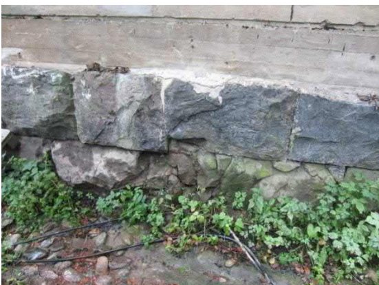
Kuva 190. Rakennuksen perustukset ovat osittain luonnonkiviperusteisia ja osittain vahvistettu/korotettu betonilla
