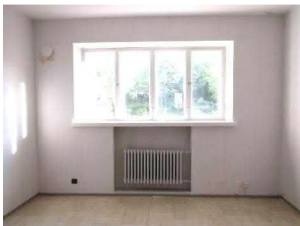
Kuva 40 . Rakennus A1. Korvausilma tulee huoneiden seinistä. Patterit ovat osin syvennyksissä ja kytketty suoraan sivulta. Taustalla näkyy talon vierestä nouseva rinne.
