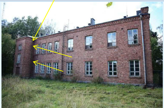
Kuva 98. Julkisivun yksi nurkka on tummunut
