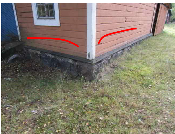
Kuva 89. Rakennuksen koillisnurkka on hieman painunut
