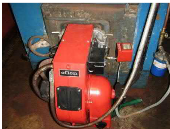
Kuva 41 . Rakennus A1. Öljypolttimet lämmittävät lämmitysverkon ja osittain lämpimän käyttöveden rakennuksissa A1 ja A2.
