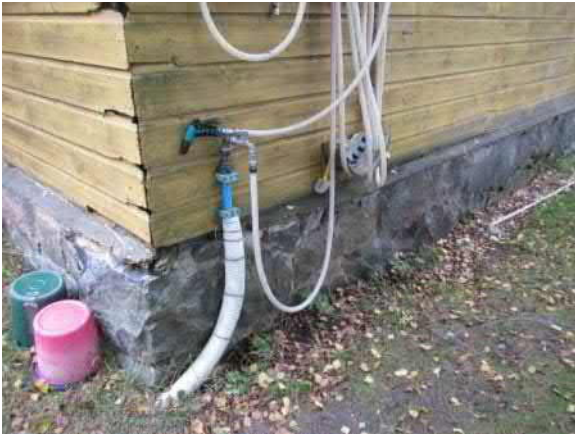
Kuva 263. Varasto 18. Pihapiirin (18 ja 19) vesijohto kulkee maassa. Pääsulku on varastorakennuksen (19) kulmalla maassa.
