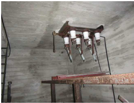
Kuva 239. Muuntamon sisäosa (Kuvattu rikkoutuneen ikkunan kautta)
