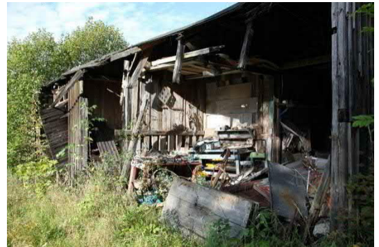
Kuva 69. Rakennuksen romahtanutta länsijulkisivua
