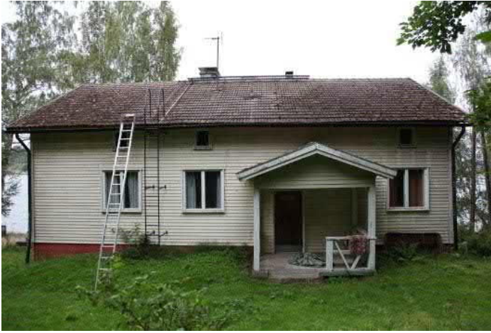
Kuva 261. Rakennuksen eteläjulkisivua sisällä
