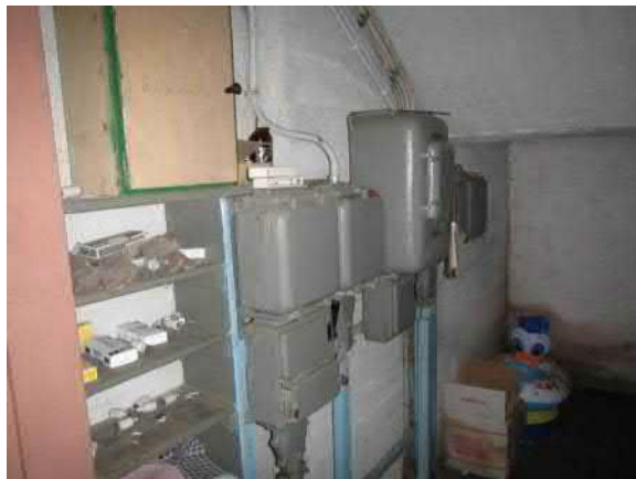
Kuva 268. Pihapiirin (18,19) Sähköpäakeskus on talon 19 Kellarissa. Laitteet ovat alkuperäisiä (arviolta 50-luvulta) ja vanhentuneita.
