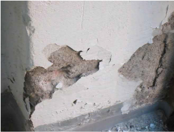
Kuva 53. Sisäseinien rappaukset ovat paikoitellen rapautuneet
