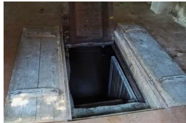
Kuva 106. Lattialuukku josta käynti kellaritilaan
