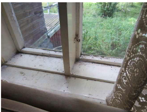
Kuva 67. Ikkunat ovat heikossa kunnossa
