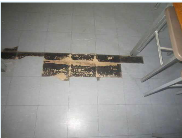
Kuva 97. Lattian vinyylilaatat ovat hajonneet. Alapuolella oleva musta liima on todennäköisesti asbestipitoista liimaa! Nämä kohdat tulee paikata käyttäjien turvallisuuden vuoksi.
