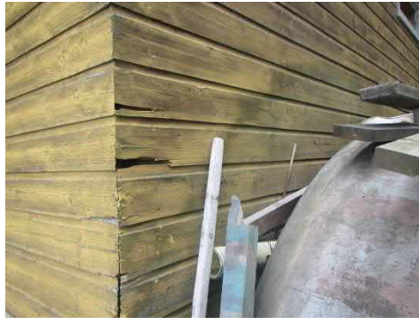
Kuva 256. Julkisivun verhouslaudoissa vaurioita.
