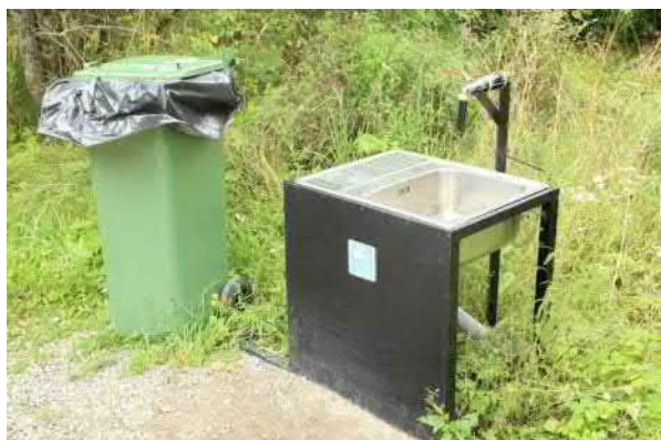
Kuva 24. Vallisaari, lähellä rakennusta 5. Uuteen vesijohtorunkoon on asennettu joitakin yleisiä vedenottopisteitä.
