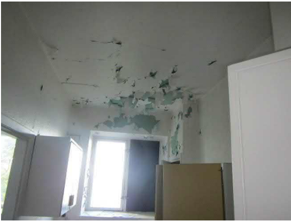
Kuva 35. Maalipinnat ovat 36irtoilleet/hilseilleet eniten A-rapun kohdalla ja sen ympäristössä
