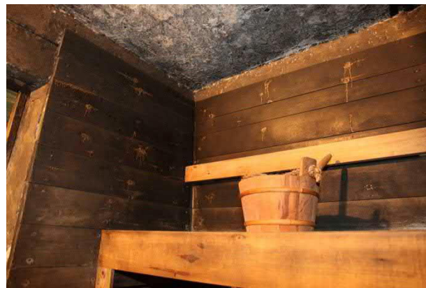
Kuva 312. Löylyhuoneen lauteita ja alakattoa
