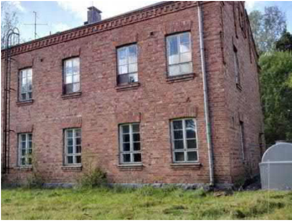
Kuva 99. Rakennus A17. Uusi öljysäiliö on talon päädyssä. Katolla on yleisantenni ja sinne on turvakiskolla varustetut tikkaat. Syöksytorvet ohjaavat vedet perusmuurin viereen.
