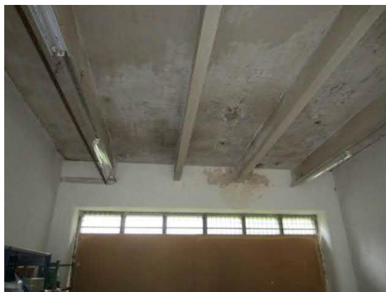
Kuva 191. Betonisessa yläpohjalla havaittavissa vesivuodon jälkiä
