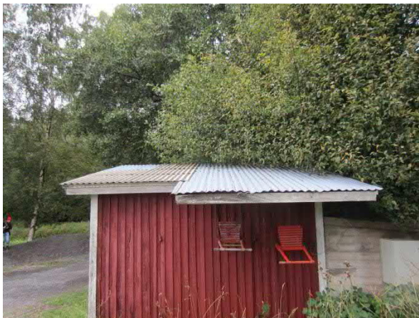
Kuva 229. Peltikatetta on korjailtu useaan otteeseen, mikä viittaa vesivuotoihin
