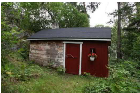
Kuva 313. Rakennuksen julkisivu pohjoiseen.
