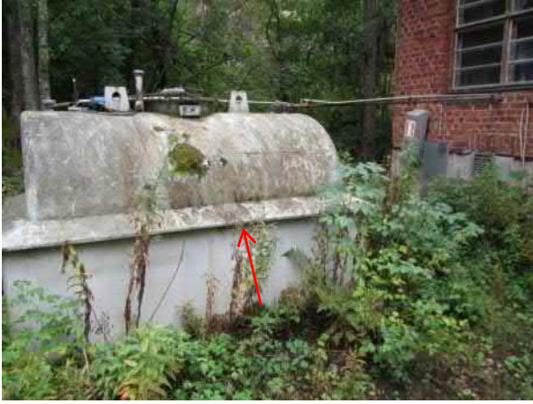
Kuva 192. Rakennus 27. Öljysäiliö on rakennuksen kulmalla.
