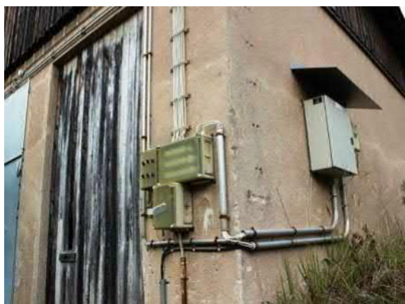
Kuva 278. Rakennus 25. Sähkökeskukset ja asennukset on uusittu 80-90 luvun taitteessa.
