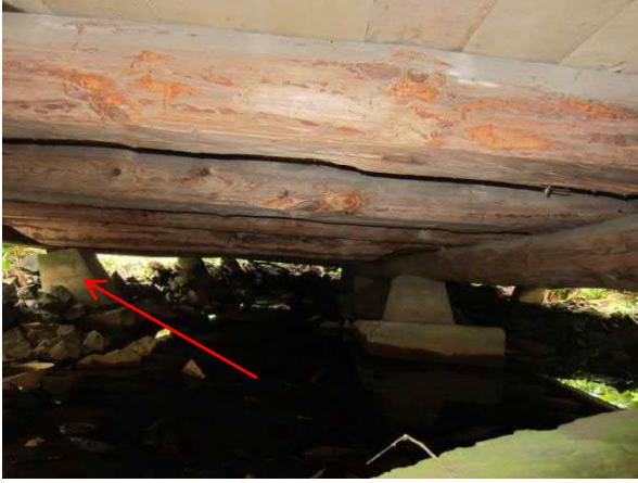
Kuva 177. Betoniantura on painunut/kääntynyt
