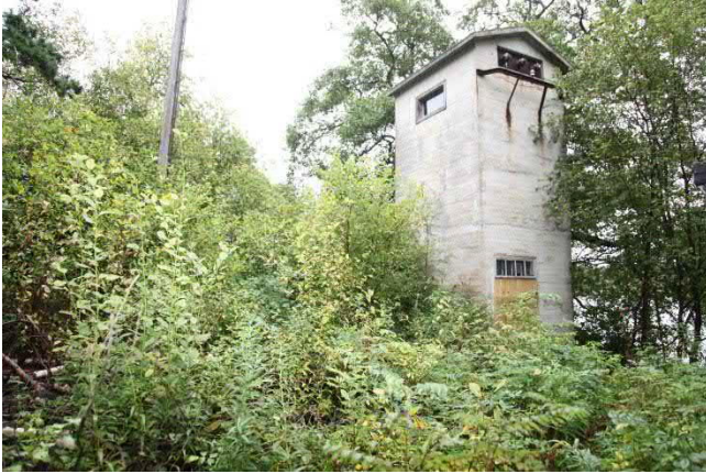
Kuva 236. Muuntamorakennus Kuninkaansaaren itärannalla
