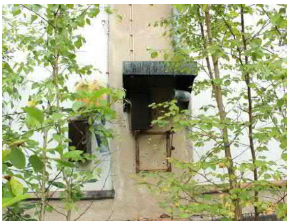
Kuva 277. Rakennus 25 ja 27. Rakennuksissa on ollut koneellinen poistoilmanvaihto. Poistopuhallin on sijainnut ulkona, seinällä olevan pienen katoksen alla. Puhaltimet on poistettu.
