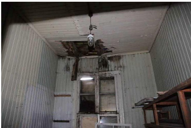
Kuva 74. Vesikatte on vuotanut, mikä on aiheuttanut sisäkaton lahoamisen
