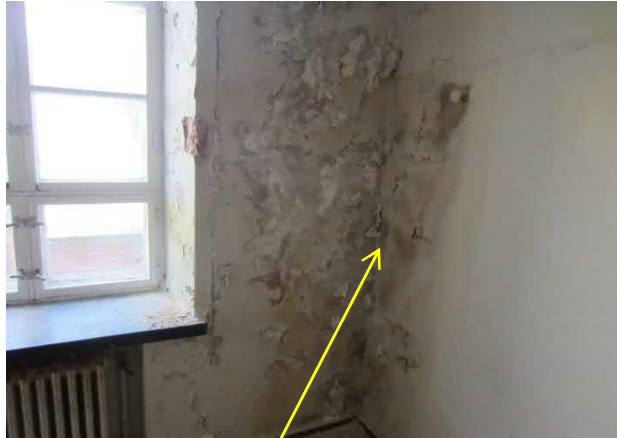
Kuva 96. Sisäseinän nurkan maalipinta on hilseillyt ja seinä tummunut liiallisen kosteusrasituksen vuoksi. Tässä kohti ulkopuolella on tummunut alue.
