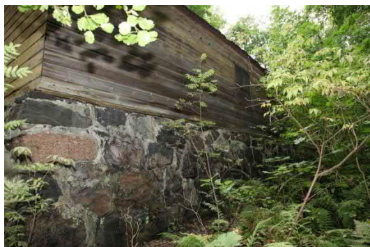
Kuva 217. Rakennuksen perusmuurin nurkan vaurio.
