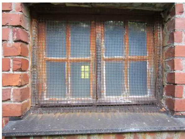
Kuva 108. Pihamökin ikkunat ovat huonossa kunnossa
