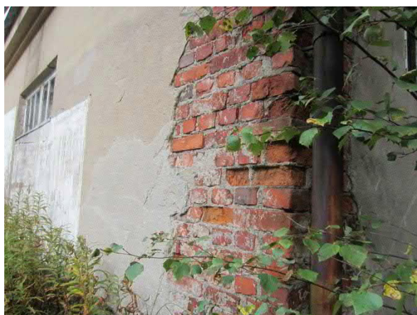
Kuva 81. Julkisivun rappaus on paikoitellen lähtenyt irti
