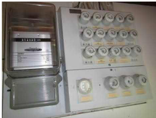
Kuva 120. Sähköpääkeskus on vuodelta 1986.
