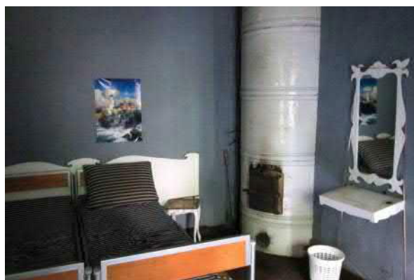
Kuva 27. Rakennus A7. Makuuhuoneen lämmitys-uuni.
