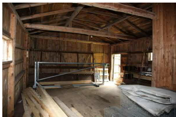
Kuva 176. Sisätila, näkymä kohti pohjoispäätä
