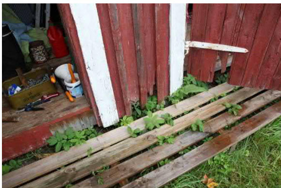
Kuva 133. Julkisivun laudoitus on lahonnut alaosista
