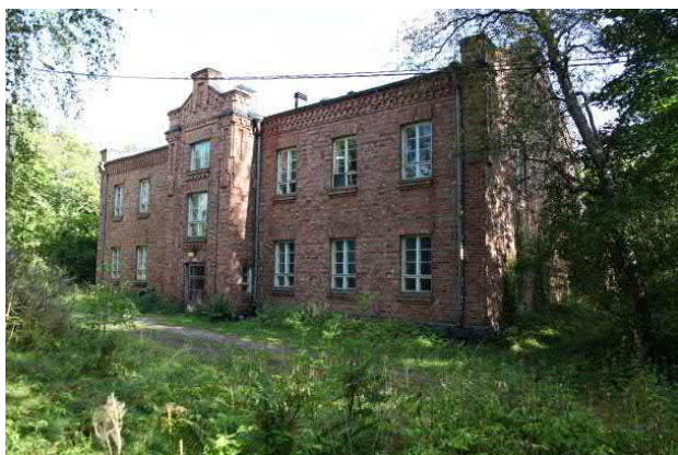
Kuva 90. Rakennuksen pääjulkisivu luoteeseen
