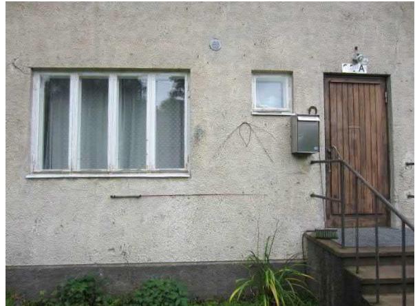
Kuva 116. Rakennuksessa on vanhat puiset ulko- ovet ja ikkunoiden alaosissa maalipinta hilseilee.
