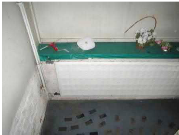
Kuva 266. Rakennus 19. Talossa on vesikiertoisia levyradiaattoreita. Patteriventtiilit ovat vanhoja.
