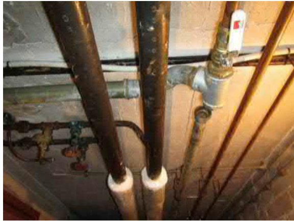
Kuva 264. Talossa 19 lämmitysmuotona on öljylämmitys. Vesijohtot ovat sinkittyä terästä ja kuparia. Vesijohtoihin on tehty muutoksia ja osa alkuperäisistä vesijohtoista on poistettu käytöstä.
