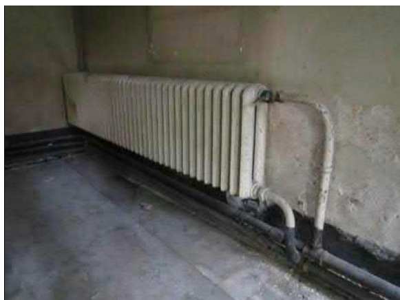
Kuva 276. Rakennus 25. Käytöstä poistettu vesikiertoinen jaeradiaattori. Lämmityksen rakennuksesta 26 tulevat runkoputket on katkaistu.
