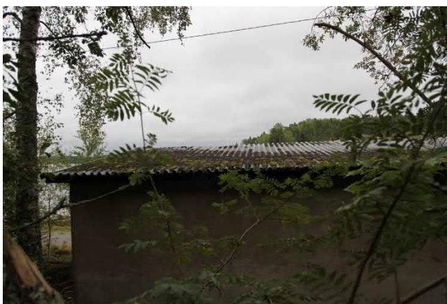
Kuva 226. Vesikatolla on paljon lehtiroskaa ja sammalkasvustoa
