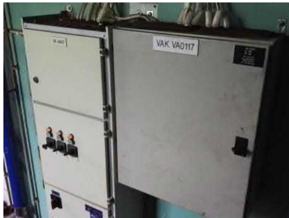
Kuva 102. Rakennus A17. Sähköpääkeskuksen teho on 63A. Moderni VAK VA0117 ohjaa lämmitysjärjestelmän toimintaa. Toimilaitteet ovat hyvässä/tyydyttävässä kunnossa.
