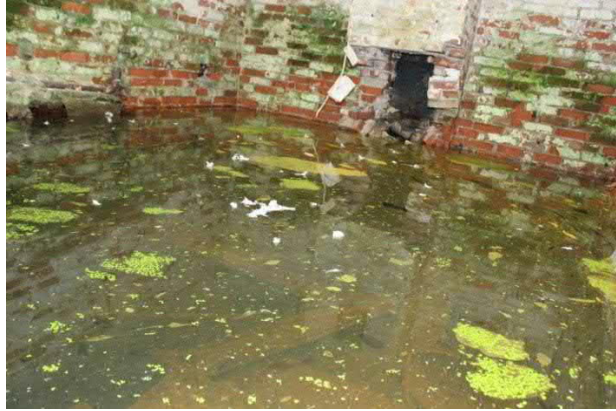
Kuva 285. Sisätiloissa merkittäviä vaurioita, lattiat veden peitossa.
