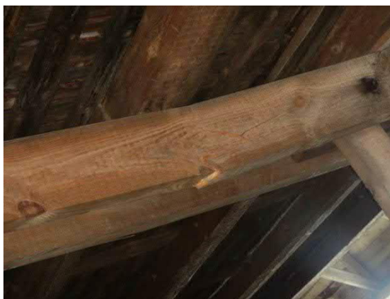
Kuva 301. Vaurio/ murtuma kattoristikossa.
