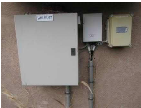
Kuva 279. Rakennus 25. Seinällä oli VAK KU27. Laitteisto on arviolta 10 vuotta vanha. Toiminnoista ja toimintakunnosta ei tietoa.
