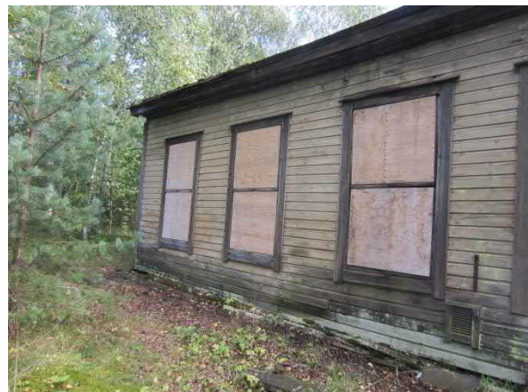
Kuva 75. Julkisivun laudoitus on lahonnut/hajonnut useasta kohtaa
