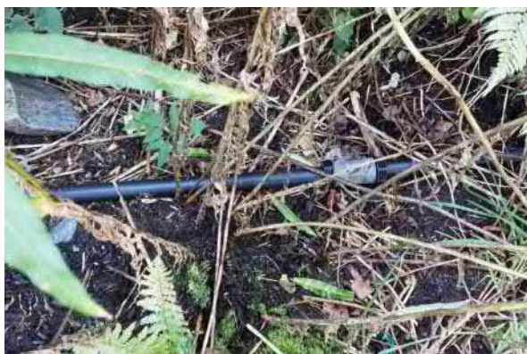
Kuva 25. Rakennuksen A7 ulkopuolella. Uusi muovinen vesijohto näkyvissä.
