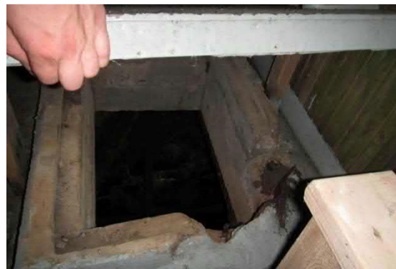
Kuva 233. Löylyhuoneen lattian luukku, alla kaivo
