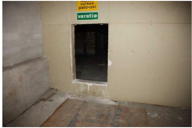
Kuva 37. Palo-osastointiseinässä aukko, josta tapahtuu kulku toisen rapun ullakolle. Aukko tulee sulkea aina kun siitä kuljetaan.
