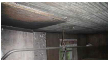
Kuva 235. Löylyhuoneen pintaverhousrakenteiden vaurioita, maali-/ rappaushilseily, tummentumat puuverhouksissa
