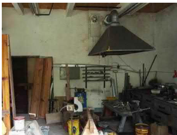
Kuva 204. Rakennus 29. Päädyssä on metallipaja, missä on koneellinen yleispoisto ja koneellinen erillispoisto huuvasa. Korvausilma tulee avattavien ovien ja ikkunoiden kautta.
