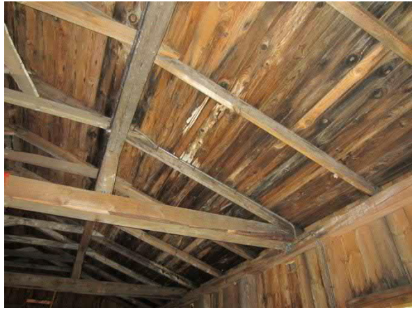
Kuva 184. Katolla on suojapeite suojana. Aluslaudoitus on tummunut, mikä viittaa vesivuotoihin
