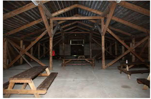
Kuva 151. Sisänäkymä kohti länttä
