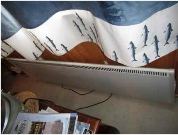
Kuva 117. Sähköpatterit ovat ikkunoiden alla.
