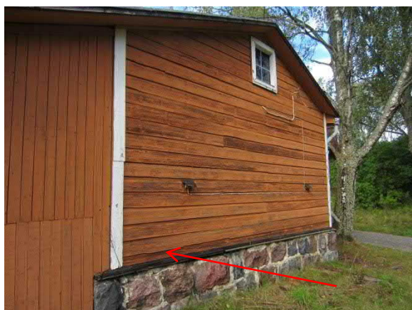
Kuva 88. Julkisivun laudoituksen alimmat laudat ovat lahonneet
