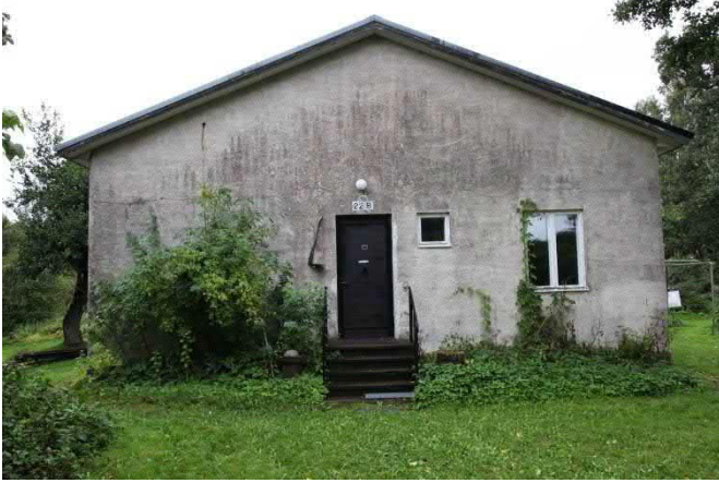
Kuva 115. Julkisivun rappauksessa on tummempia alueita (kuvassa itäpääty)
