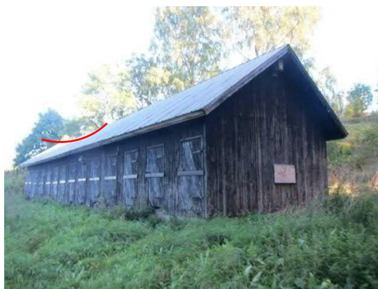
Kuva 60. Vesikate on notkahtanut
