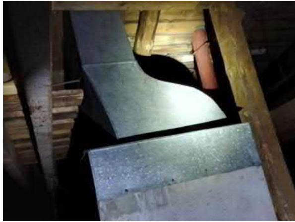
Kuva 100. Rakennus A17. Painovoimaiset ilmanvaihdon poistohormit on yhdistetty ullakolla ja viety peltikanavalla katosta läpi.
