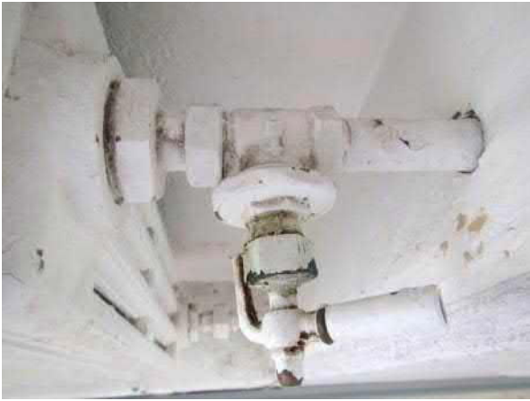
Kuva 42. Rakennus A1. Alkuperäiset, arviolta 1960-luvulta olevat "koukkunokkaventtiilit".
