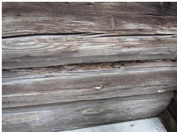
Kuva 127. Hirsirakenteissa on paikoin lahoja kohtia.
