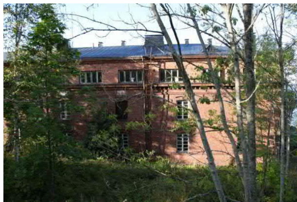
Kuva 33 Rakennuksen takajulkisivu etelään
