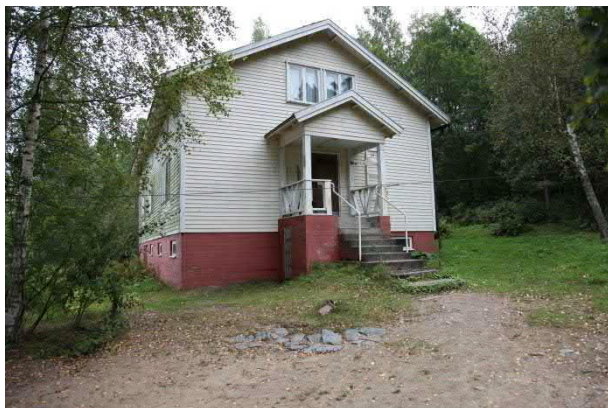
Kuva 259. Länsijulkisivu pihalle päin
