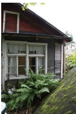
Kuva 246. Rakennuksen julkisivu etelään.
