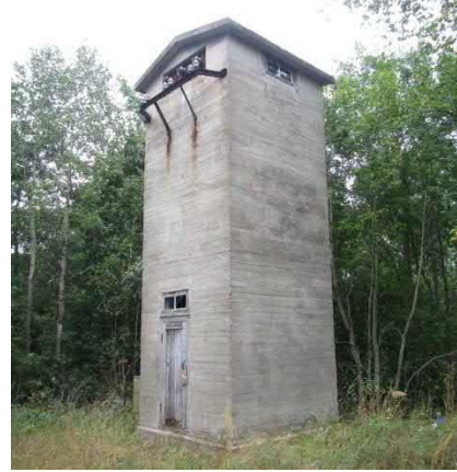
Kuva 237. Muuntamorakennus varaston 33 lähellä
