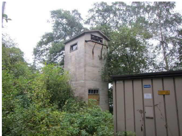
Kuva 238. Vanha ja uusi muuntamorakennus
