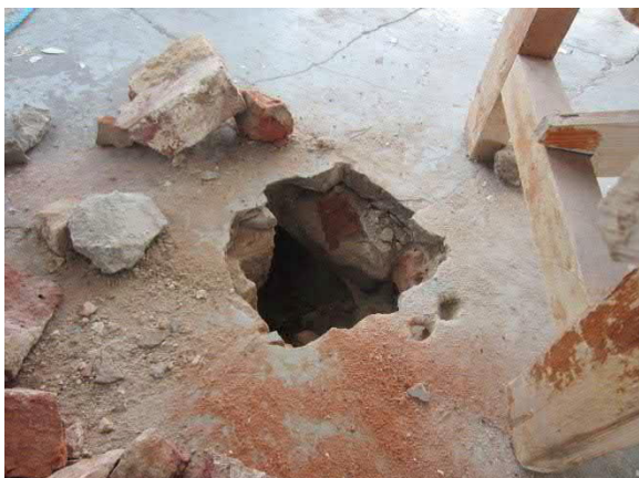
Kuva 51. Lattialla olevasta reiästä tarkistettiin alapohjan rakenteet
