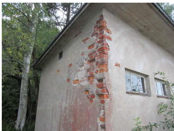
Kuva 225. Rakennuksen kaakkoisnurkan julkisivun rappaus on rapautunut
