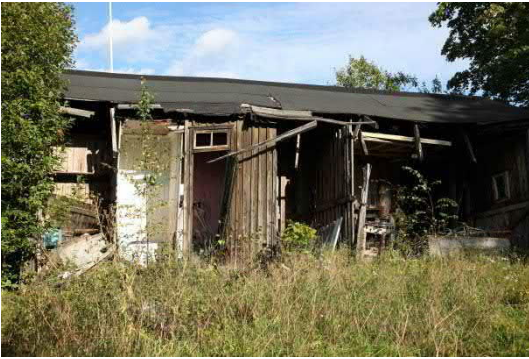
Kuva 68. Rakennuksen romahtanutta länsijulkisivua
