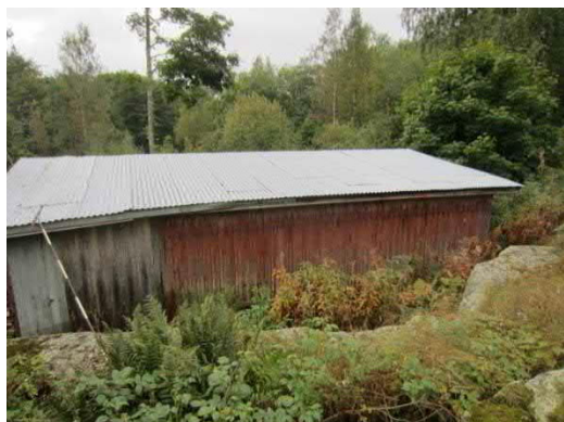
Kuva 132. Rakennus on painunut päädyistä, mikä ilmenee vesikatteen kaarevuutena
