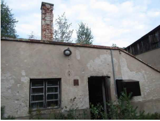
Kuva 284. Rakennuksen eteläjulkisivu, rappausvauriot.
