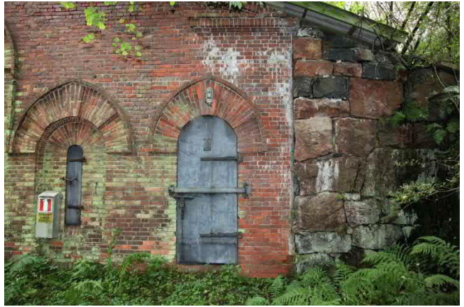
Kuva 172. Julkisivun tiiliverhouksessa vihreää ja valkoista kasvustoa, muuten hyvässä kunnossa
