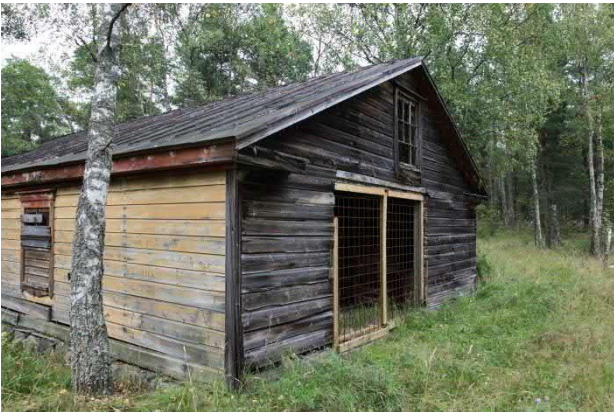
Kuva 207. Lounaispääty, oviaukko suljettu
