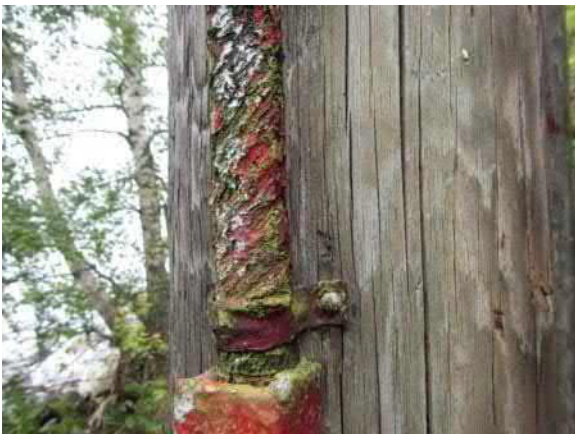
Kuva 267. Talon 19 takana on nähtävissä huonokuntoinen pihapiirin liittymäjohto.
