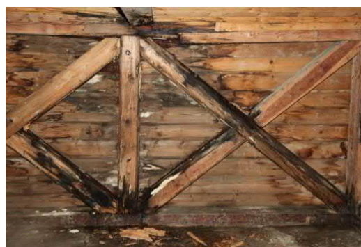
Kuva 218. Rakennuksen rungon paikallinen vaurio.
