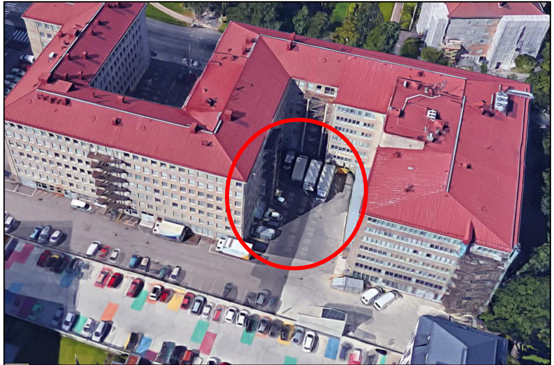
Kuva 6. Kohteen eteläpuolella sijaitseva lastauslaituri
