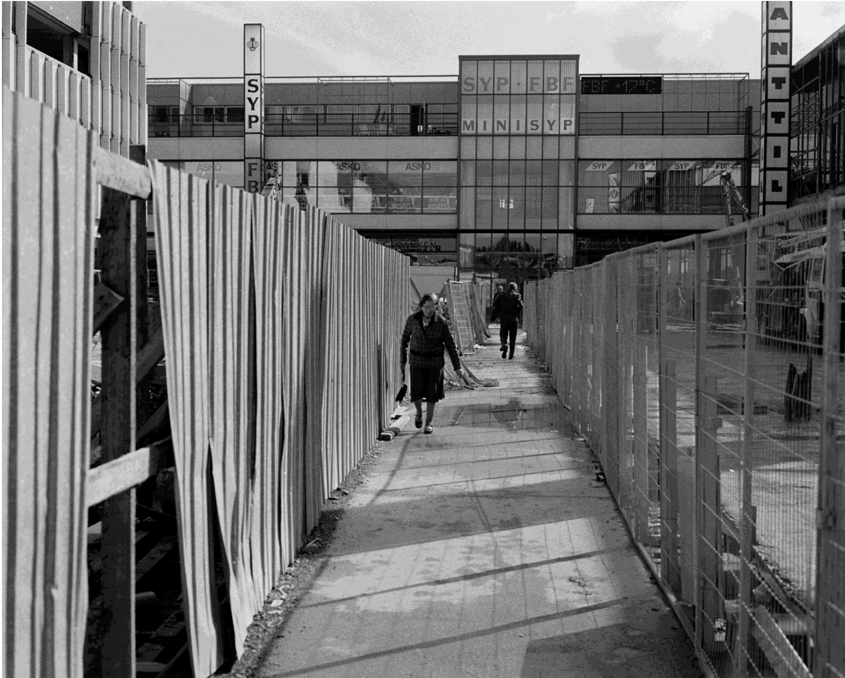
Kauppakeskuksen ensimmäisen rakennusvaiheen työmaa vuonna 1984. Näkymä itään kohti SYP:n kiinteistöä. Kuva: Jan Alanco, HKM.
