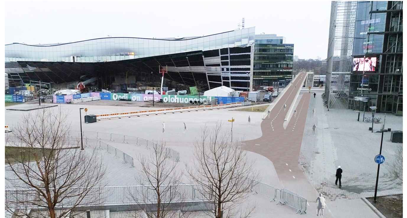
Eteläinen ylikäytävä katunäkymässä Kansalaistorilta itään päin (2018).
