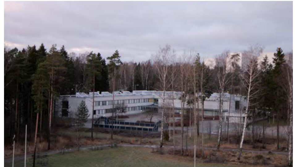
Alla: Koulurakennus nähtynä Alakiven puiston täyttömäeltä.
