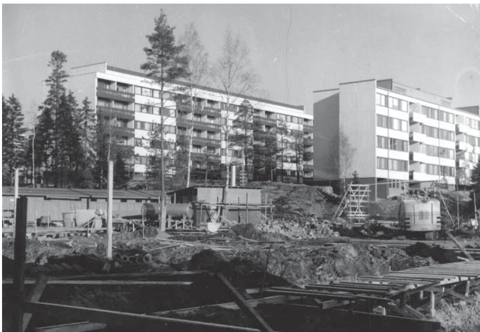
Yhteiskoulun rakennustyömaamonttu ja takana olevat asuinrakennukset vuonna 1966. MPKA.
