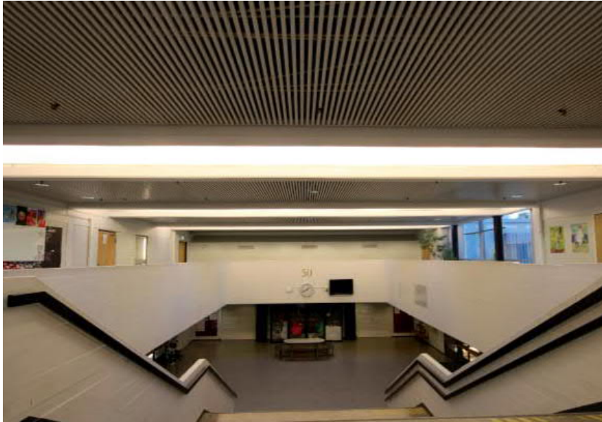
Sisääntulohalli kohden liikuntasalia. Alkujaan avoin yhteys liikuntasaliin tukittiin vuoden 2003 peruskorjauksen yhteydessä. IV-kanavatila peitti 2. kerroksen lasiseinän ja 1. kerroksen paljeovet vaihdettiin umpiseinään ja parioviin. Alakton valaisimet myös uusitti. Alkujaan valaisimet oli sijoitettu säleiden taakse, nyt katossa on upotetu pyöreät downlight-valaisimet. Oikeanpuolimmainen kuva ylhäällä julkaistu Arkkitehtilehdessä 12/1967. SRMA.
