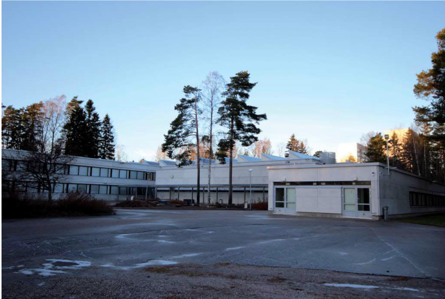
Peruskoulu piharakennuksineen, eteläjulkisivut
