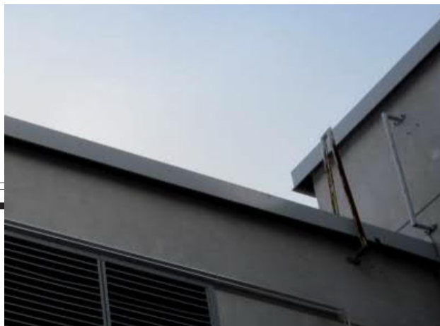
Yllä ja oikealla: Pystyleikkaus. Detaljit. 45-2994-03-D vahvistettu 21.10.2003 § 610. Julkisivujen perusparannus. Insinööri Heikki Halsti, suunnittelutoimisto Heikki Halsti Oy. HRVA. Alla ja vasemalla: Rakennuksena aiemmin räystäätön julkisivu sai räystäspellytykset julkisivujen peruskorjauksessa 2003.
