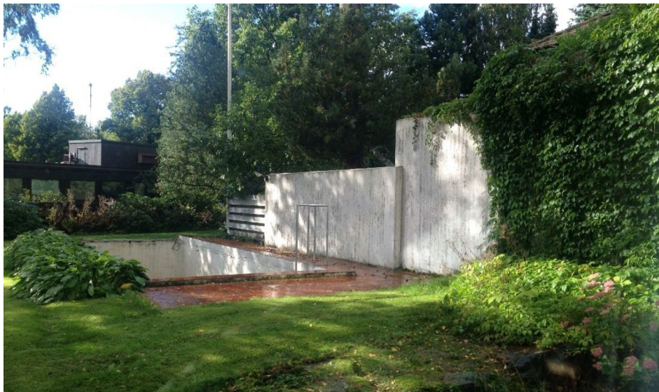
Rakennusten välinen tukimuuri runsaine istutuksineen kuvattuna purettavaksi aiotun 1960-luvun rakennuksen olohuoneesta. (Kuva Leena Paavilainen)
