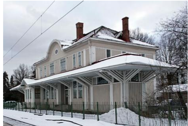
Asemarakennus, n. 1921 (tyyppiirustus 1914). sr-1.
