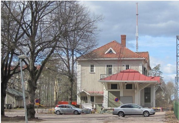
Asemarakennus pihapiireineen alikululta päin.
