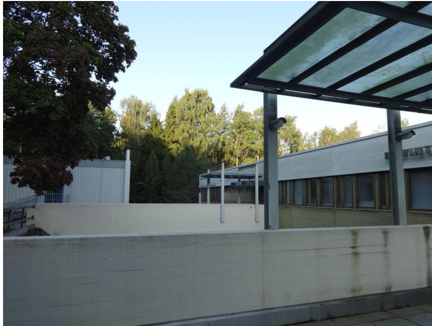
Yläkuvat: näkymä yhdyssillalta kohti Roihuvuorentietä (vasemmalla väistötilaparakit)
