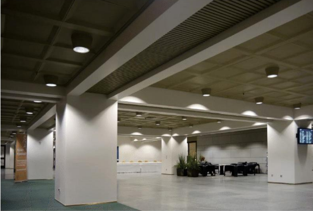
1. kerroksen sisääntuloaula / katon kaksoisprimääripalkisto
