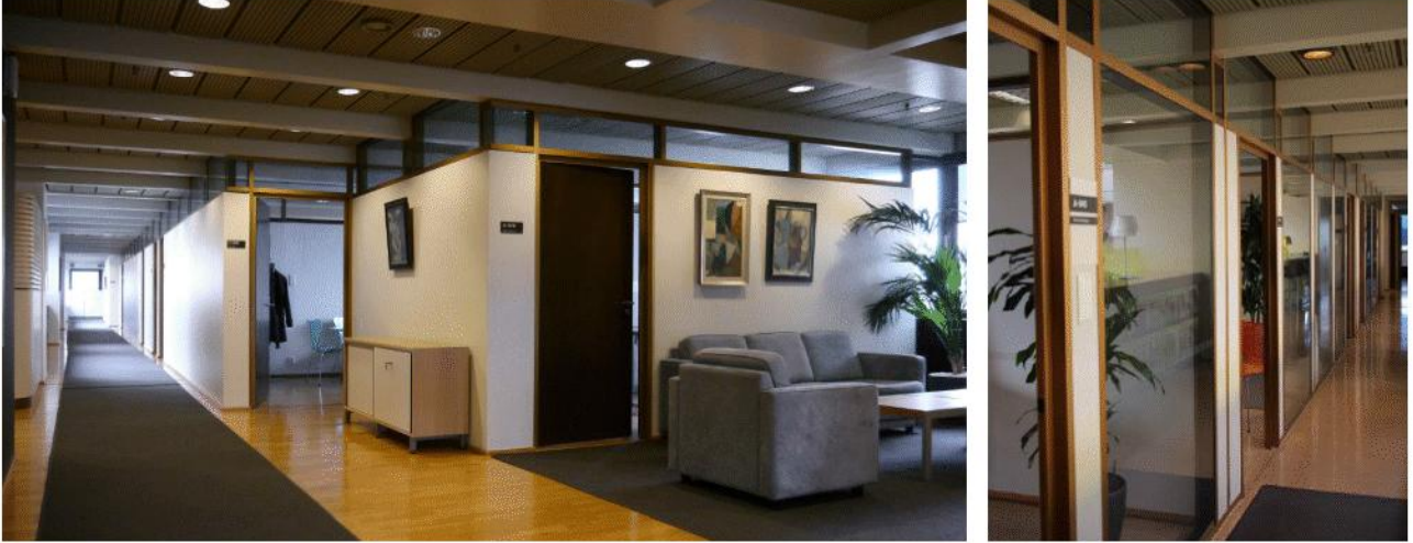
Alkuperäisiä lasiseinäisiä väliseinärakenteita
