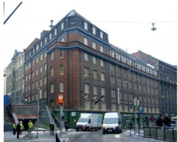
Kaisaniemenkatu 3:n 6-7 kerroksinen tiilinen asuin- ja liikerakennus rakennettiin 1924. Suunnittelija Erkki Paalanen. (Kuva:SL)
