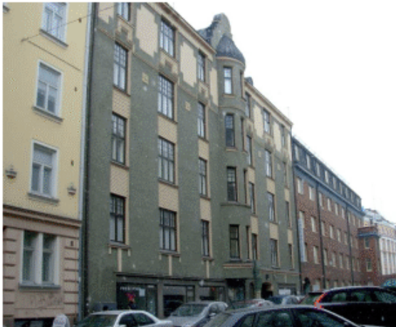
Vuorikatu 8 kadunvarren viisikerroksinen asuin- ja liikerakennus rakennettiin 1906. Sen suunnitteli Johan Settergren. (Kuva: SL)
