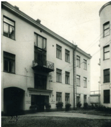
Vuorikatu 8 piharakennus on rakennettu 1898. Kolmekerroksisen asuinrakennuksen suunnitteli Waldemar Aspelin. Rakennuksessa on toiminut matkustajakoti. (Kuva: Erik Sundström 1922, Kaupunginmuseon kuva-arkisto.)
