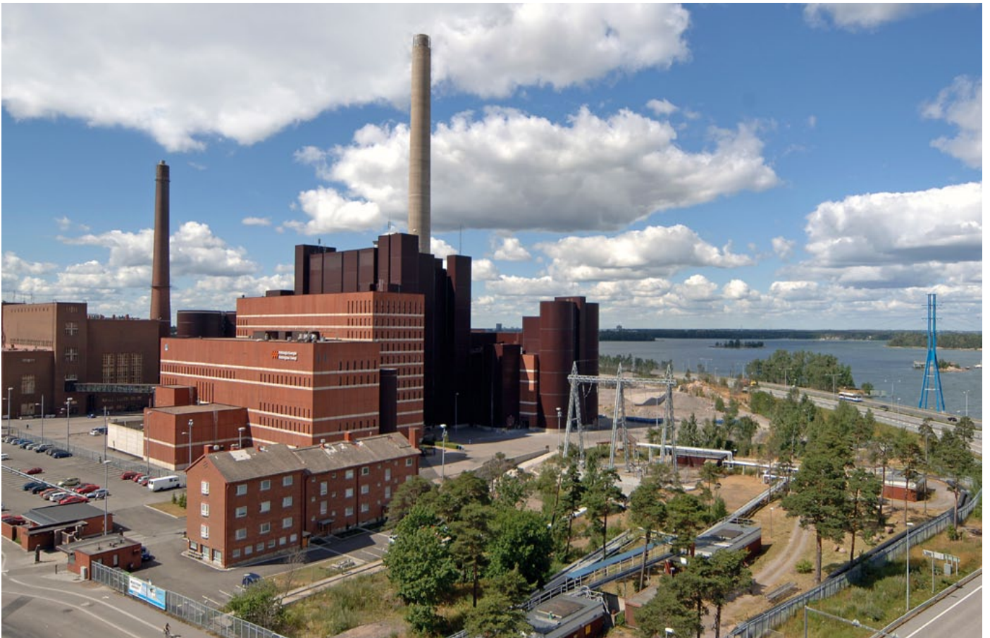
Kuva 2-3. Salmisaaren A- ja B-voimalaitokset (kuva: Helsingin Energia).
