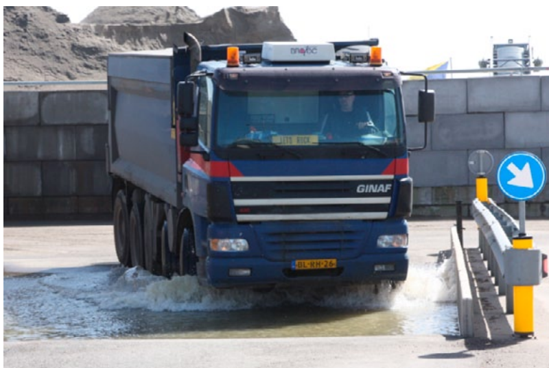
Kuva 12-4. Esimerkki renkaiden pesusta, ajo vesialtaan kautta.
