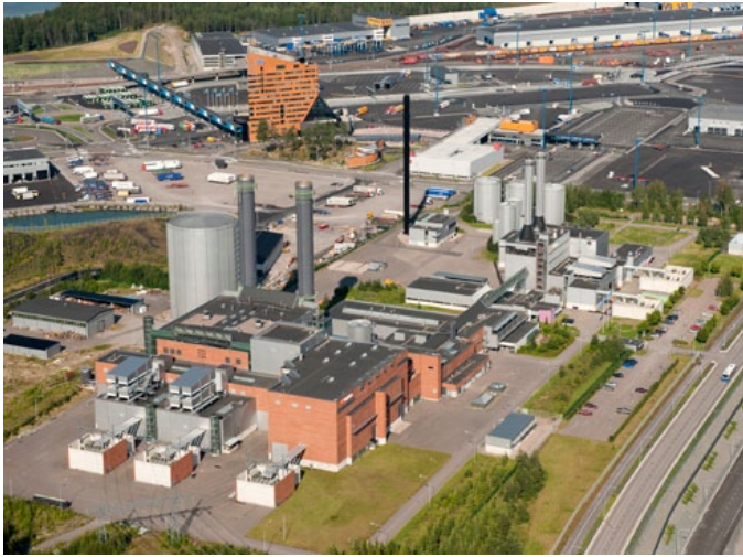
Kuva 2-1. Vuosaaren A- ja B-voimalaitokset (kuva: Helsingin Energia).
