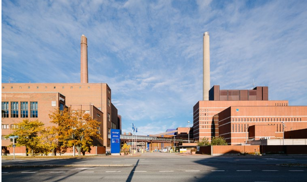
Kuva 21-52. Kuva Salmisaaren voimalaitosalueen nykytilasta Porkkalankadulta kuvattuna. Kuva: Arkkitehtitoimisto Virkkunen & Co.
