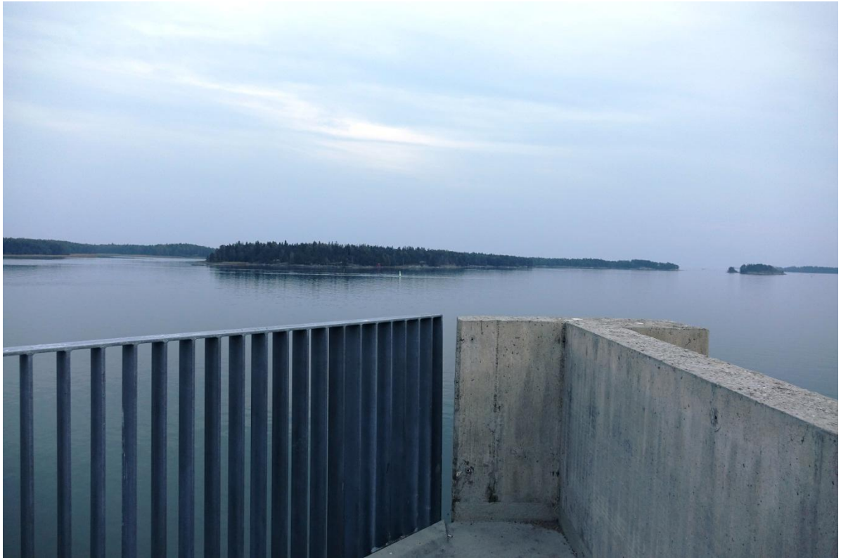
Kuva 2. Näkymä polttoainelaiturin tulevasta paikasta kohti merta.
