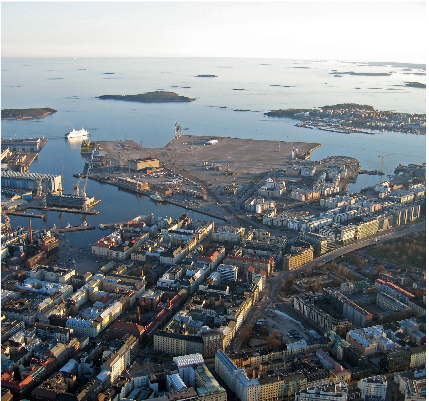
Näkymä Jätkäsaaren yli kohti avomerta tavarasataman muuton jälkeen vuonna 2009. Kuva Suomenilmakuva Oy.
