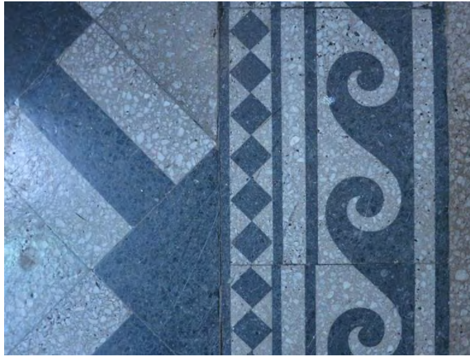
A-portaan alkuperäinen mosaiikkibetonilattia
