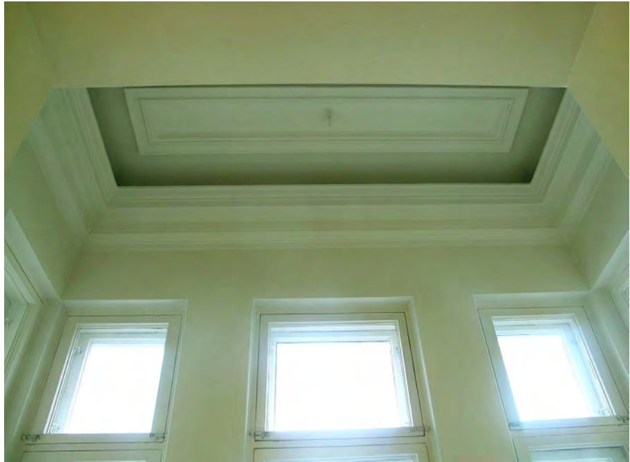
Bulevardin puolen erkereiden kattolistoja
