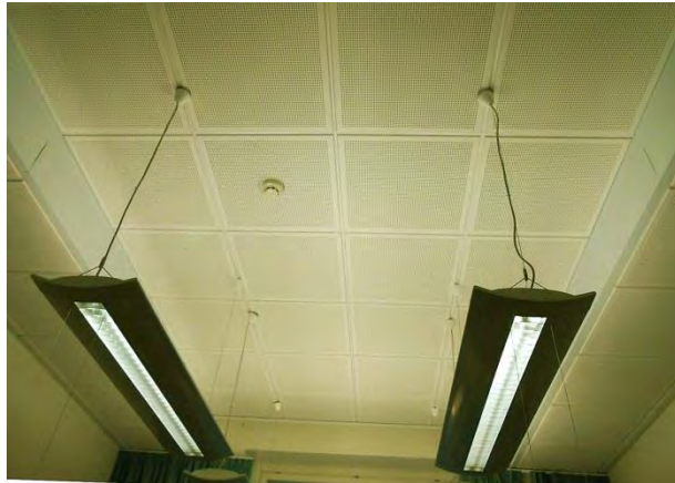
4.krs:n sisäpihan puoleisen toimistohuoneen alakattoja
