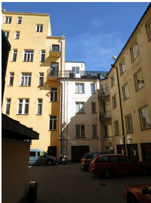
Näkymä sisäpihalta Bulevardi 10 päin
