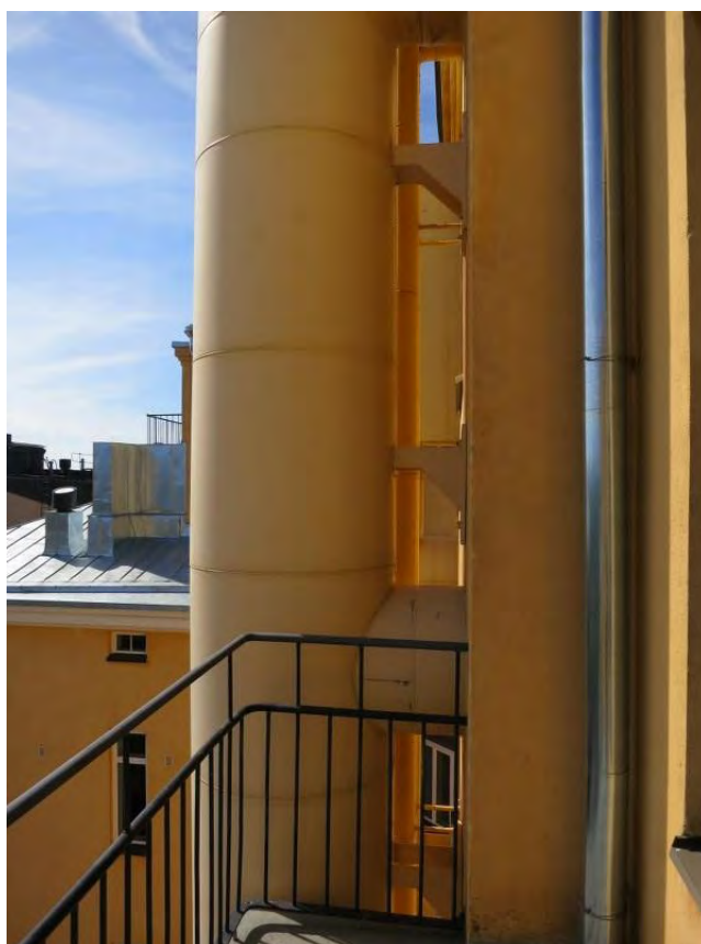
Sisäpihan IV-putket julkisivulla
