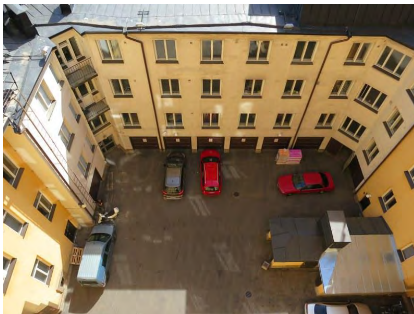
Näkymä 5.- ja 6.krs.n välitasanteen parvekkeelta sisäpihalle päin
