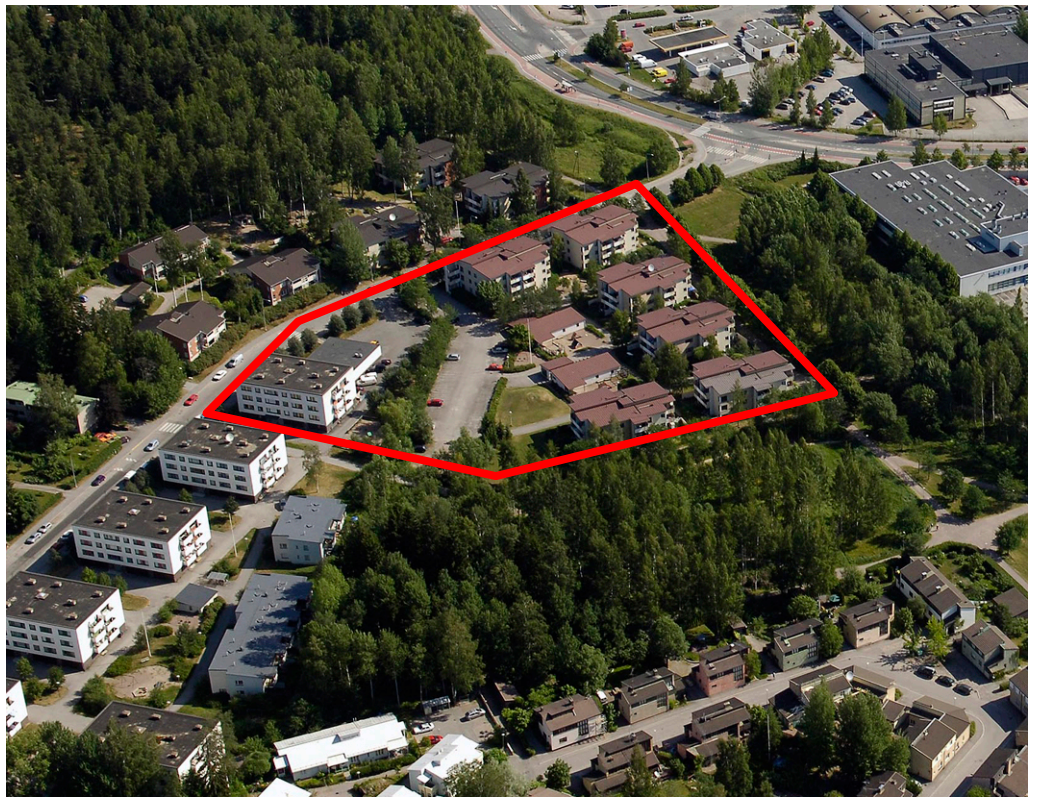
Viistoilmakuva lounaan suunnasta. Kuvan oikeassa yläreunassa Konalantie.
