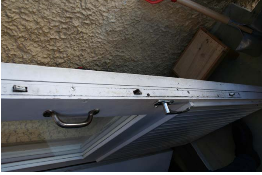
KUVA 69 Parvekkeen ovi, pitkäsarpa (muutos), 2011
