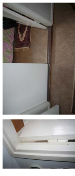
KUVA 63, 64: Ovilista ja sarana, kynnyks, 2011
