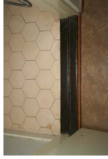
KUVA 82: Erillis-wc:n vanha lattia, 2011
