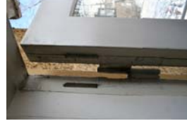
KUVA 70: Parvekkeen oven saranointi, 71: sarpa (orig)
