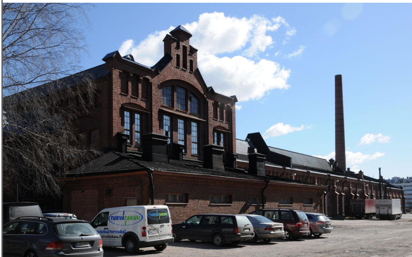
Suojeltavat rakennukset Pasilan konepaja, osa-alue V Kokoonpanohalli
