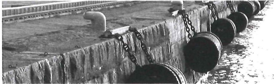
Saukonlaiturin vanhat laiturirakenteet suojelemaan.
