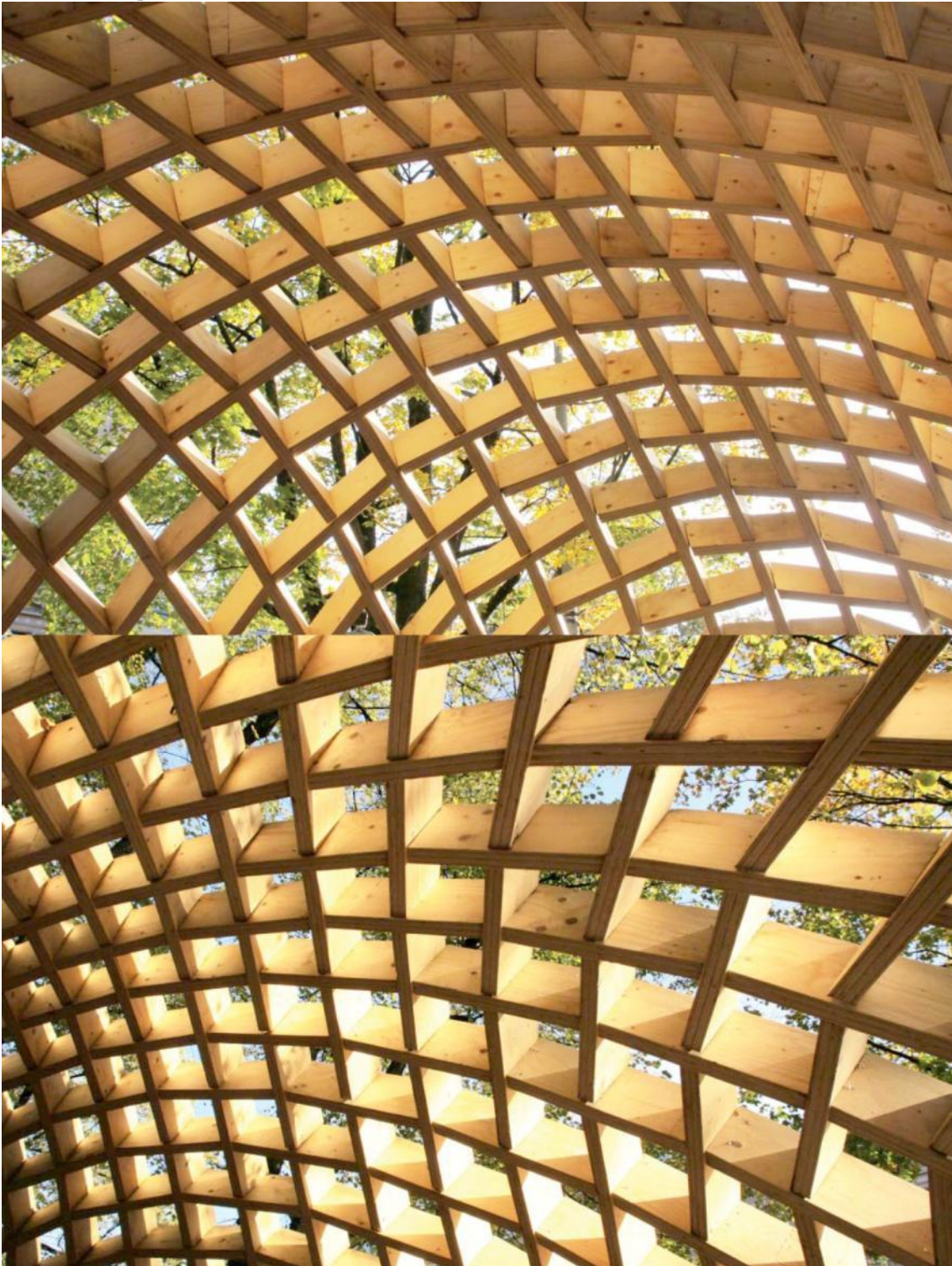
Turku 2011 -säätöön toteuttaman ja arkkitehtipiskelijöiden suunnitteleman Pudelmä-paviljongin kattorakenteita Turun kaupungintalon tuntumassa (Kuva Heikki Helin)
