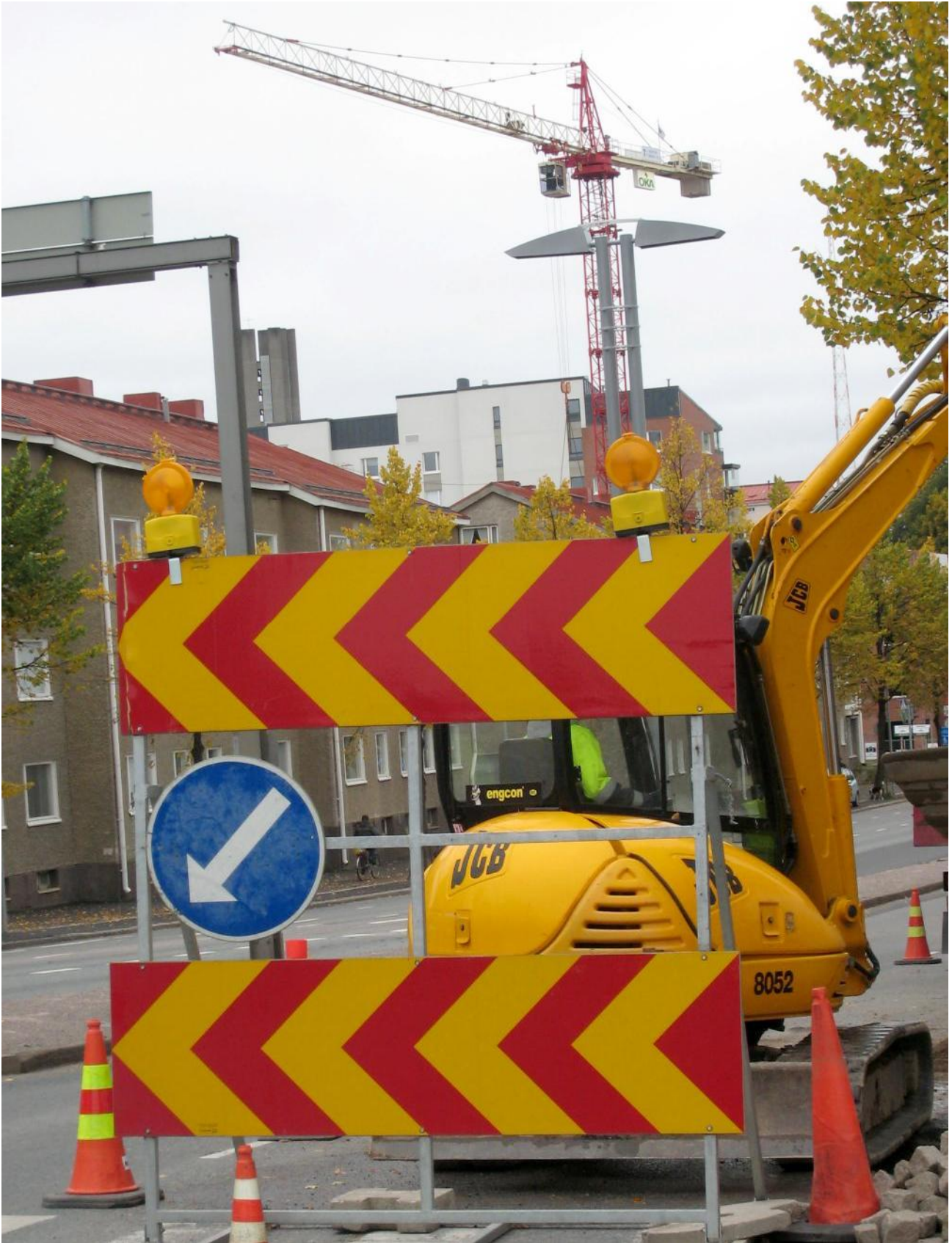
Korjaustyö Lahden Lahdenkadulla. (Kuva HH)
