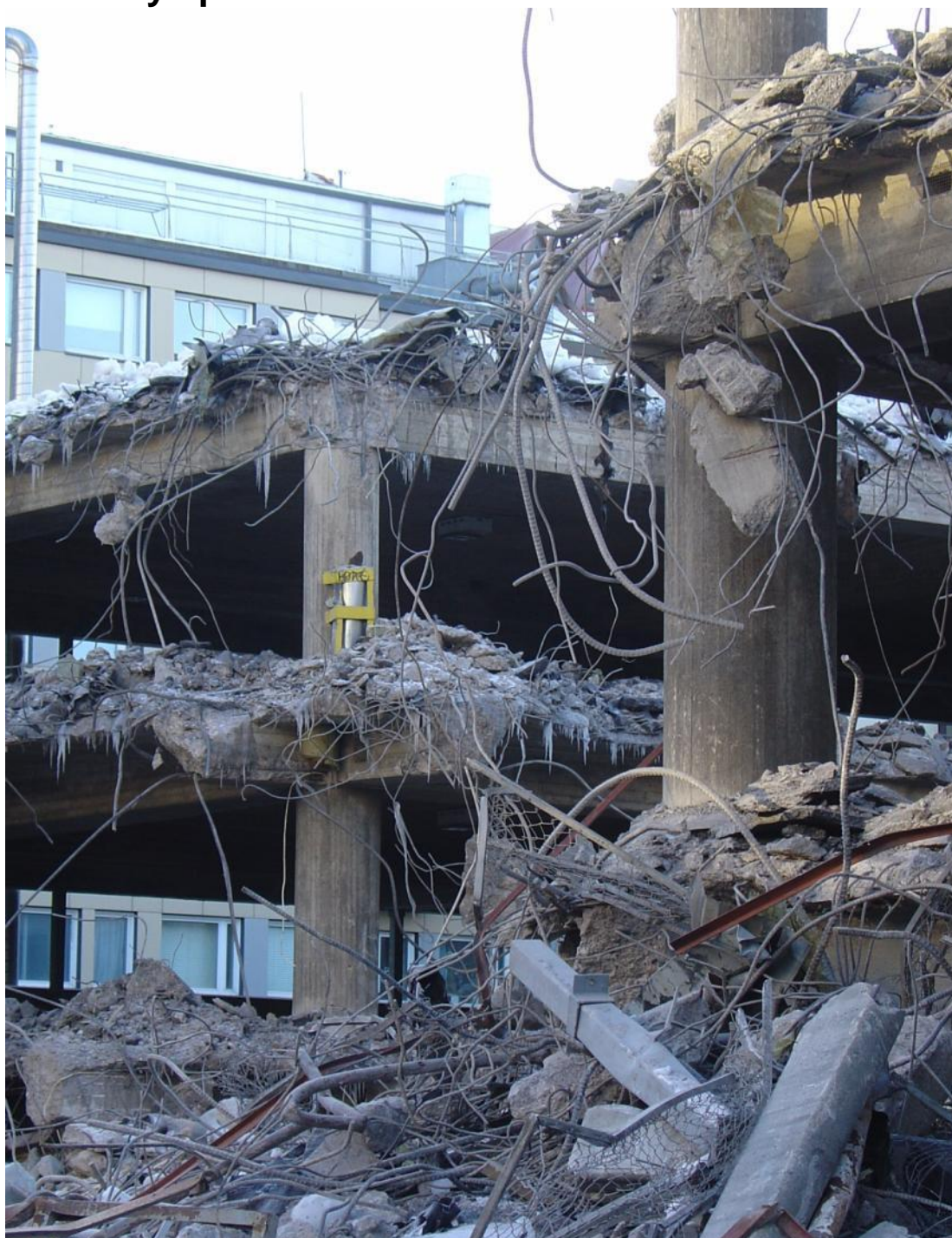
Rakentamisen ryske liittyy kasvuun. Kuvassa vanhan pysäköintitalon purkutyömaa Lahden Vapaudenkadulla 2006. Paikalle rakennettiin elokuvateattereita. (Kuva Heikki Helin.)
