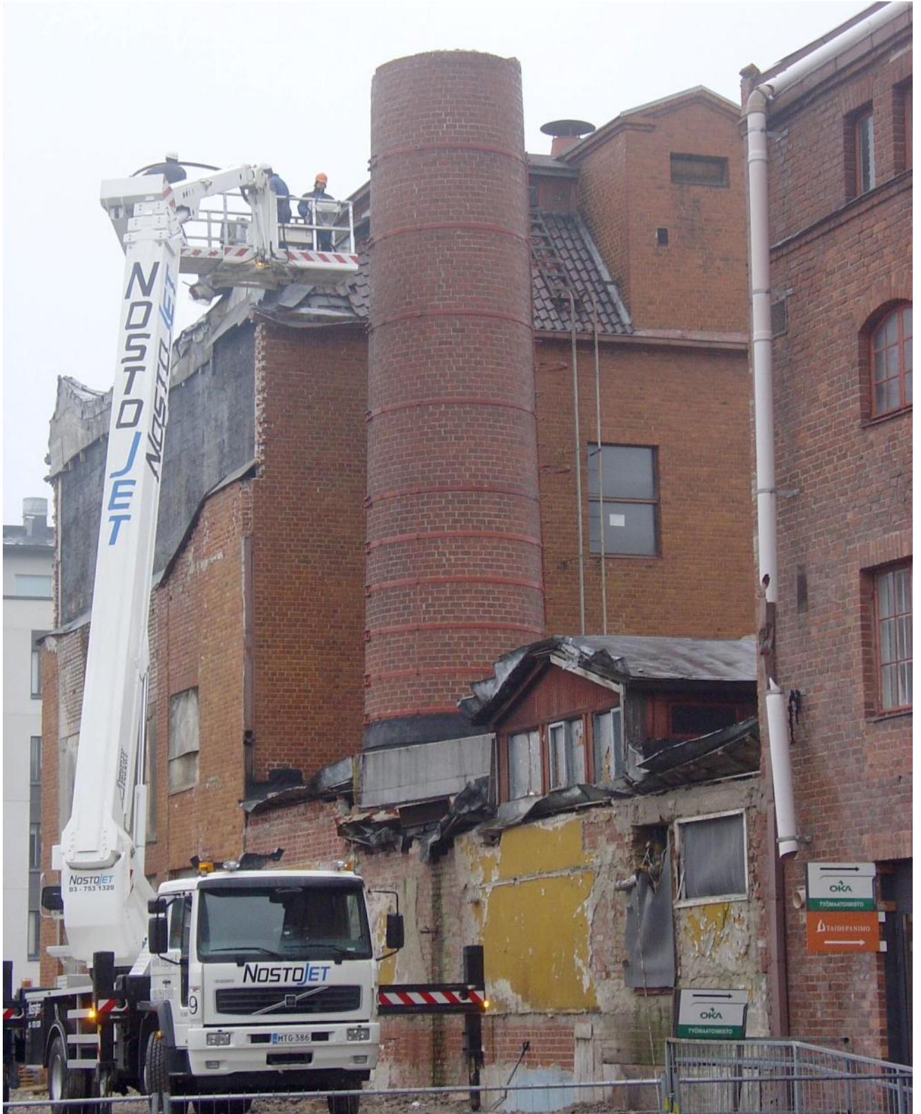
Kehittyvän kaupungin tunnusmerkkinä pidetään nostokurkia. Kuvassa puretaan Lahden Mallssjuoman alueen piippua. (Kuva HH)
