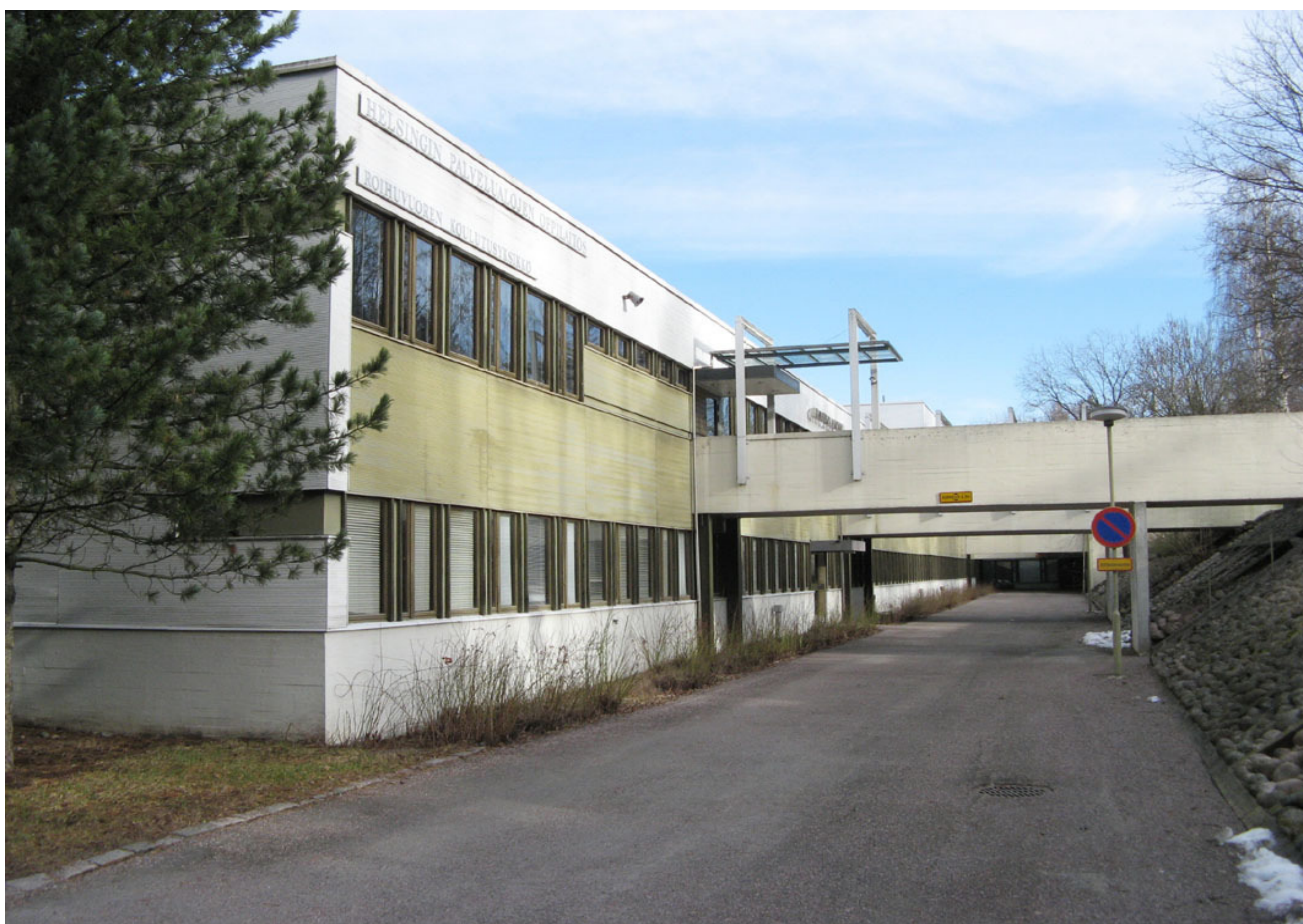
Näkymä Prinsessantieltä siltojen alta
