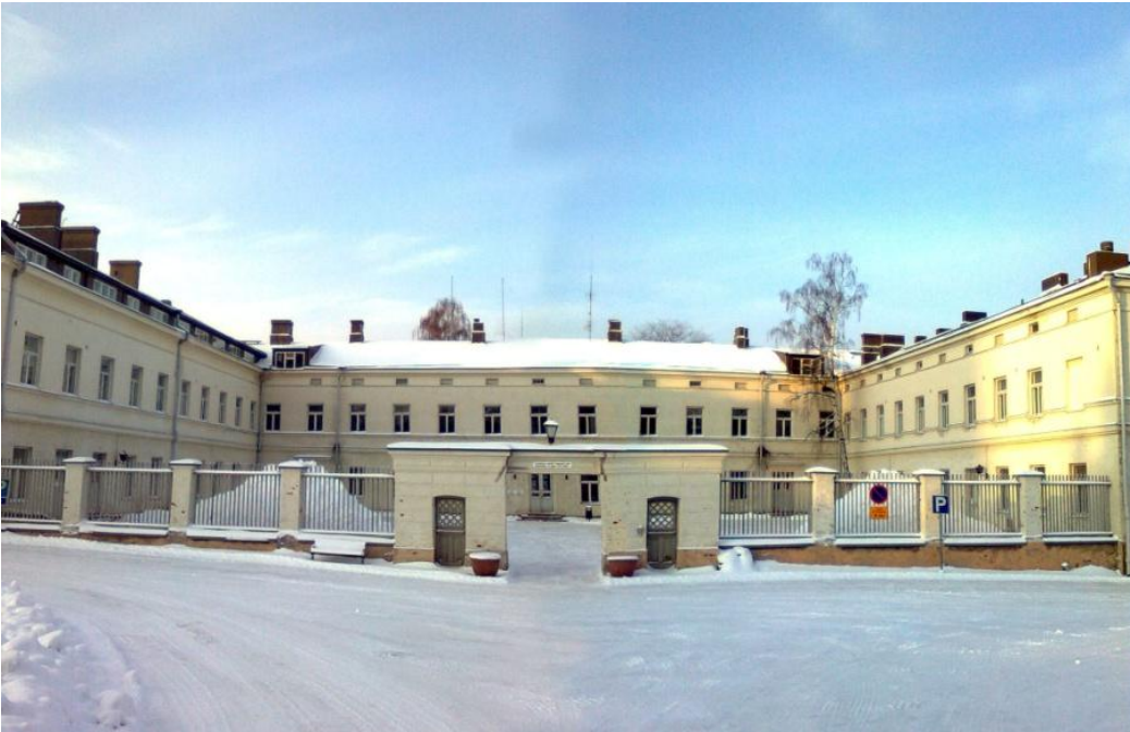
Päärakennuksen etupiha ja portti 2010
