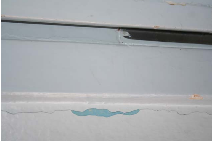
KUVA 84: Porrashuoneen seinässä näkyviä vanhoja värijämiä
