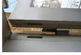
KUVA 70: Parvekkeen oven saranointi, 71: sarpa (orig)
