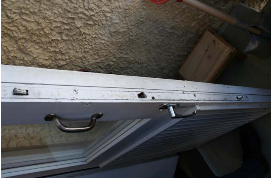
KUVA 69 Parvekkeen ovi, pitkäsarpa (muutos), 2011
