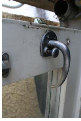
KUVA 70: Parvekkeen oven saranointi, 71: sarpa (orig)
