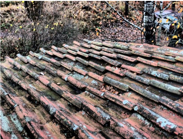
Kuvat 4 ja 5: Savitiilien vaurioita vihreän talon katolla.
