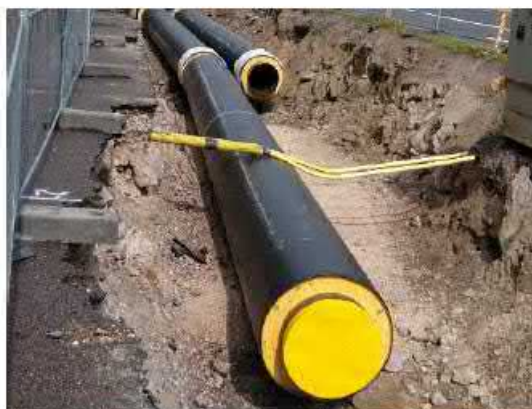
Kuva 3-2. Kaukolämpöverkoston putki.
