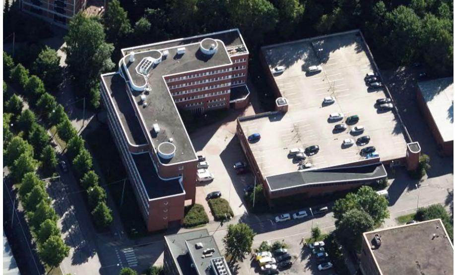
Kuvassa vasemmalta lukien Kaupintie, Sentnerikuja 2:n nykyinen toimitalorakennus ja Sentnerikuja 4:n pysäköintilaitos.
