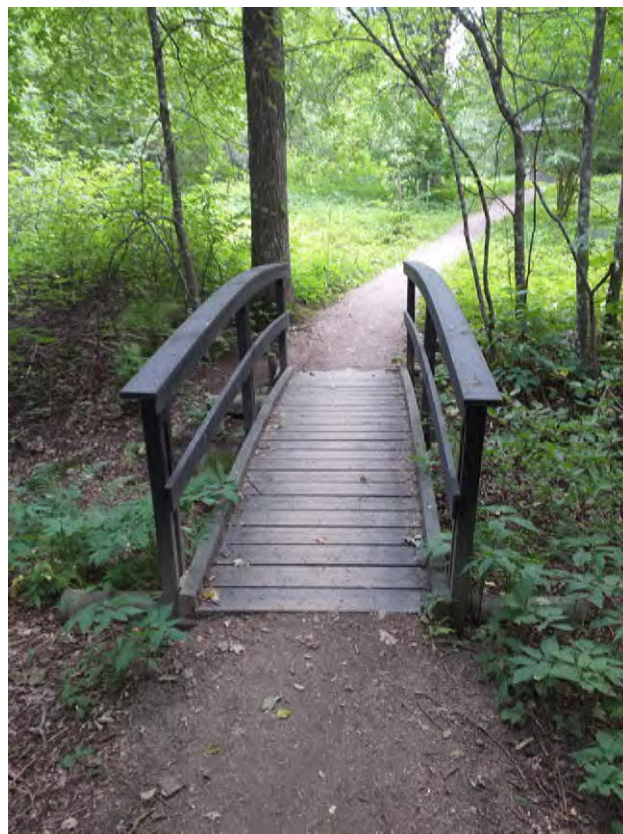
Kuva 22. Noron yli kulkevat puusillat ovat melko hyväkuntoisia.
