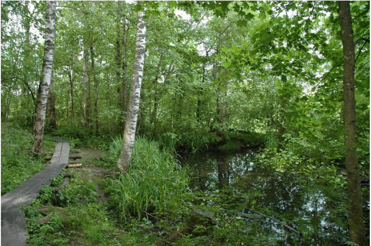
Kuva 23. Lammen rantaa kulkevat pitkospuut ovat kohtalaisessa kunnossa, mutta muutamien kohdin aluspuut ovat lahonneet.
