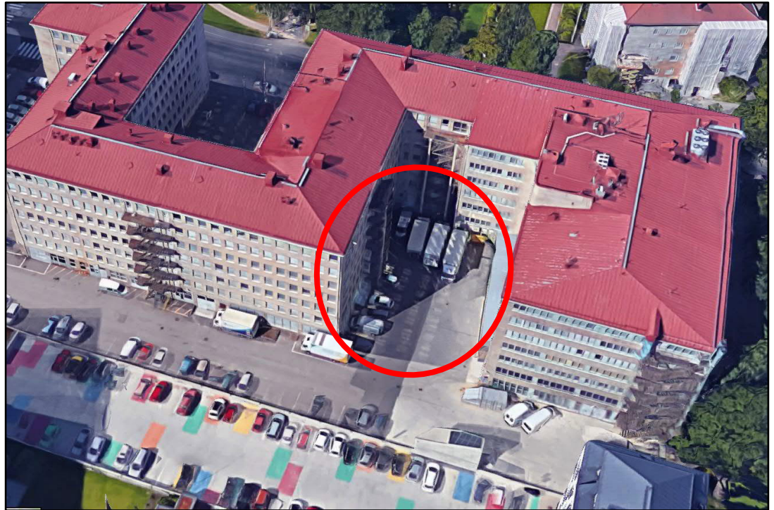
Kuva 6. Kohteen eteläpuolella sijaitseva lastauslaituri
