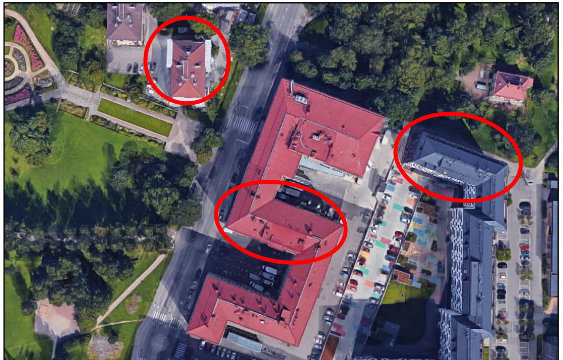
Kuva 4. Kohteen viereisten rakennusten katoilla sijaitsevat lähimmät LVIS-laitteet
