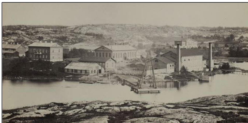
Fiskarsin konepaja (myöhemmin J. D. Stenberg ja Pojat) Hakaniemenrannassa kuvattuna Siltavuorelta 1860-luvun puolivälissä. Taustalla näkyy tulevan Torkkelinmäen alueen vielä rakentamattonta kallioista maastoa. Kuva: Carl Adolf Hårdh. Helsingin kaupunginmuseo.
