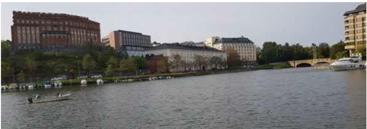
Kuva 3-16: Pitkäsillan ranta (kuva Ramboll).
