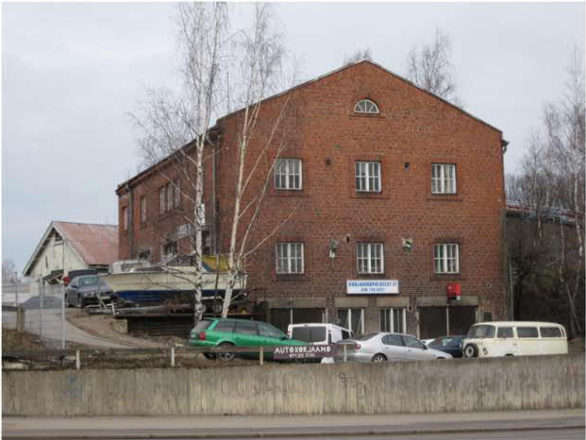
Suojeltava tiilirakennus osoitteessa Hiilloskuja 5.
