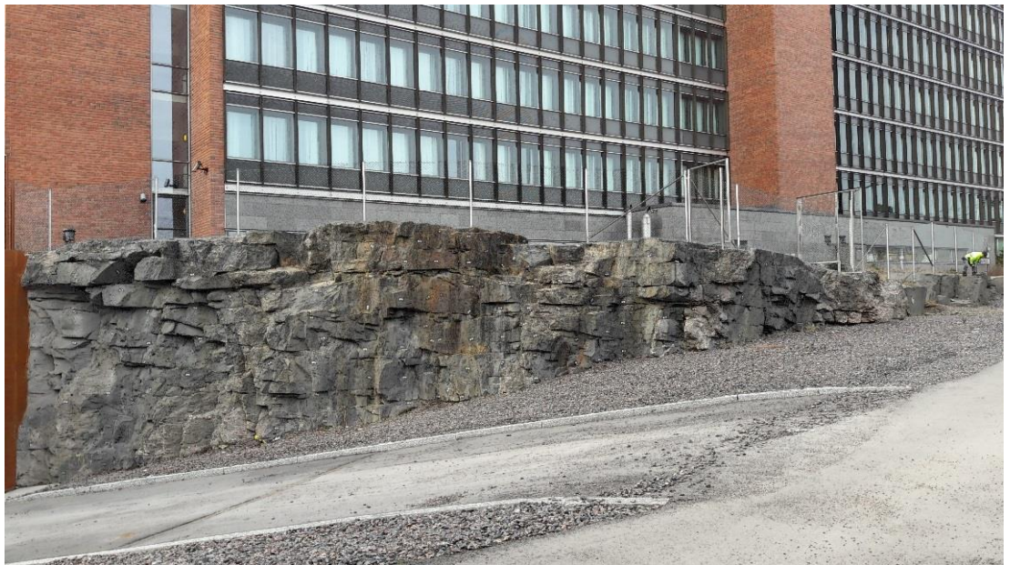
Kuva 63. TIN$-2018-14. Migmatiittinen tieleikkaus Ruoholahdessa (P = 6672499 m, I = 25495008 m). Leikkauksessa on n. 15 % pegmatiittia lähes yhdensuuntaisina, valkoisina ja vaaleanpunaisina n. 1 m leveinä juonina. Selkeää vaakarakoilua nähtävissä.
