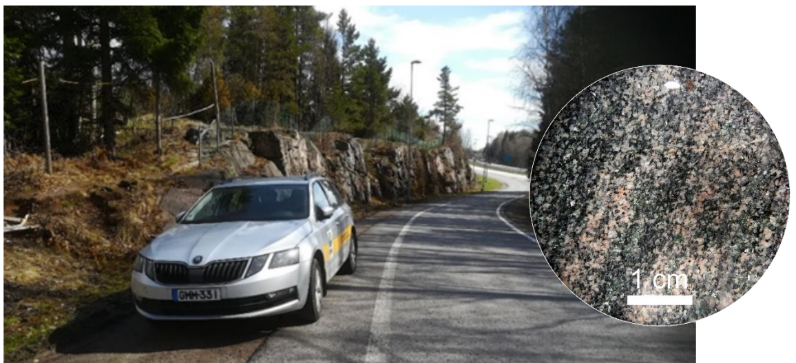
Kuva 48. TIN$-2018-46. Noin 50 m pitkä kalliroleikkaus Porvoon väylän varrella (P = 6683460 m, I = 25510026 m). Uppokuva on märestä näytekiekosta. Uppokuvassa valotusta on hieman nostettu, jotta kiven tekstuuri näkyisi selkeämmin.
