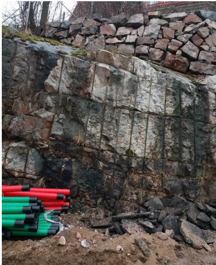
Kuva 13. Havainnon TIN$-2018-012 tieleikkaus, jossa graniittisessa kivessä on havaittavissa haamumaisia biotiitti- rikkaampia osueita. Kuvassa näkyvät tummemmat laikut kivessä on pääasiassa pintalikaa. Pasila, Veturitie (P = 6675609 m, I = 25496096 m).
