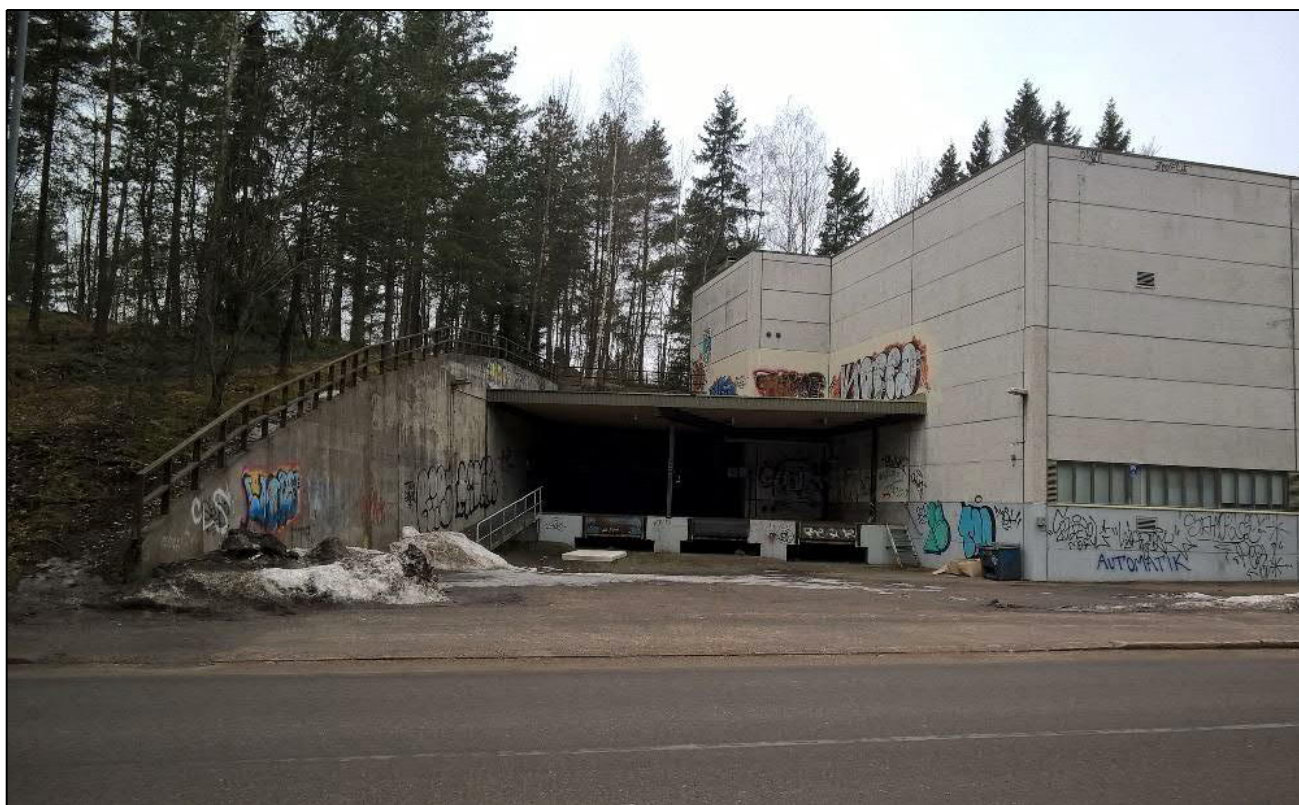
Isku Invest Oy:n tyhjiillään jääneen varastorakennuksen tontti on louhittu kallioon.
