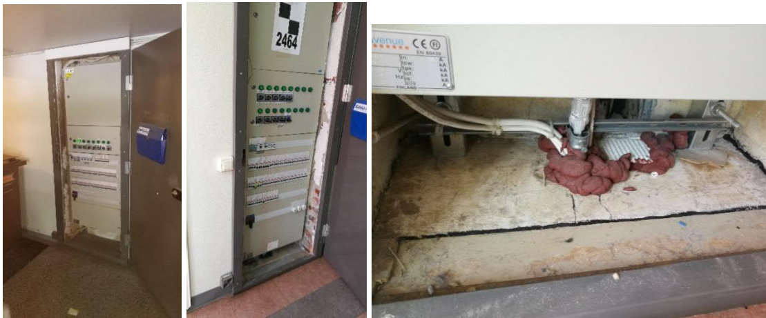
Kuva 2 a-c. Ryhmäkeskukset sijaitsevat eri kerroksissa päällekkäin. Alin sijaitsee pohjakerroksessa (maantaso) ja sen lattiapinta oli yhtenäinen (a), läpivientejä kellarikerrokseen ei ole. Välipohjien läpiviennit oli tulpattu palokatkotuottein lattiapinnastaan kaikissa ryhmäkeskuksissa. Kuvassa b RK2.1 ja kuvassa c RK3.1. lattian läpivientien tiivistys palokatkomassalla. Merkkisavulla ei todettu ilmavirtausta yhdestäkään ryhmäkeskuksesta huonetiloihin suuntaan eikä ilman liikettä läpivientien kohdalla. Ryhmäkeskukset ovat pääasiassa rakennusainepinnoilla ja niissä on jonkin verran pölyä. Niistä ei aistittu normaalia poikkeavia hajuja.
