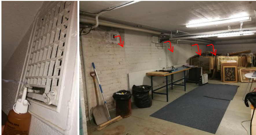
Kuva 1 a-c. Bänditilassa hormin ilmavirtauksen suunta vaihteli eri tutkimuspäivinä, ilmavirtauksen suuntaus riippuu todennäköisesti vallitsevasta tuulensuunnasta. Tiiliverhoillun maanvastaisen seinän tuuletusräppänöistä puhalsi ilmaa bänditilaan tuulensuunnasta riippumatta (nuolet). Seinärakenne on suunniteltu tuulettuvaksi tuuletusaukkojen kautta.
