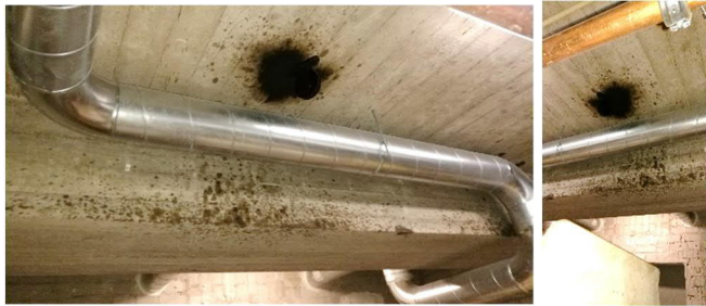
Kuva 5 a, b. Kellarin yhdessä varastotilassa todettiin öljyriskeita katto- ja seinäpinoilla. Öljyriskeet eivät vaadi toimenpiteitä nyt, mutta peruskorjauksessa ne vaikuttavat korjaustapojen ja menetelmien valintaan sekä purkujätteen käsittelyyn. Tila on merkitty liitteen 1 pohjakuviin.
