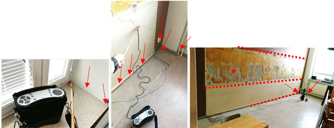
Kuva 8 a, b. Luokkatilasta 20 todettuja pistemäisiä ilmavuotokohtia. Välipohjaan las-kettu merkkiainekeasu kulkeutui väliseinän tasoitteessa poistetun kaapin kohdalla aina purkurajan yläosaan asti. Kuviin on myös merkitty punaisiin nuolin ja katkoviivoin ilma-vuotokohtia.
