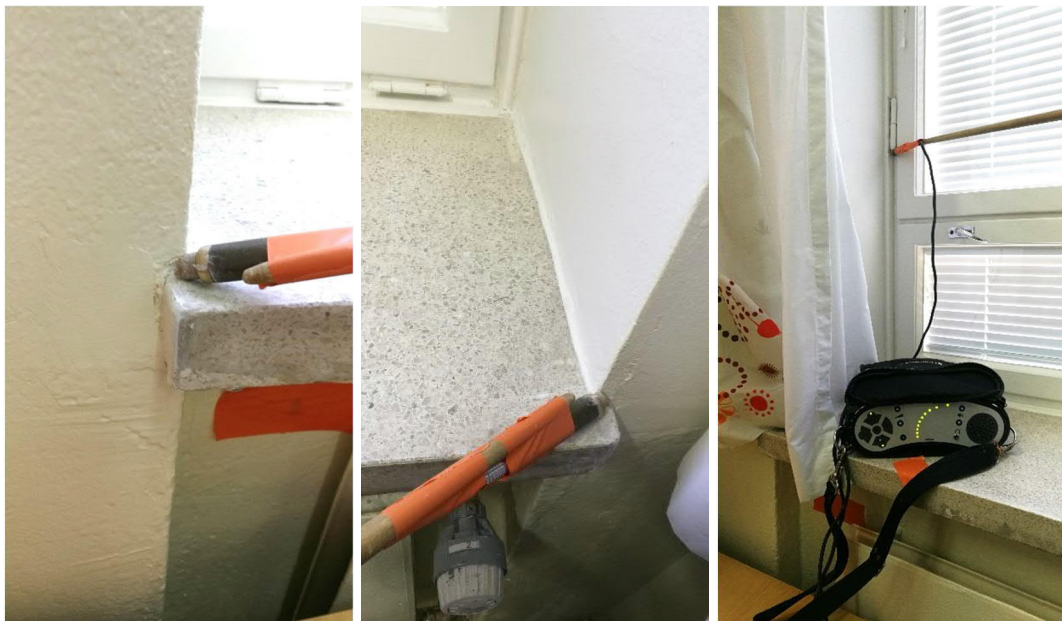
Kuva 9 a, b. Muutamia luokkatilassa 22 todettuja pistemäisiä ilmavuotokohtia ikkunoi-den ympärillä.
