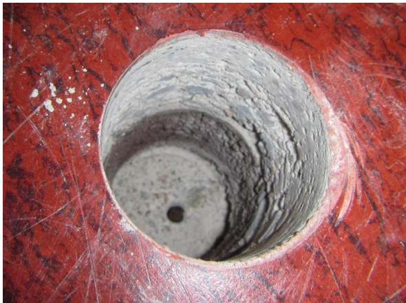
Kuva 37. Rakenneavaus RAK VP3
