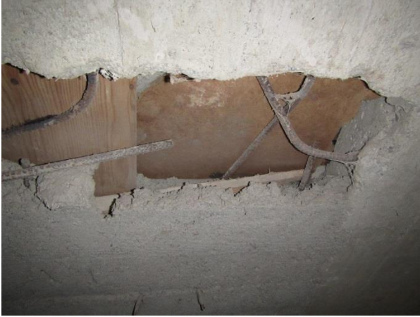
Kuva 10. Vanha läpivientikohta alapohjarakenteessa
