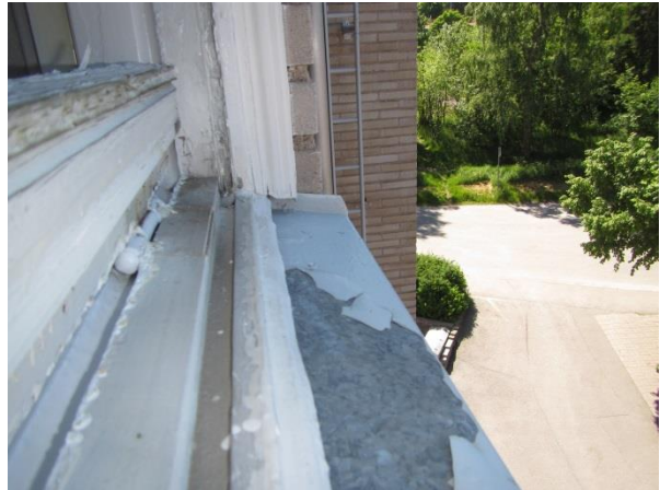
Kuva 18. Koulurakennuksen ikkunapeltien kaltevuus ei ole riittävä. Ikkunapeltien maalipinta irtotlee.
