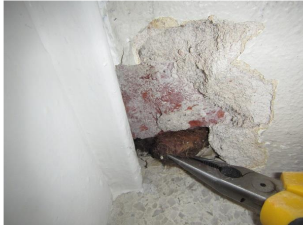
Kuva 33. Ikkunariveen näytteenotto
