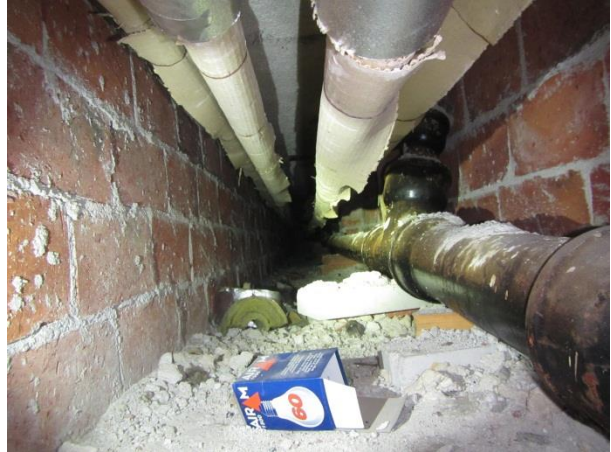
Kuva 7. Musiikkiopistorakennuksen maanvastaisen alapohjan alueella on poikkisuuntaisia putkikanavia.
