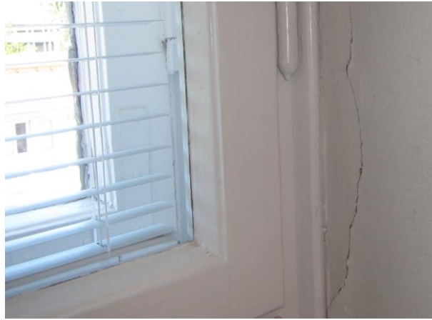
Kuva 22. Ikkunapielien rappauksessa on paikoin halkeamia ja kopoalueita
