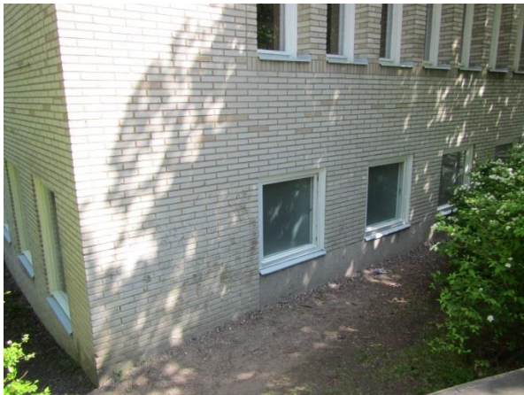
Kuva 15. Musiikkiopiston pohjakerroksen ulkoseinät ovat osittain maanvastaisia
