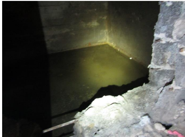
Kuva 13. Lämmönjakohuoneen hiilikuilun pohjalla oli vettä
