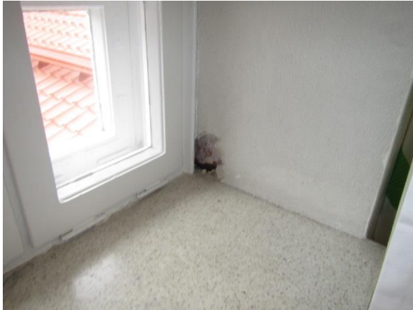
Kuva 32. Ikkunariveiden näytteenotto varten ikkunanpieleen tehtiin reikä
