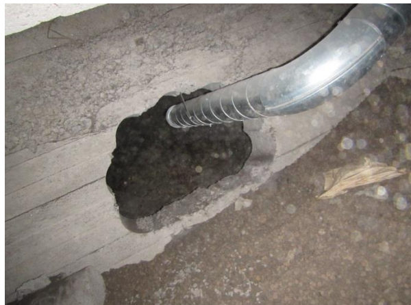
Kuva 9. Ryömintätilassa oleviin seinämiin on tehty jälkikäteen reikiä koneellisen poistoilmanvaihdon tehostamiseksi
