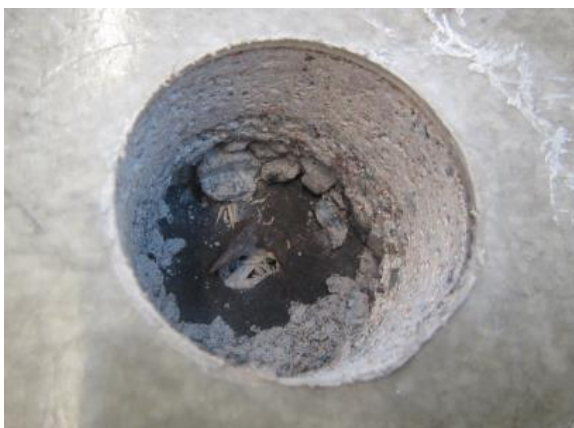
Kuva 38. Rakenneavaus RAK VP4
