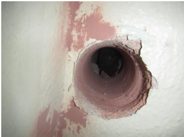
Kuva 29. Rakenneavaus RAK US5
