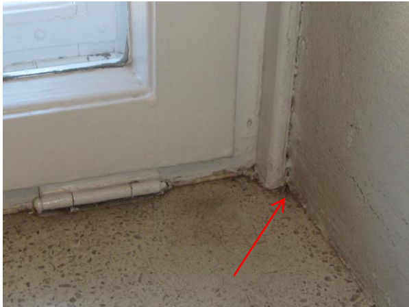
Kuva 21. Ikkunaliittymissä on nähtävissä epätiiveydenkohtia
