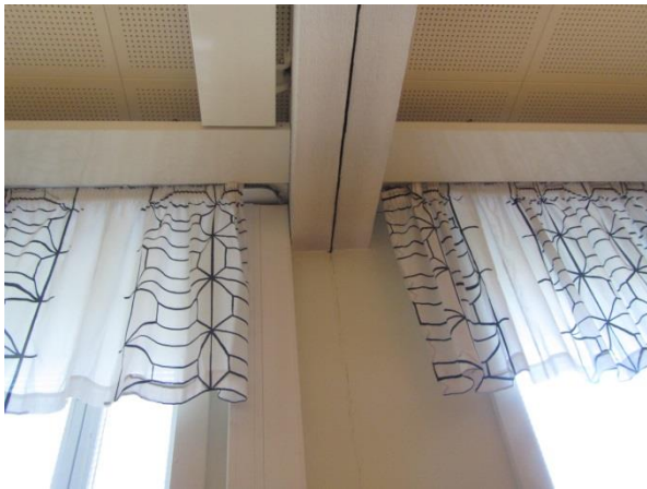
Kuva 23. Koulurakennuksen rungossa on liikuntasäilytysluokan ja luokan 20 kohdalla
