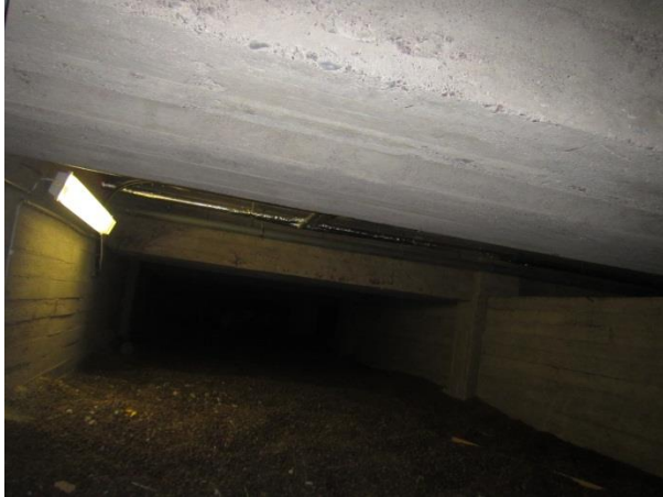
Kuva 6. Musiikkiopistorakennuksen alapohja on osittain ryömintätilallinen
