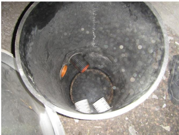
Kuva 1. Salaojan tarkastuskaivo musiikkiopiston ryömintätallassa
