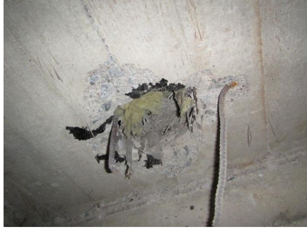
Kuva 11. Vanha läpivientikohta alapohjarakenteessa
