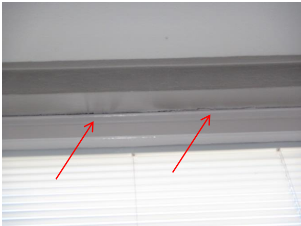
Kuva 19. Ikkunaliittymissä on jälkiä ilmavuodoista rakenteesta sisäilmaan.
