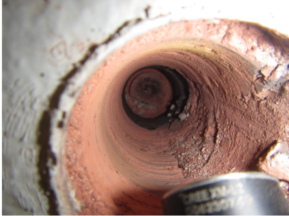
Kuva 28. Rakenneavaus RAK US4
