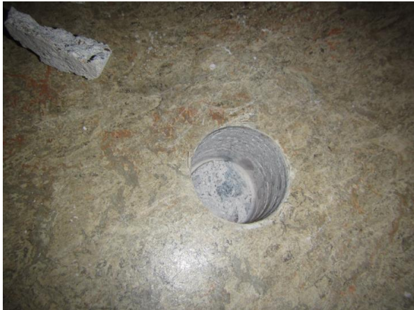
Kuva 36. Rakenneavaus RAK VP2
