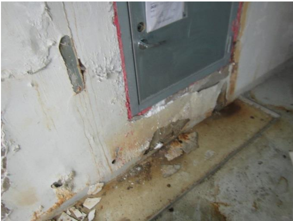
Kuva 12. Lämmönjakohuoneen seinien alaosissa on liiallisesta kosteudesta aiheutuneita tasoite- ja maalipintavaurioita.
