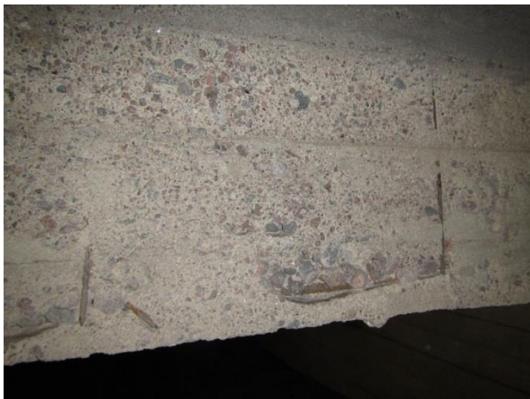
Kuva 8. Kantavan alapohjapalkin teräksiä oli rakenteen pinnassa monin paikoin musiikkiopistossa
