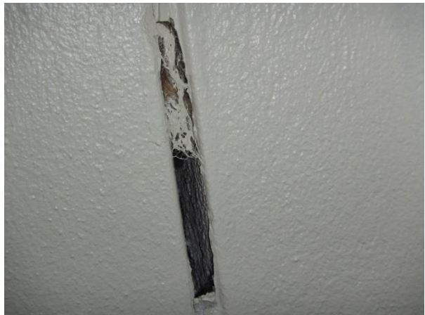
Kuva 24. Liikuntasäilytysluokan massaus irtoilee paikoin ulkoseinässä paljastaen ilmavuotoreitin rakenteesta sisäilmaan
