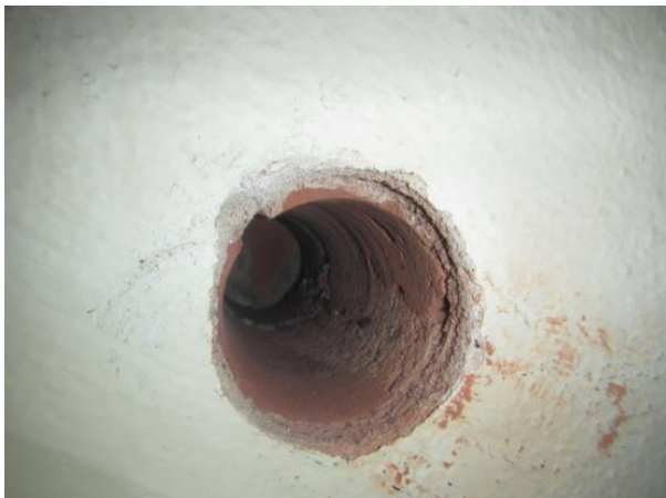
Kuva 30. Rakenneavaus RAK US6
