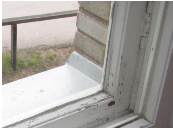
Kuva 16. Musiikkiopiston ikkunapellit ovat lähes vaakatasossa
