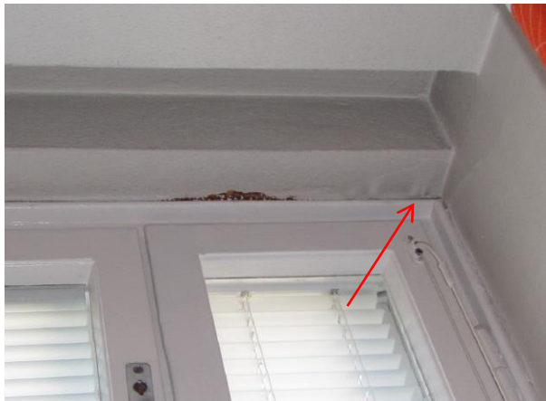
Kuva 20. Ikkunaliittymissä on jälkiä ilmavuodoista rakenteesta sisäilmaan
