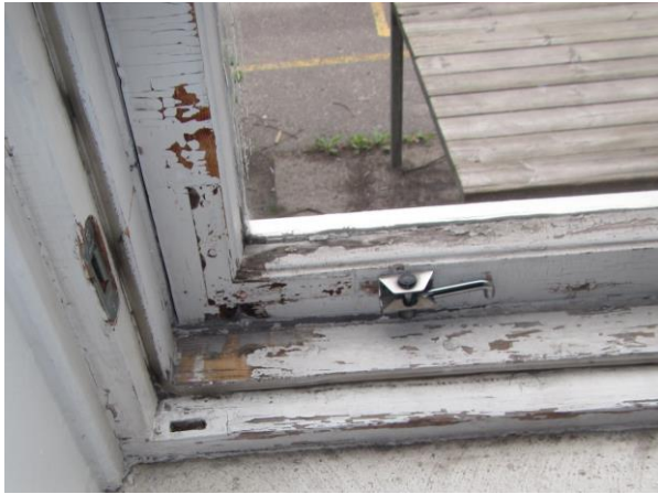
Kuva 17. Ikkunoiden sisäpuitteiden kaikki reunat on tiivistetty, jolloin korvausilmaa ei virtaa puitteiden ja karmien välistä
