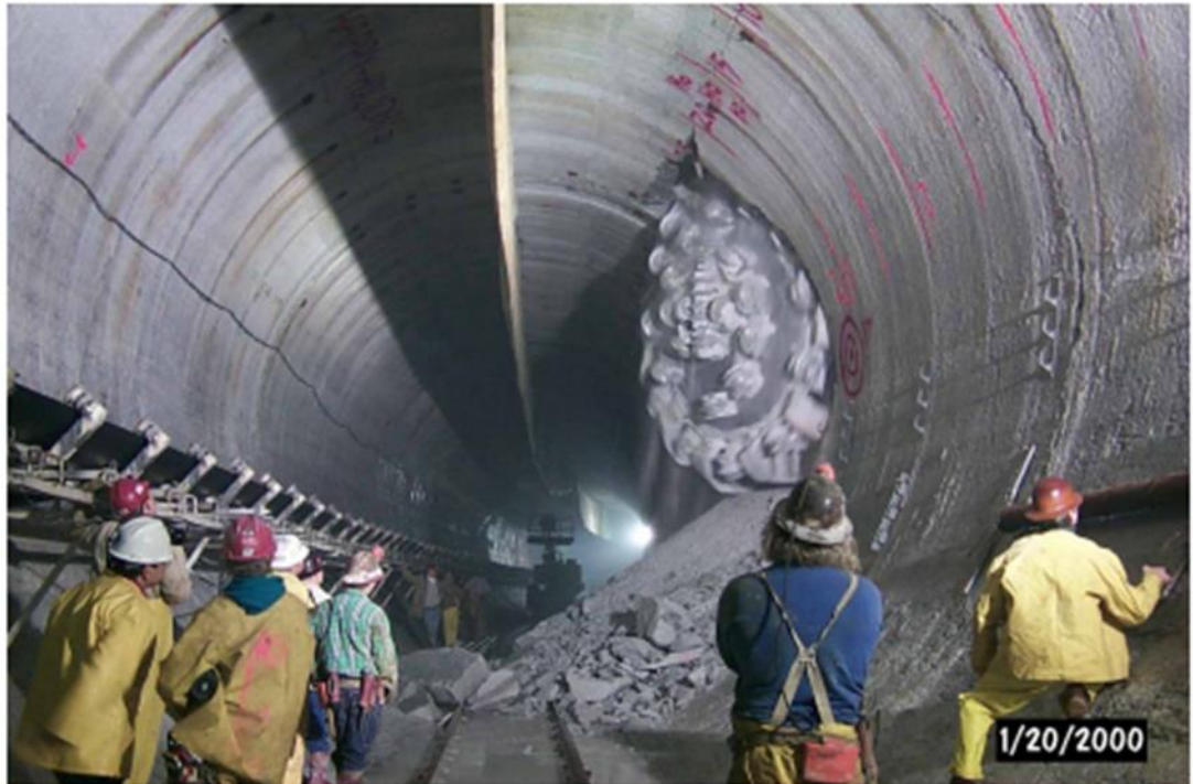
Kuva 5-1. Täysprofiilikone (Robbins TBM) on jyrsimässä tunnelia Chicagossa USA:ssa. Kuvassa näkyvät jyrsinporakoneen leikkauspäät ovat puhkaisseet yhteyden päätunneliin, joka on tehty TBM-menetelmällä. Lähde: Lach ym. 2000
