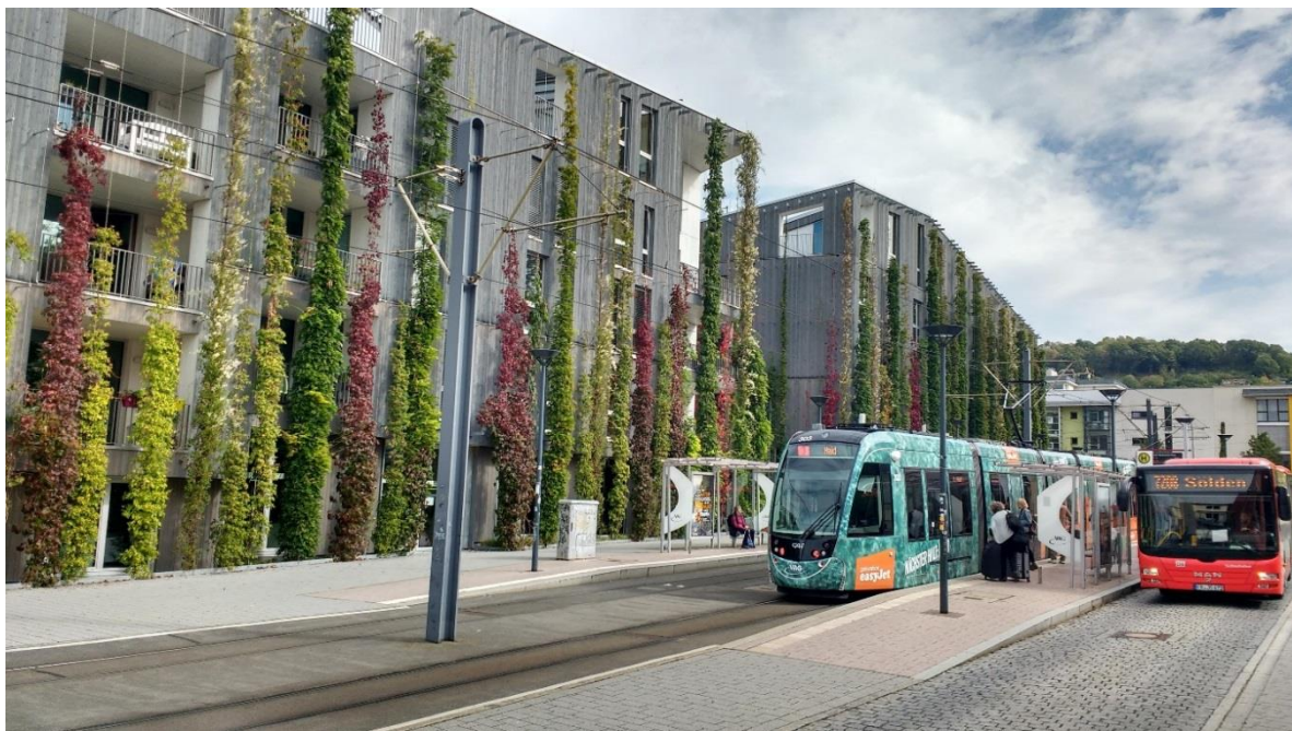
Kuva 57. Kuvituskuva ratikasta ja rakennetusta vihreästä infrastruktuurista (Saksa, Freiburg, Vaubanin asuinalue 2018)
