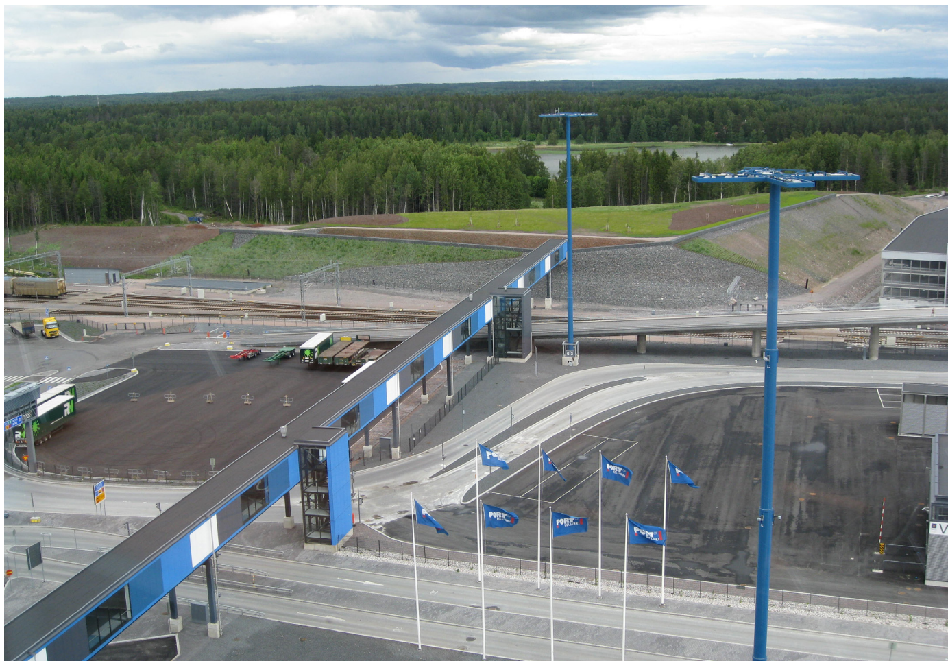
Kuva 17. Yleiskaavan toteuttamisen myötä Vuosaaren sataman vierelle sijoittuu uusi kaupunginosa. Nykyinen näkymä kohti Porvarinlahtea.
