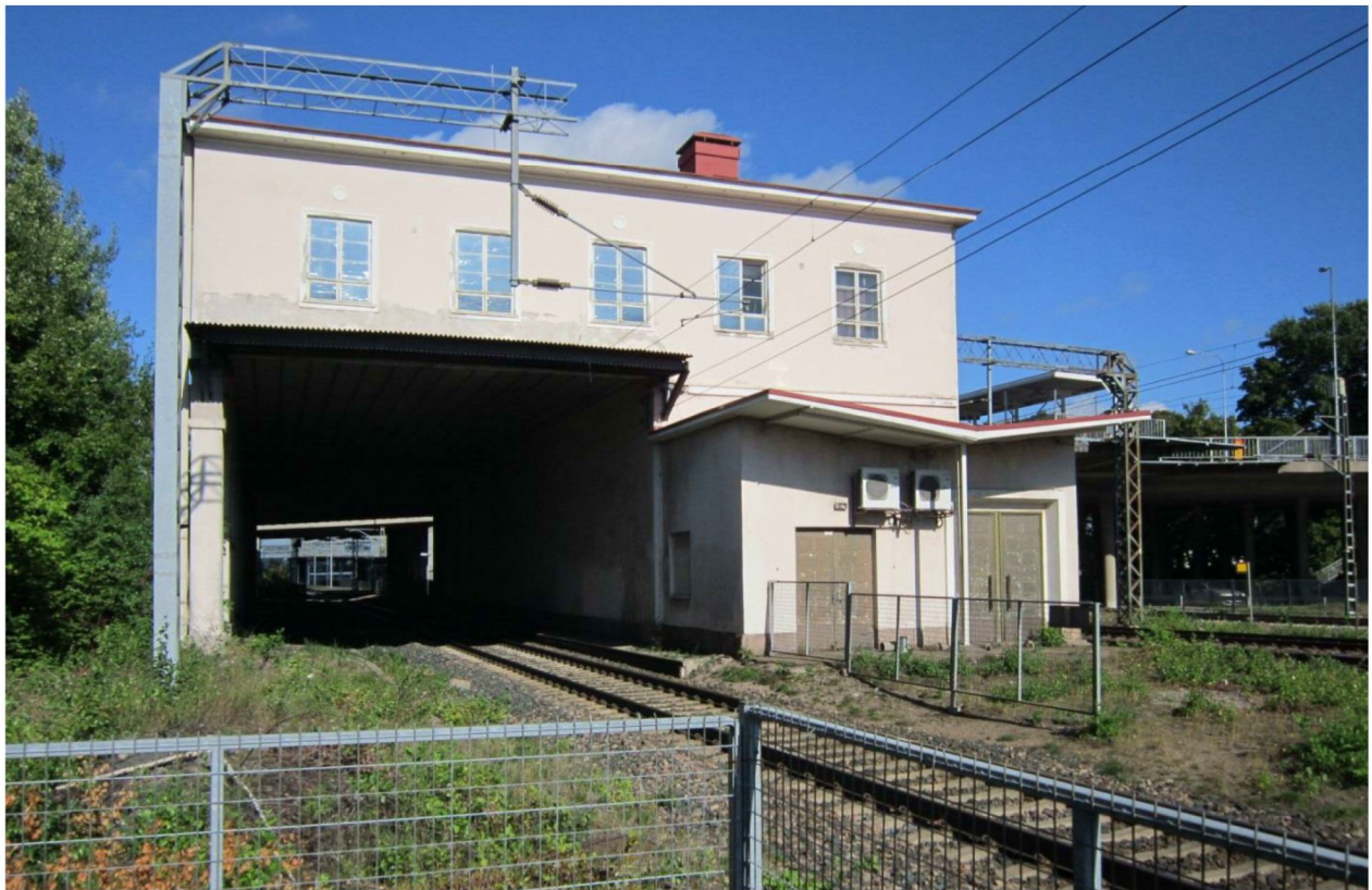
Junaraide kulkee vanhan asemarakennuksen läpi
