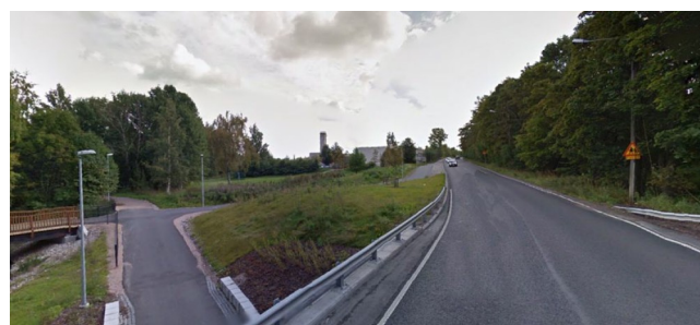
Kuva 2. Näkymä Latokartanontieellä sillalta etelään. Kuvaaja:
