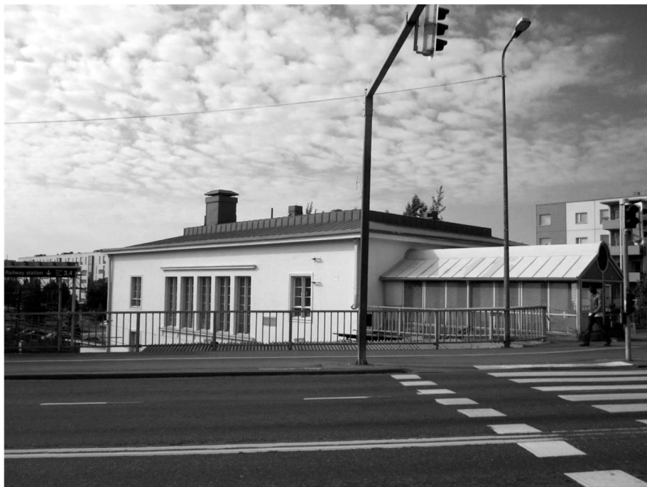
Näkymä asemalaiturilta, oleva porraskatos (©HKR)
