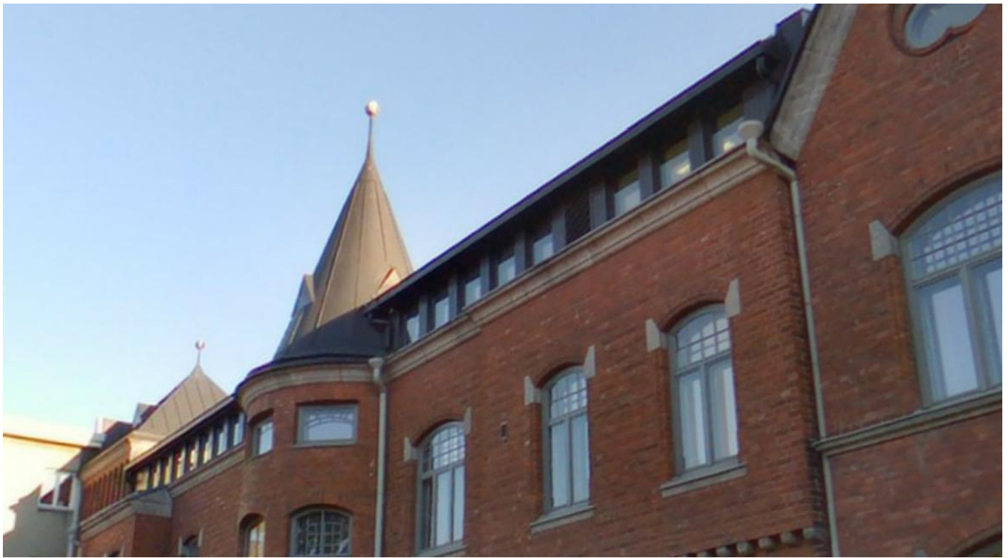
Tähtitorninkatu 16:n puolella kattoa on korotettu vuonna 1945. Muilta osin kattomuoto vastaa alkuperäistä. Kate on uusittu v. 2010.
