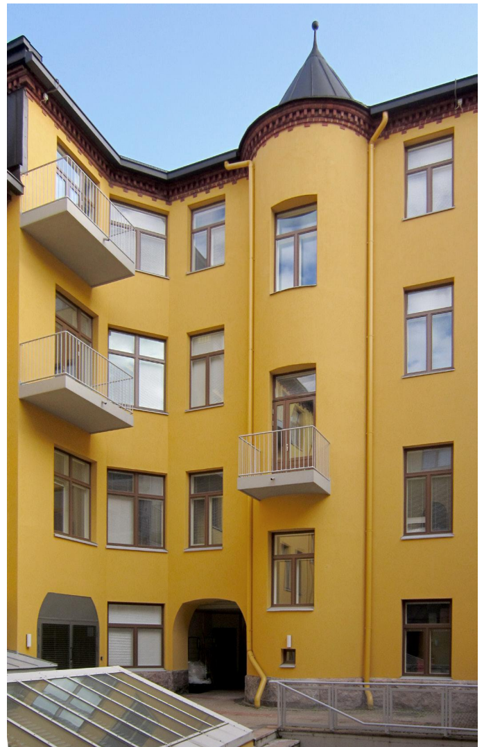
Pihajulkisivun ikkunat ja parvekkeet on uusittu ja pinta lämpöräpattu vuonna 2013. Asemakaavan suojelumerkintä koskee myös pihajulkisivua, mutta siihen voidaan helpommin tehdä harkittuja muutoksia. Esimerkiksi uusien teräspinnakaideparvekkeiden rakentaminen on sallittua.
