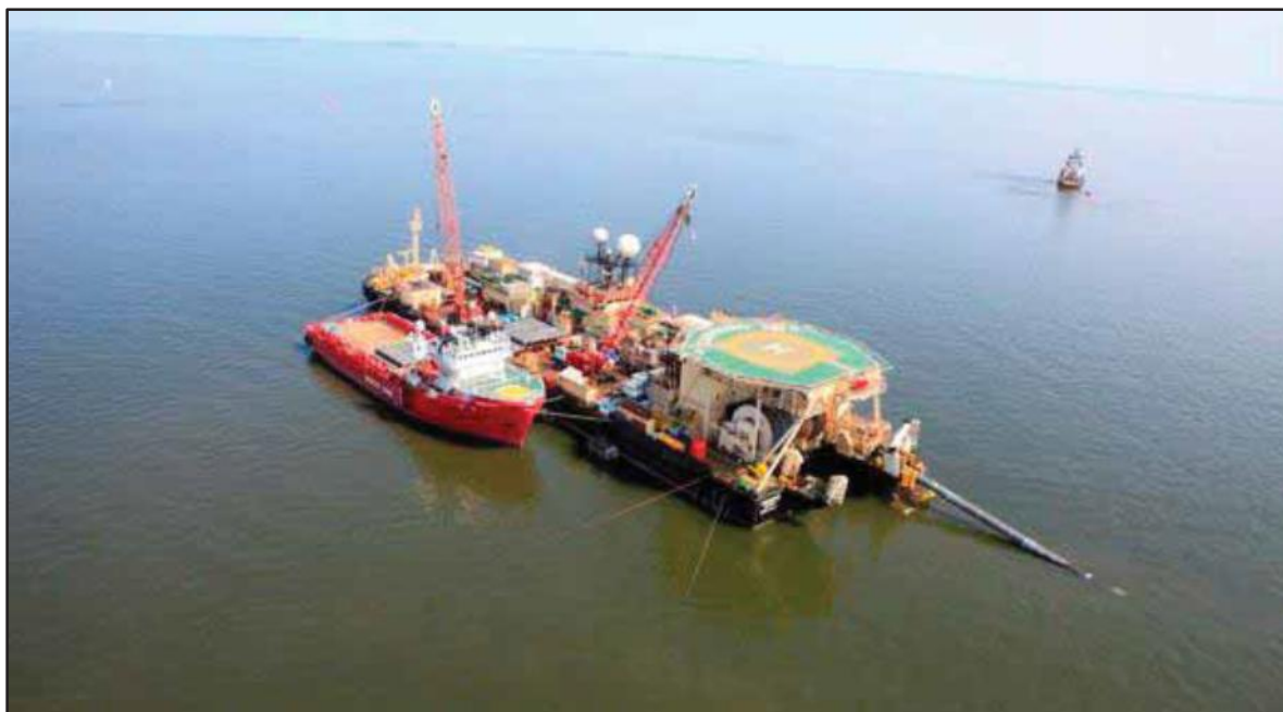
Kuva 6-22 Tyypillinen matalan veden alueilla käytettävä putkenlaskualus (sekä ankkuria käsittelevä hinaaja ja putkenkuljetusalus).
