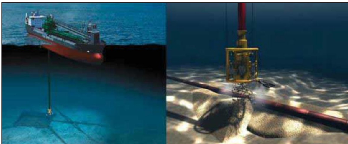
Kuva 6-17 Kiviaineksen läjitys merenpohjaan laskuputkea käyttämällä.
