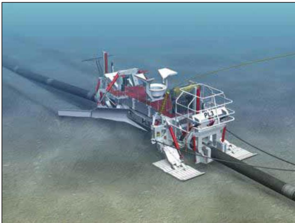
Kuva 6-15 Putkiaura toiminnassa merenpohjalla.
