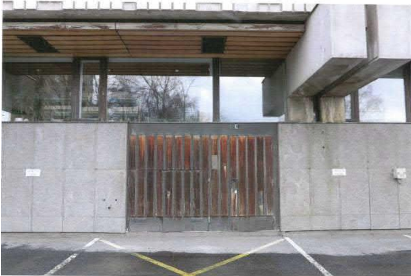
Pihakannen ulko-ovi ja seinän graniittilaatta verhous
