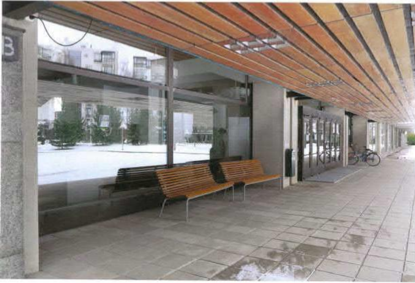
Sisäänkäyntikatos ja tuulikaappi
