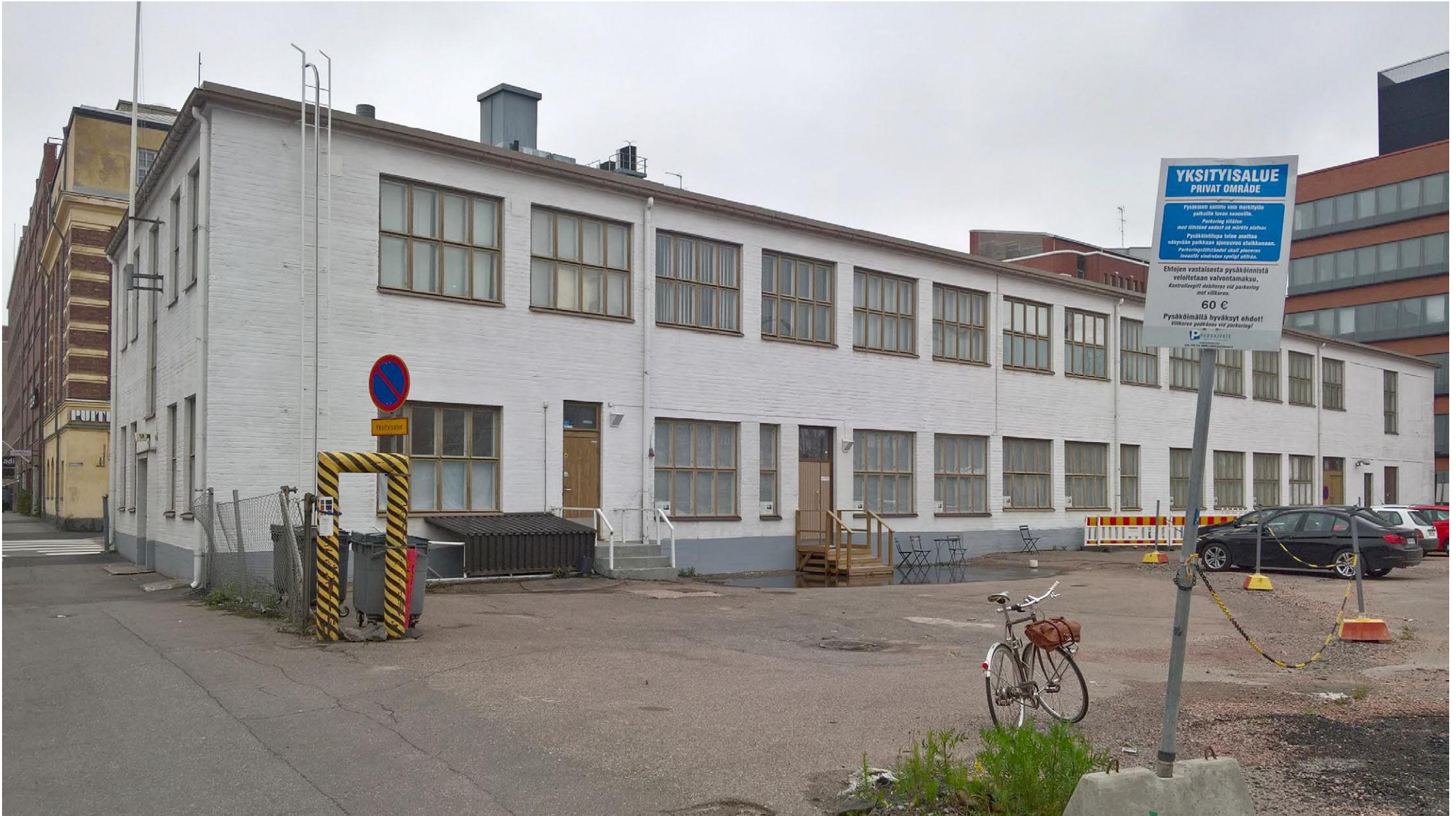
Asemakaavan muutosehdotus nro 12390, kuvaliite suojelukohteesta Taiteilijatalo osoitteessa Verkkosaarenkatu 1 / Vanha Talvitie 9 etelästä kuvattuna
