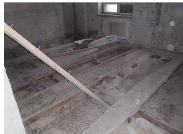
Kuva 8. Osassa toisen kerroksen tiloista välipohjan palkit ovat näkyvissä. Palkeissa oleva eriste on kiinnitetty PAH-yhdistepitoisella bitumisivelyllä.
