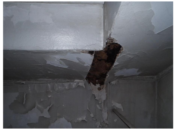
Kuva 10. Ullakkokerroksessa on muutamia kosteusvauriokohtia.
