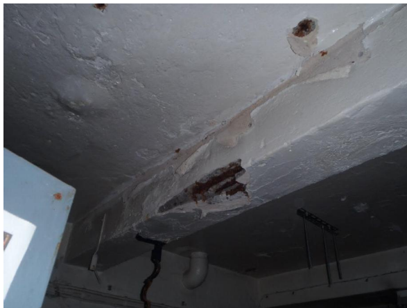
Kuva 9. Kattopalkin pääteräkset ovat pahoin ruostuneet.
