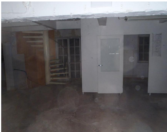
Kuva 4. Kevytrakenteisten toimistokoppien seinälevyt sisältävät asbestia .
