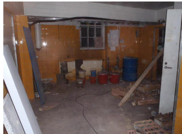
Kuva 5. Oranssin keraamisen laatan saumalaasti sisältää asbestia .
