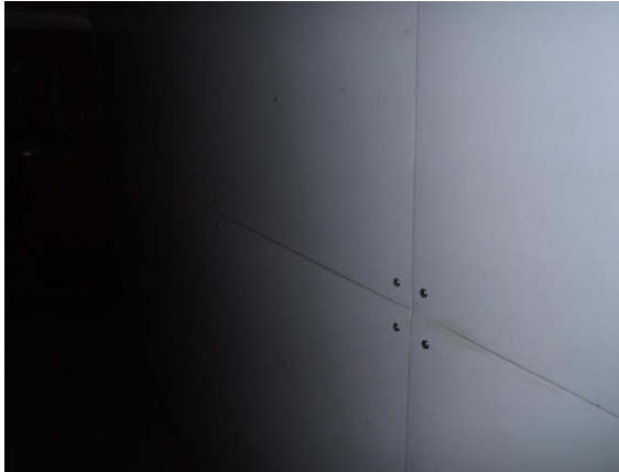
Kuva 2. Näyte M3. 1. kerroksen käytävän seinässä on kuitusementtilevyjä, jotka sisältävät asbestia .
