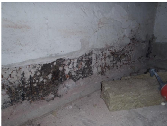
Kuva 7. Seinien alaosissa oleva korkkieristys on kiinnitetty PAH-yhdistepitoisella bitumisivelyllä.
