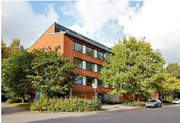
RUUSUTARHANTIE 2, arkkitehti Eino Tuompo 1961.
