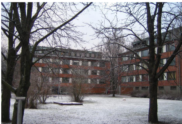
RUUSUTARHANTIE 4, arkkitehti Eino Tuompo 1959.
