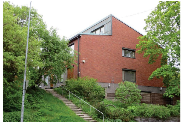
RUUSUTARHANTIE 7, arkkitehti Eino Tuompo 1959.
