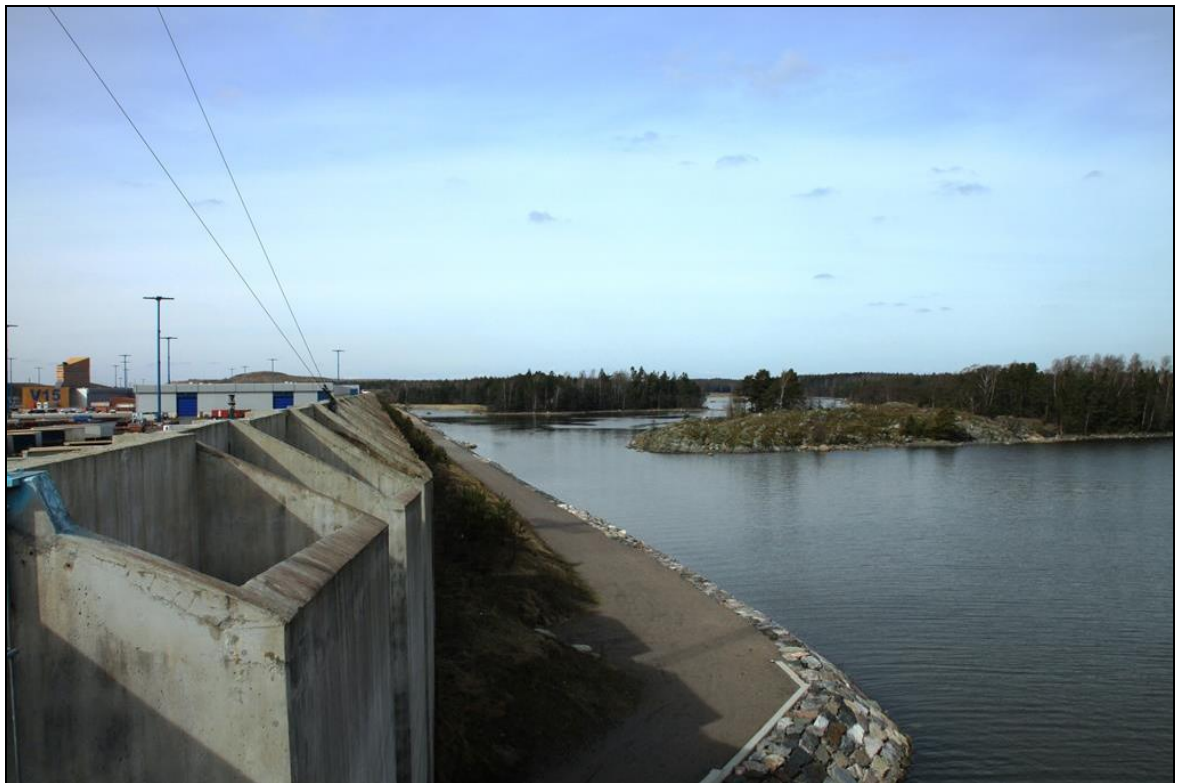
Kuva 6. Vuosaaren sataman melumuuri, joka suojaa Porvarinlahden Natura-alueetta satamamelta. taustalla oikealla lintujen suosima Kalkkisaari. (Kuva: M. Vähäkäkelä).
