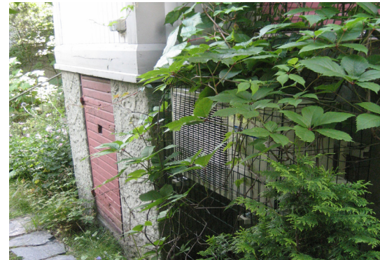
Ilmalämpöpumpun huomaamaton sijoitus ja laitteen yksinkertainen suojaus köynnösrutilän avulla Tapanilassa sijaitsevan pientalon pihajulkisivun sokkelissa.
