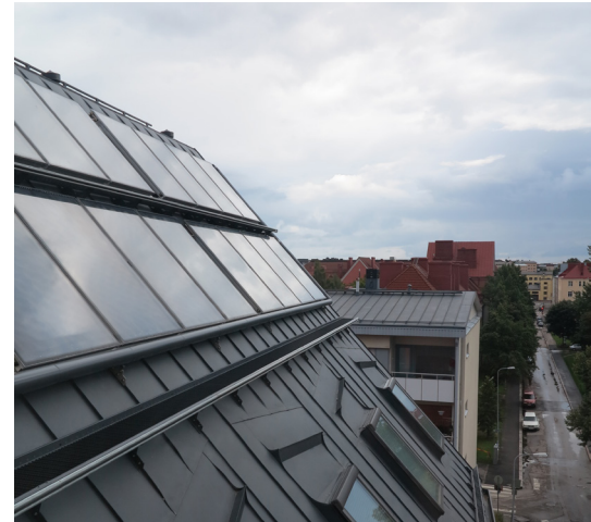
Useamman aurinkokeräimen muodostamat pinnat suunnitellaan osana kattopinnan sommittelua rakenteiden, putkitusten, johdotusten ja värien osalta.
