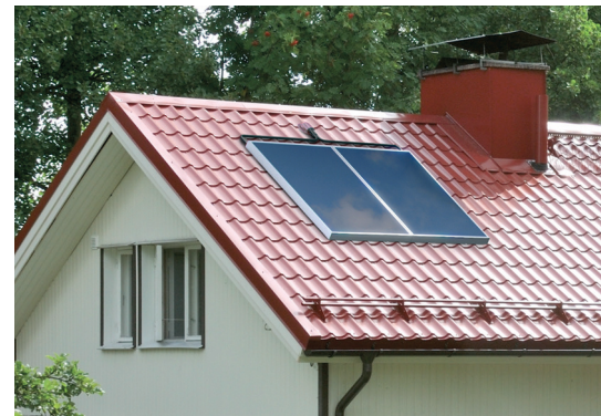
Pientalon aurinkolämpöjärjestelmään liittyvät keräinkentät on suositeltavaa sijoittaa pihanpuoleiselle katon lappeelle.
