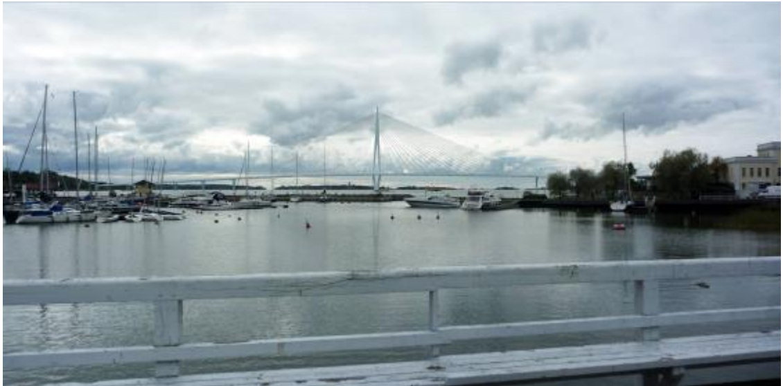
Kuva 62. Kruunuvuorensilta pohjoisesta Kulosaaren kasinon suunnalta. Pylonien korkeus on 135 metriä ja alikulkukorkeus 20 metriä. Havainnekuva näkymäanalyysi – selvityksestä (WSP Finland Oy, 2014).
