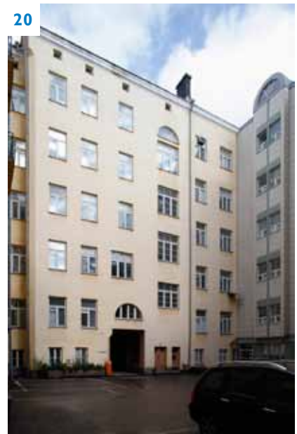
Vanhan ja uuden osan yhtymäkohta.
