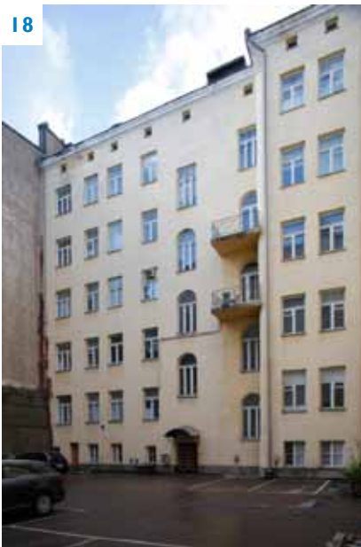
Rakennuksen länsisiiven sispihajulkisivu.
