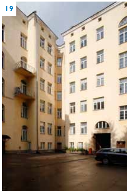
Länsi- ja pohjoissiipien kulman sisäpihajulkisivuja.
