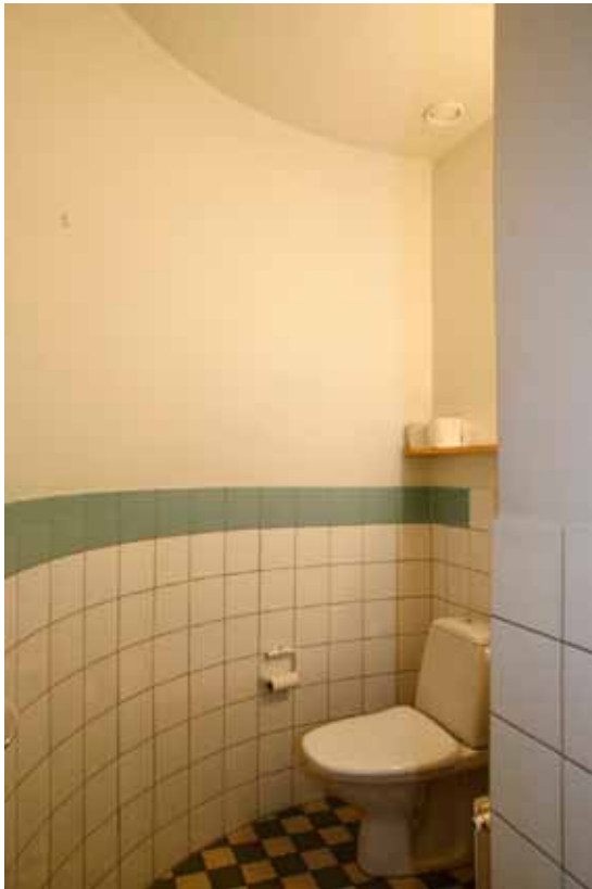
Vanhaan keittiöportaaseen on lisätty wc-tiloja 1987-1991.
