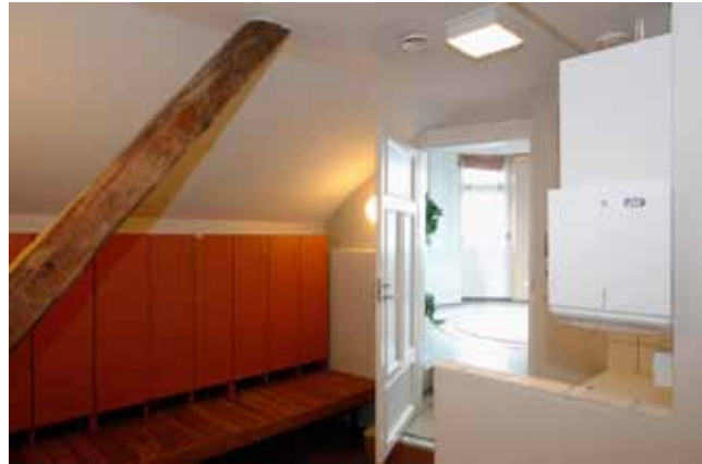
Pukuhuonetiloissa näkyy vanhoja hirsirakenteita.
