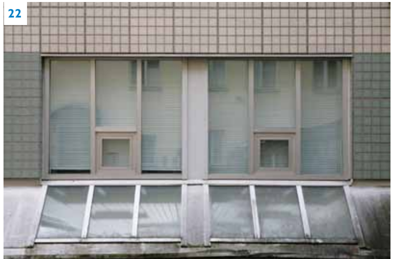
Uuden pihasiiven julkisivuote alumiini-ikkunoineen.
