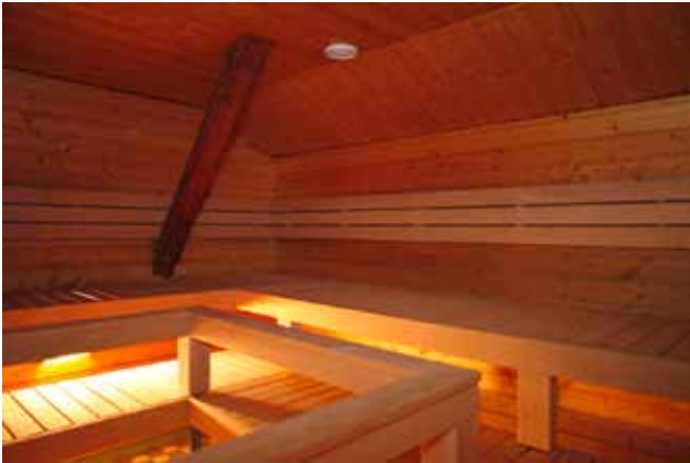
Ullakkokerrokseen on peruskorjauksen yhteydessä rakennettu sauna- ja takkahuonetilat.
