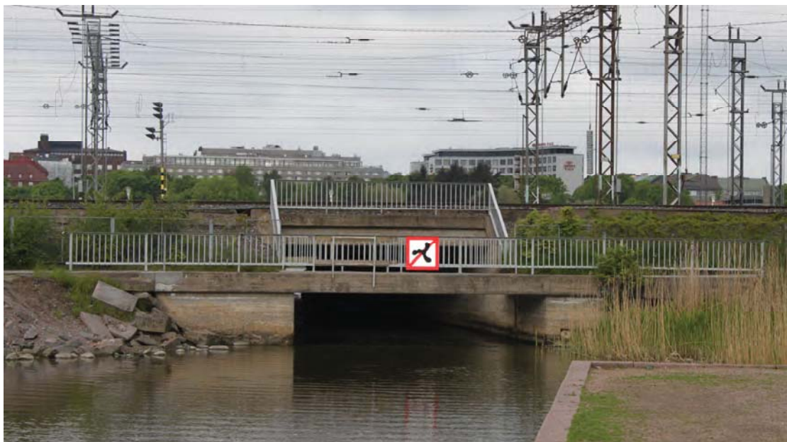
Kuva 2. Nykyinen silta idästä päin nähtynä.
