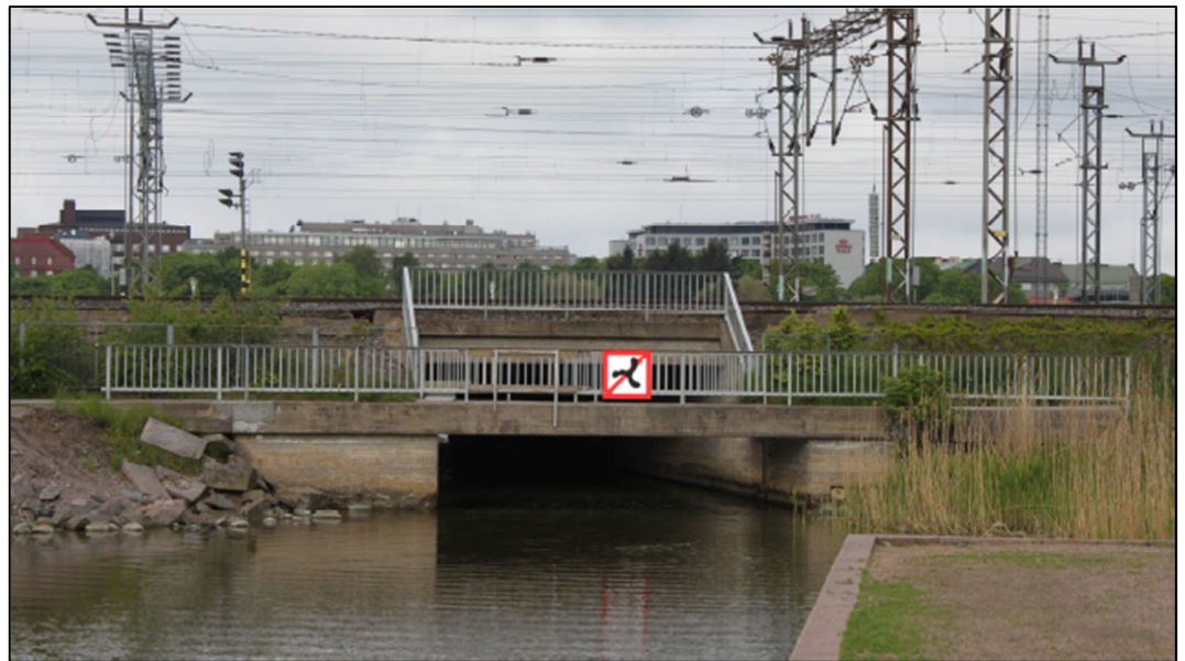
Kuva 2. Nykyinen silta. Kuvaussuunta idästä länteen. /Helsingin kaupunki, Rakennusvirasto, Katu- ja puisto-osasto. Töölönlahden tulvasuojelu. Kevyen liikenteen silta, tulvaportit ja tulvapumppaamo. Yleissuunnitelma. 13.7.2012./.
