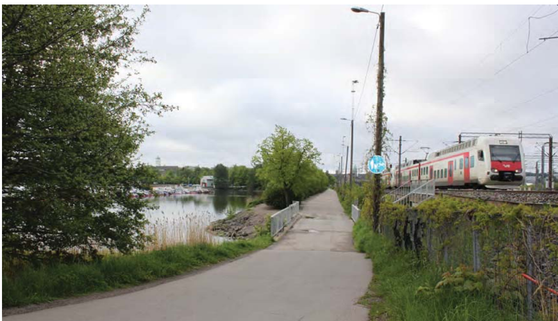
Kuva 3. Nykyinen silta pohjoisesta päin nähtynä.
