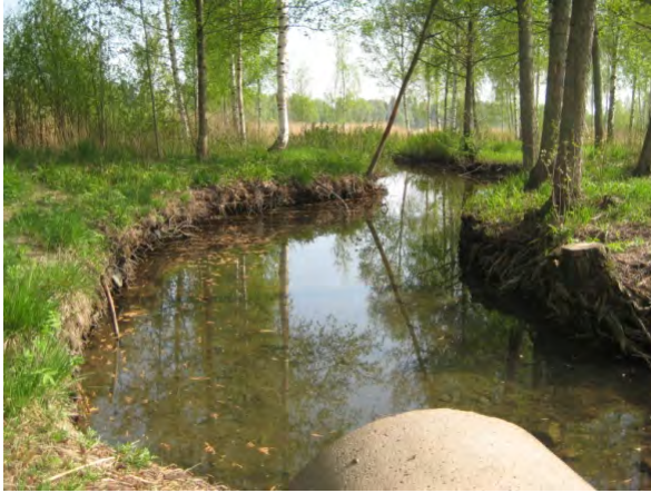
Kuva 12. Vartioharjun hulevesiviemäri. Kuva: Katja Pellikka.
