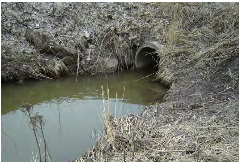
Kuva 21. Herttoniemen näytteenottoaikka hulevesiviemärin purkautumiskohdasta ojaan. Kuva: Paula Nurmi.
