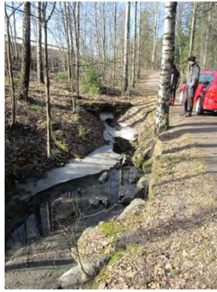
Kuva 24. Metsäläntien hulevesiviemäri. Kuva: Kajsa Rosqvist.
