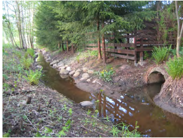
Kuva 9. Vartiokylän hulevesiviemäri. Kuva: Katja Pellikka.
